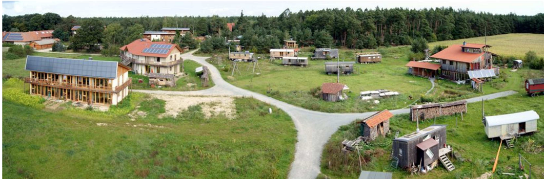
Şekil 3.24: Sieben Linden Ekoköyü Yerleşkesi – Libelle ve Brunnenwiese Yapılarının Bulunduğu Panoramik Görünüm (Kaynak: Url-39, Erişim Tarihi: 09.08.2013).
