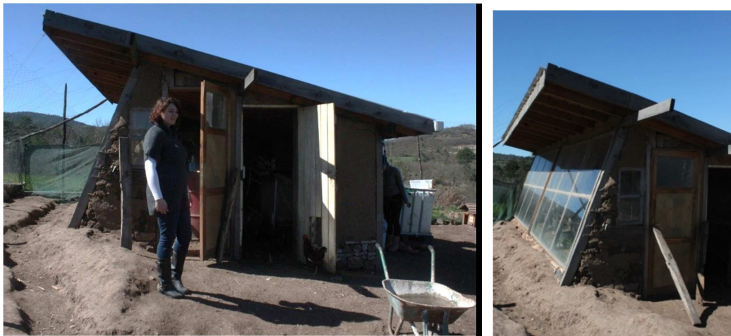
Şekil 3.54: Sera Ve Kümesin Birlikte Çözüldüğü Karma Kullanımlı Yapı (Yerleşke Ziyareti Sırasında Çekilen Fotoğraf, Oluşturulma Tarihi: 15.03.2014).
