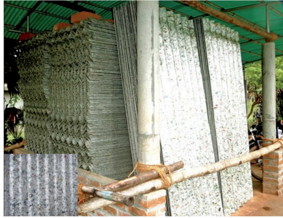
Şekil 3.3: Geri dönüştürülmüş Tetrapak’lardan Oluşturulmuş Oluklu Çatı Panelleri (Kaynak: Url-14, Erişim Tarihi:02 Ekim 2013).
