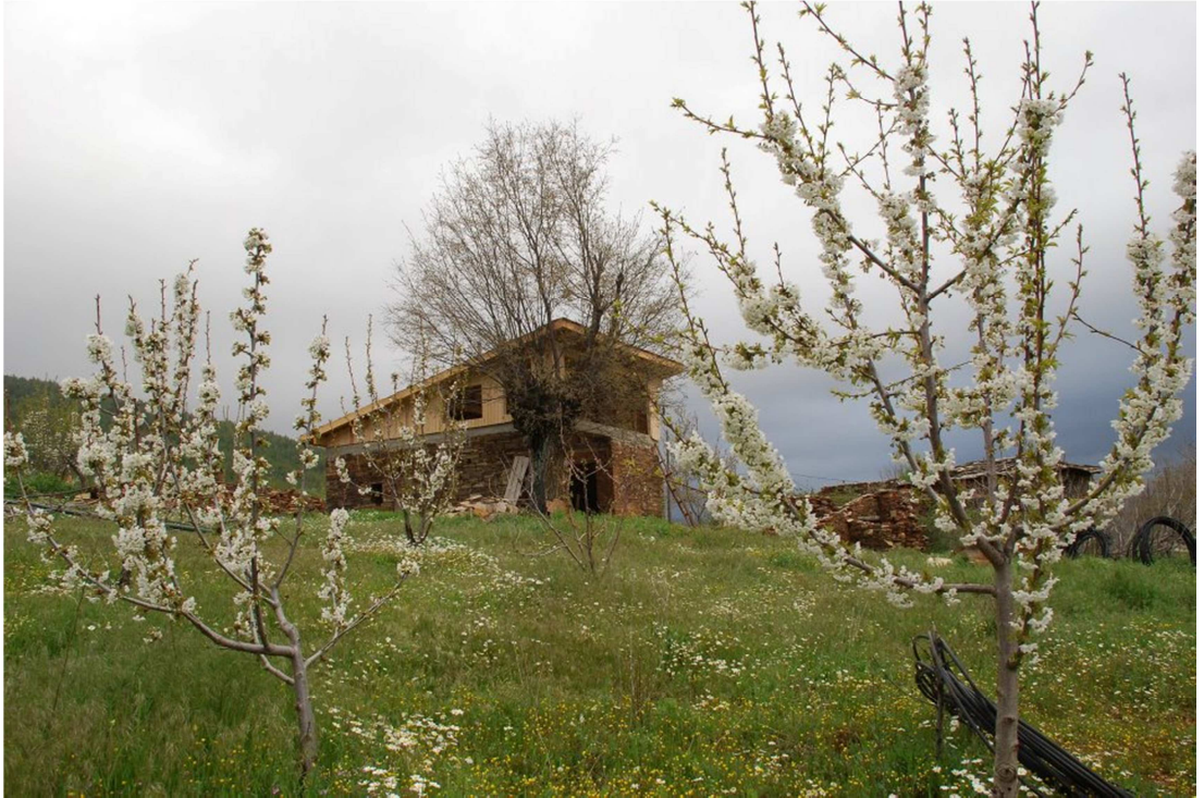
Şekil 3.52: Araştırma Enstitüsü Binası (Url-80, Erişim Tarihi: 17.02.2014).
