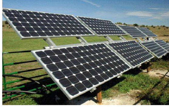
Şekil 3.44: Güneşköy Sera Otomasyonunda Kullanılan Güneş Enerjileri
