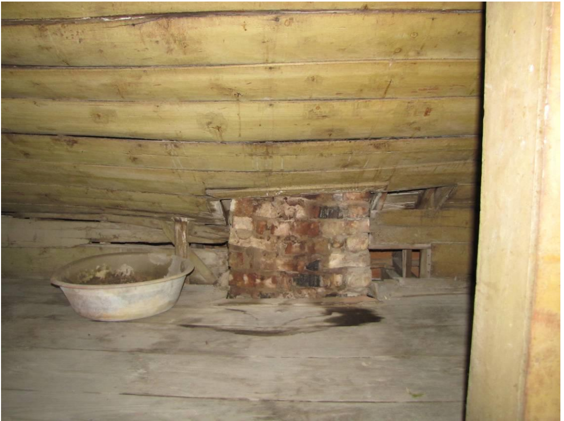
Şekil C.40: ÇK03 Çatı arası mekanında özgün baca.
