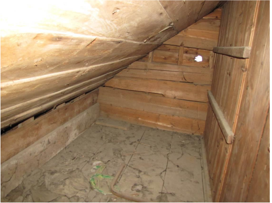
Şekil C.36: ÇK02 Çatı arası.
