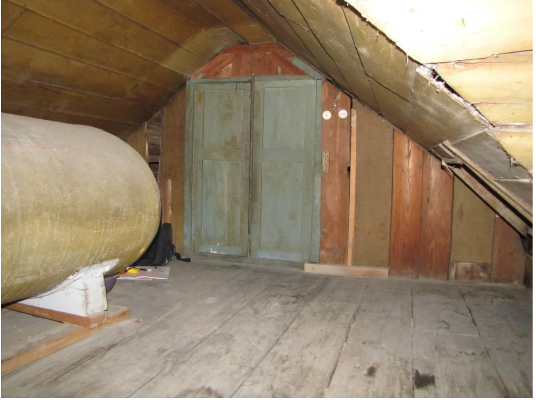
Şekil C.39: ÇK03 Çatı arası.
