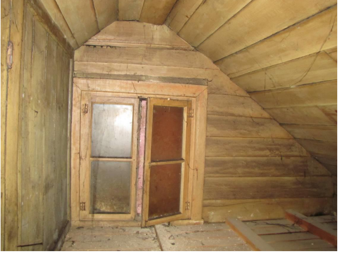
Şekil C.35: ÇK01 Merdiven boşluğu.
