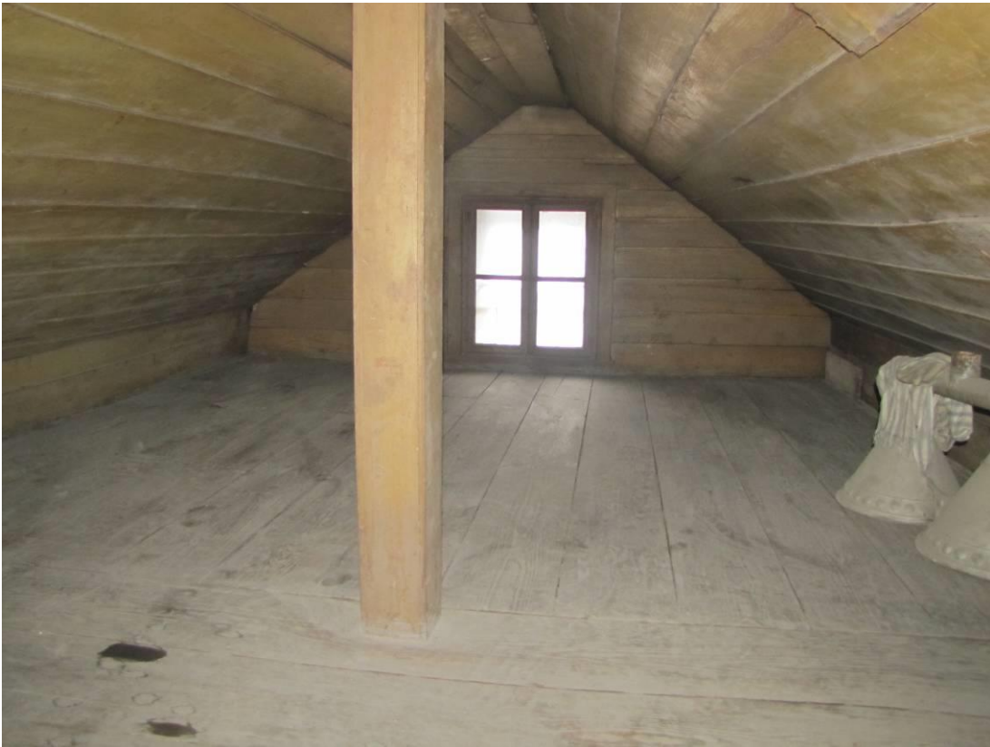
Şekil C.38: ÇK03 Çatı arası.
