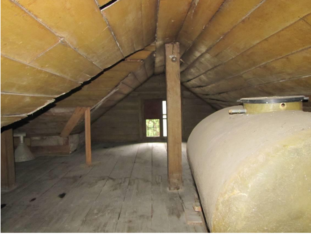
Şekil C.37: ÇK03 Çatı arası.
