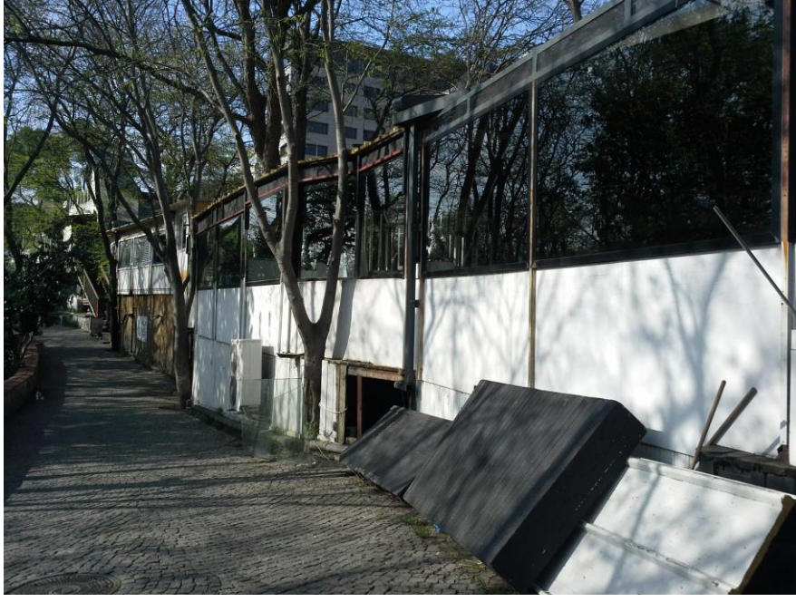
Şekil 17: Sanatçı atölyeleri, giyinme odaları, doktor ilkyardım merkezi, emanet dolapları için planlanan alanların günümüzdeki durumu 2 (Fotoğraf: Duygu Karakeçili)
