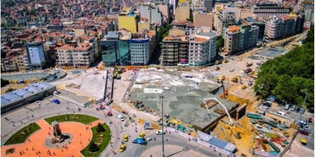
Şekil 34: Mayıs 2013 - Yayalaştırma projesi yapım aşamasında çekilmiş bir fotoğraf (Kaynak: http://megaprojeleristanbul.com/#taksim-meydani-yayalastirma-projesi )
