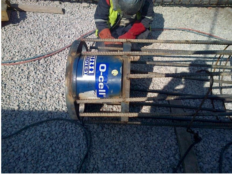
Şekil 6.30 : Osterberg yük hücrelerinin donatı kafesine montajı.
