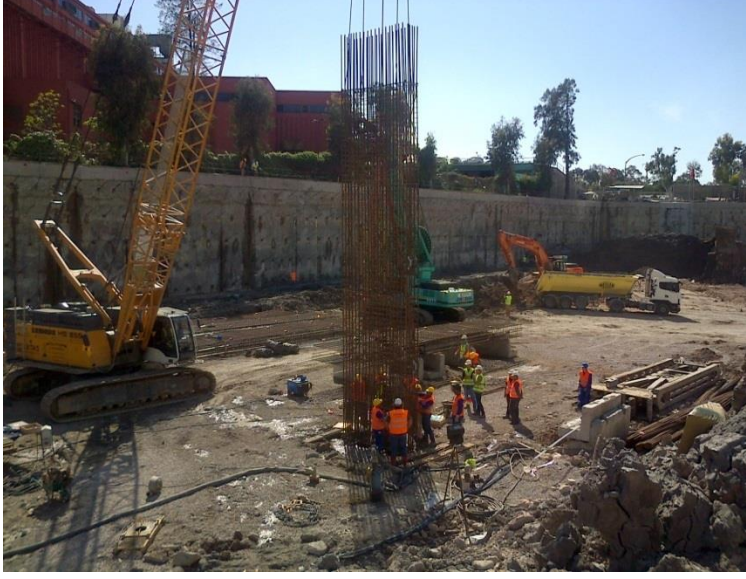
Şekil 2.13 : Donatı kafesinin kuyuya indirilmesi, (Saha – 1, 2013)
