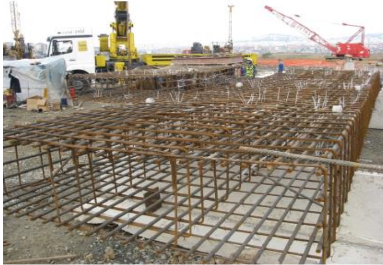
Şekil 2.12 : Baret donatı kafesinin hazırlanması (Zetaş katalog, 2014).
