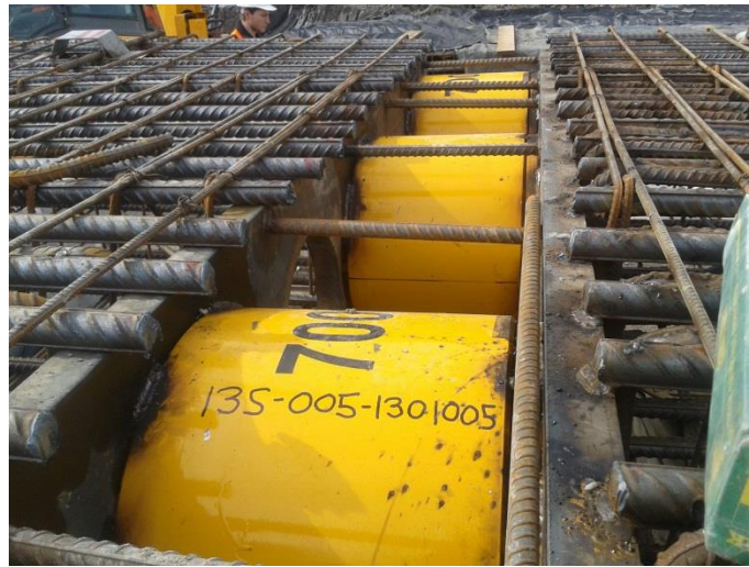
Şekil 6.9 : Yük hücresi montajı, (Saha – 1, 2013).
