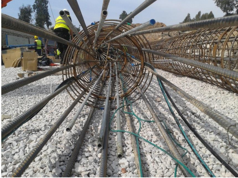
Şekil 6.31 : Tremi borusu geçişi için kılavuz huni detayı.
