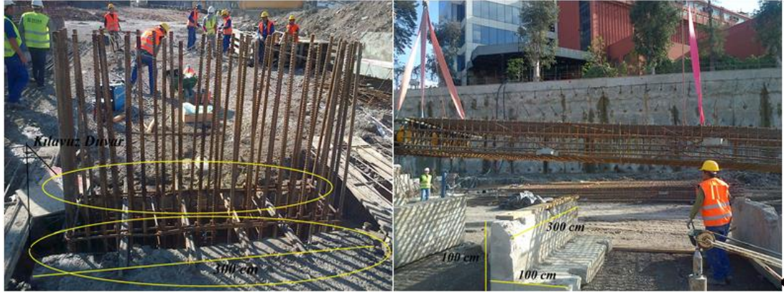
Şekil 2.7 : Kılavuz duvar boyutları ve yerleşimi.
