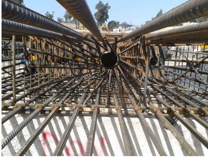
Şekil 6.10 : Huni şeklinde tremi borusu kılavuz imalat detayı, (Saha – 1, 2013).
