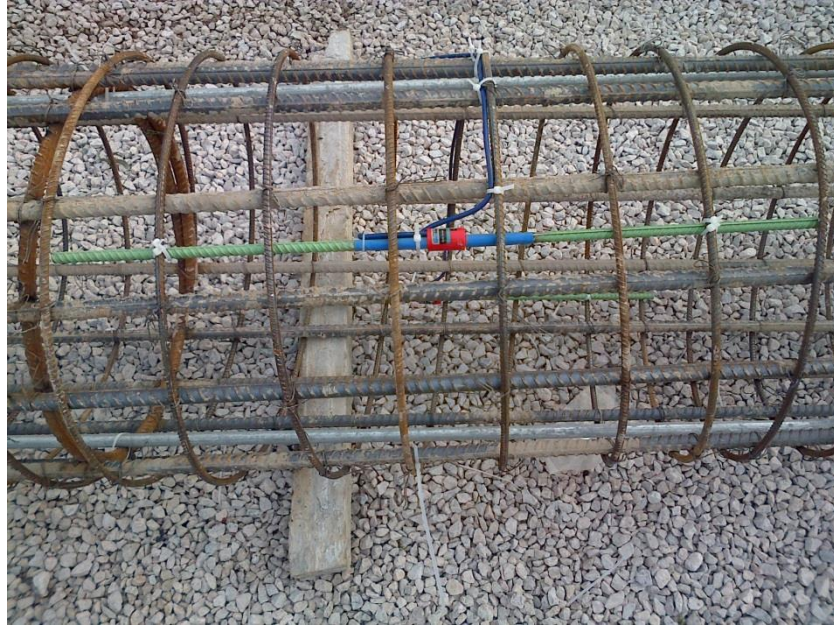
Şekil 6.32 : Geokon 4911 model gerilme ölçerlerin donatıya montajı.
