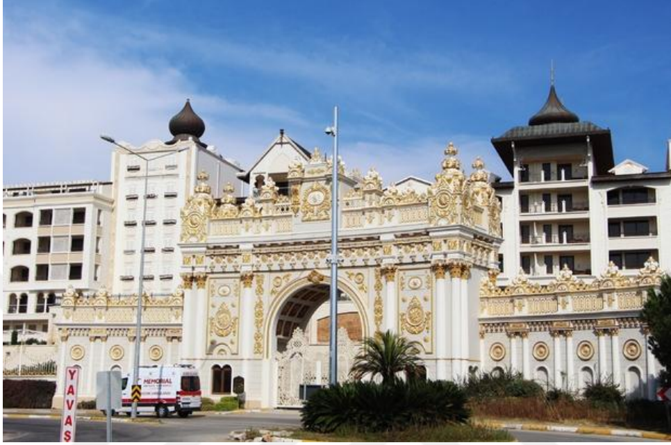
Şekil 2.10. Mardan Palace Giriş Kapısı
