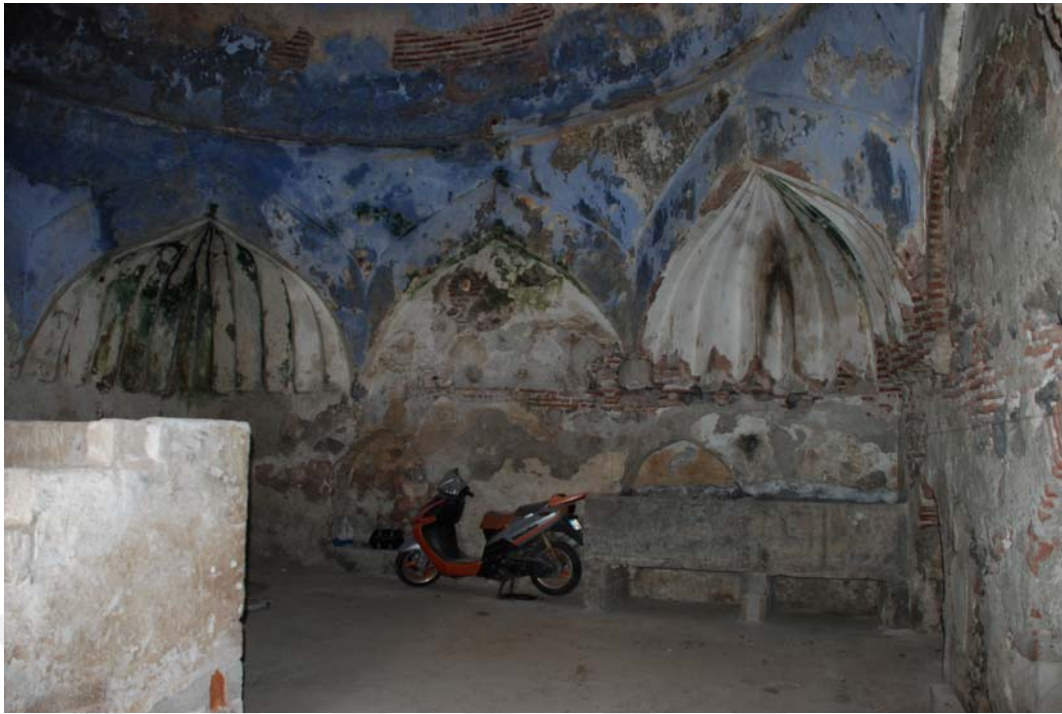
Figure 3.53. West wall of the soyunmalık space.
