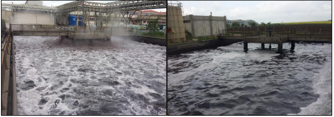
Şekil 3.16 : Havalandırma havuzu fotoğrafı.
