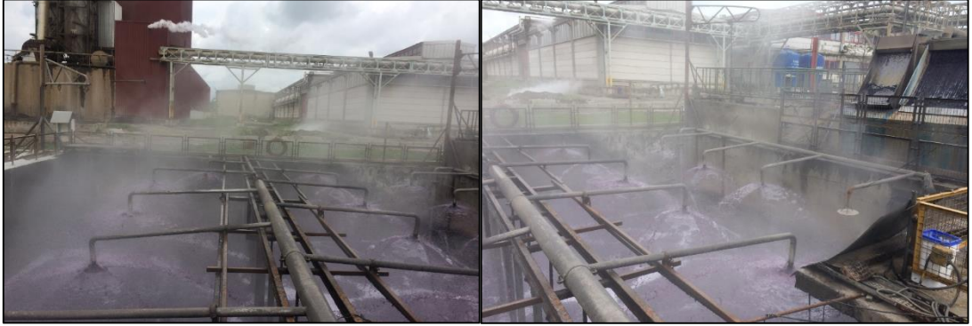
Şekil 3.13 : Dengeleme havuzu fotoğrafı.
