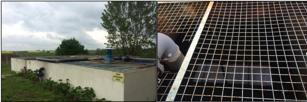
Şekil 3.18 : Çamur arıtma üniteleri fotoğrafı.
