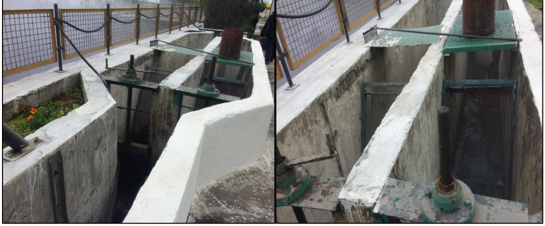
Şekil 3.12 : Kaba ızgara üniteleri fotoğrafı.
