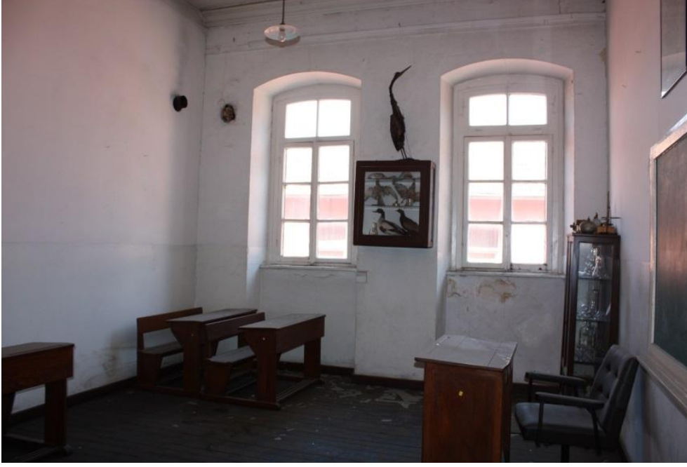
Şekil 4.45 : 106 numaralı mekanın kuzeydoğu cephe duvarı
