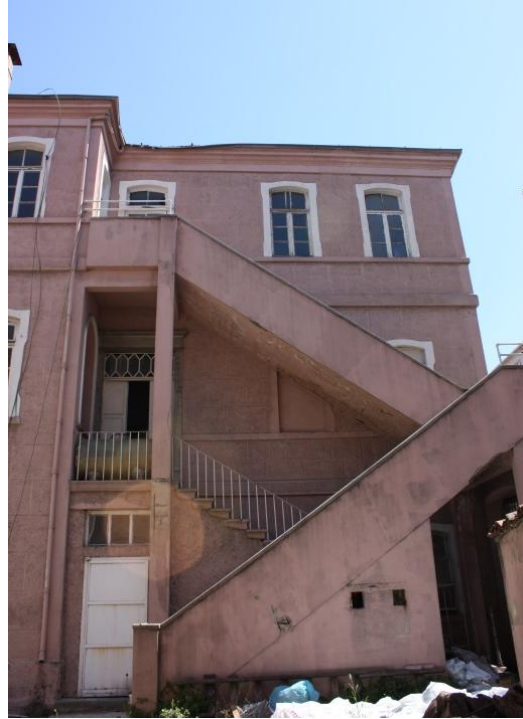
Şekil 4.111 : Güneybatı cephesinde yer alan betonarme merdiven
