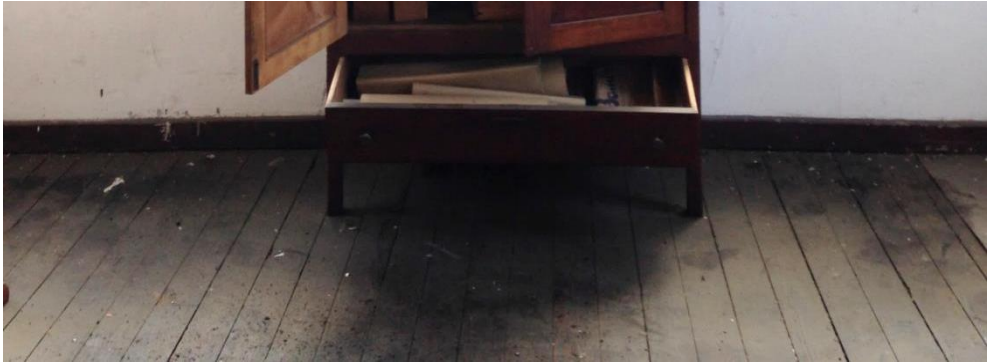
Şekil 4.101 : 207 numaralı sınıf Ahşap döşeme kaplaması
