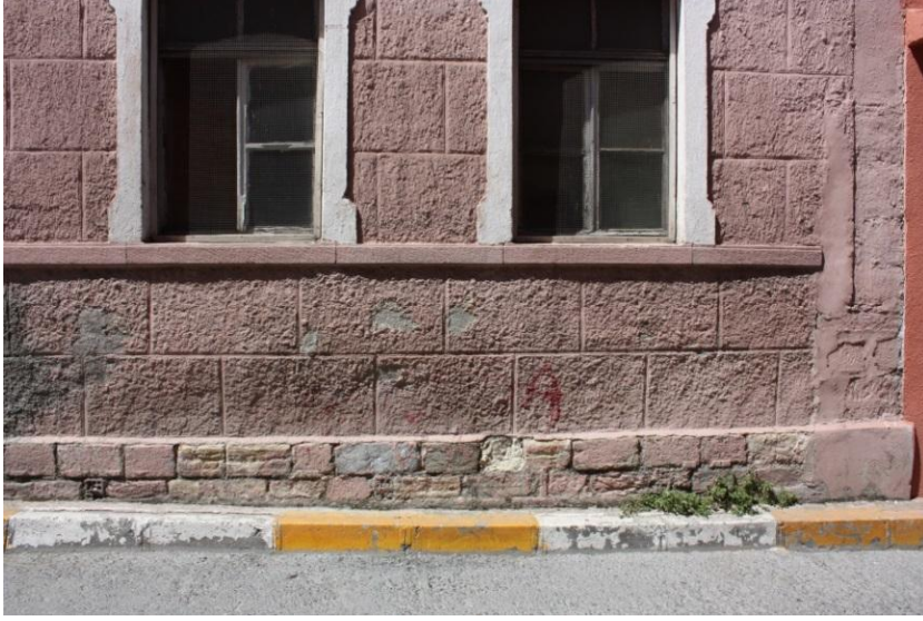
Şekil 4.94 : Ateş Böceği Sokak'daki kot farkından dolayı görünen taş duvar
