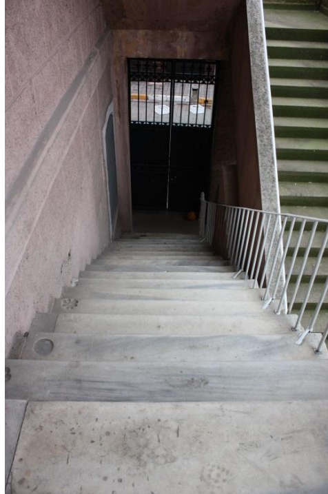
Şekil 4.109 : Güneybatı cephesinde yer alan mermer özgün merdiven
