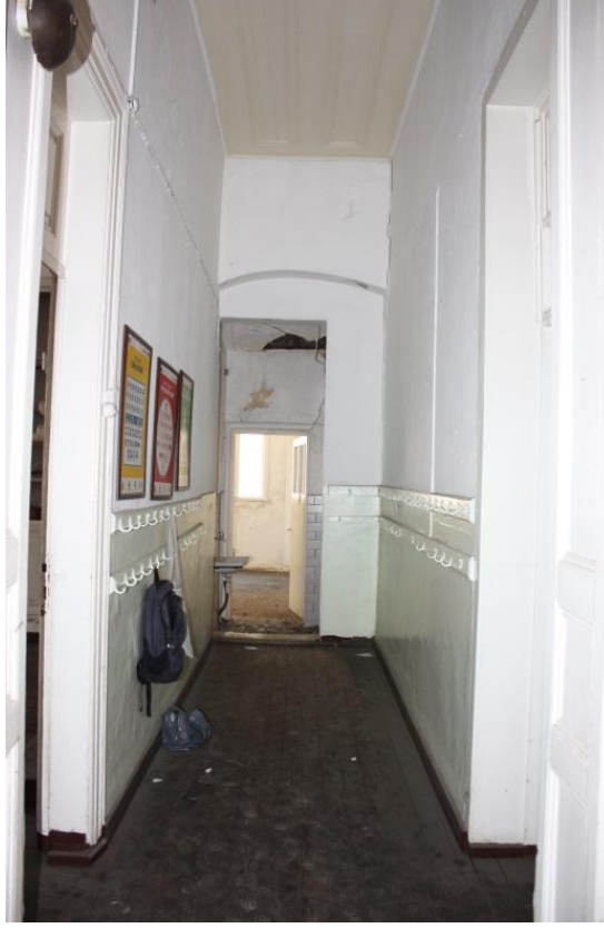
Şekil 4.46 : 107 numaralı koridor mekanı
