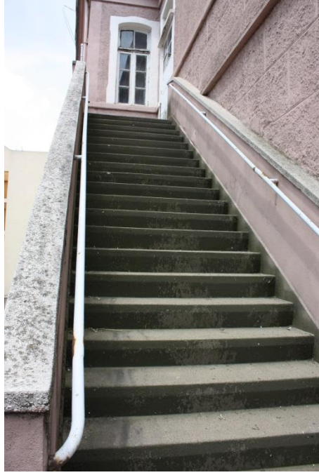
Şekil 4.112 : Betonarme merdiven parapet duvarı ve korkuluk ilişkisi
