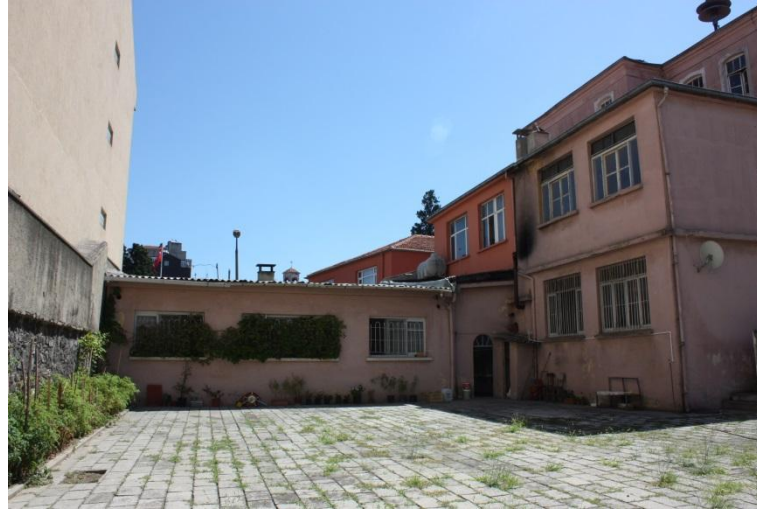
Şekil 4.91 : Güneybatı cephesi ek yapıların bulunduğu kısım
