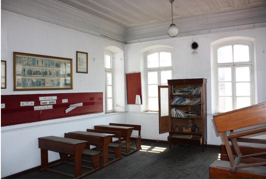
Şekil 4.86: 207 numaralı sınıf güneybatı cephesi pencereleri
