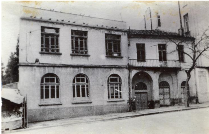
Şekil 3.6 : Betonarme yapı yapılmadan önceki okul yapıları (Erkan, 2009)
