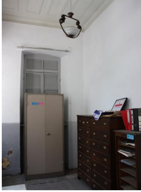
Şekil 4.39 : Z13 numaralı mekanın güneybatı duvarı
