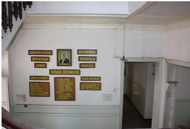
Şekil 4.34 : Merdiven holü tavan kaplaması ve silmesi
