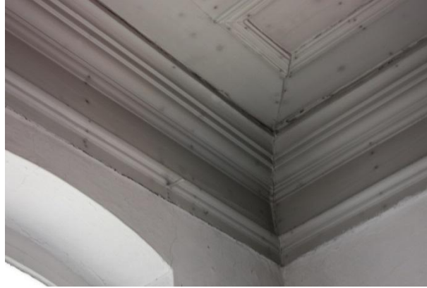
Şekil 4.153 : 207 numaralı sınıf profilli özgün ahşap tavan silmesi
