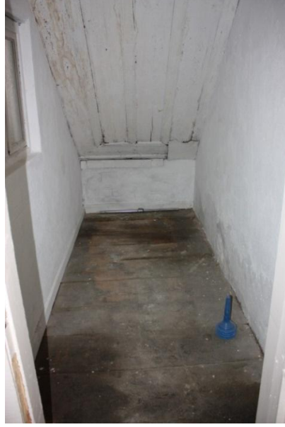
Şekil 4.10 : Z02 numaralı depo mekanı
