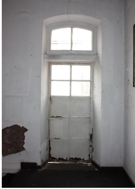
Şekil 4.123 :Güneybatı cephesi ikinci kat kapısı
