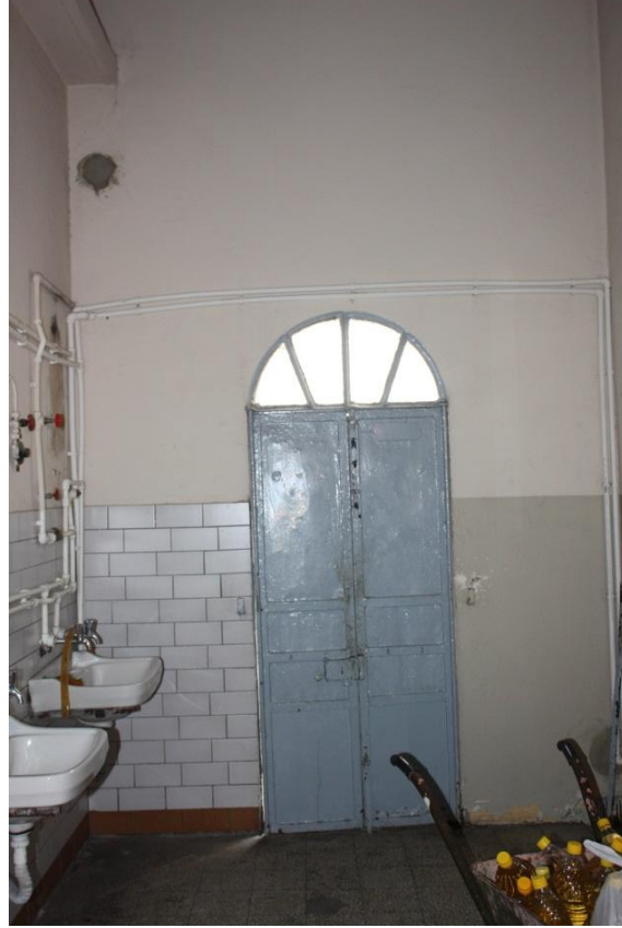
Şekil 4.26 : Z11 numaralı mekandan bahçeye geçişi sağlayan demir kapı
