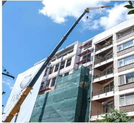
Şekil 3.8 : İtalyan Koleji inşaatı (Url-4)
