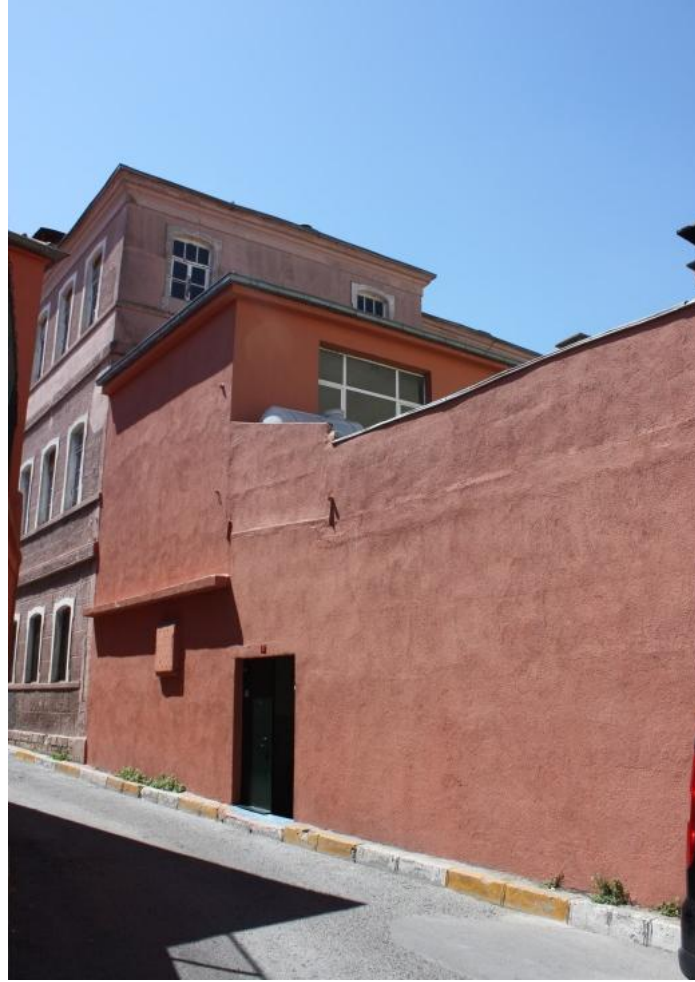
Şekil 4.89 : Kuzeydoğu cephesi ek yapıların bulunduğu kısım
