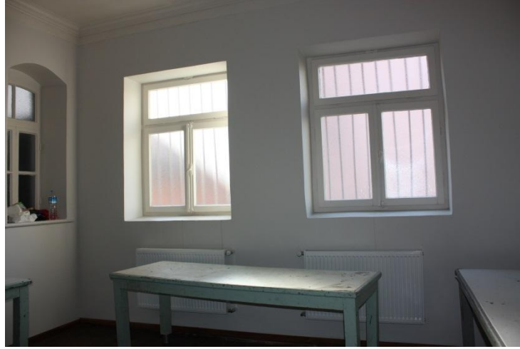
Şekil 4.17 : Yapının güney batı cephesinde yer alan ahşap pencereler
