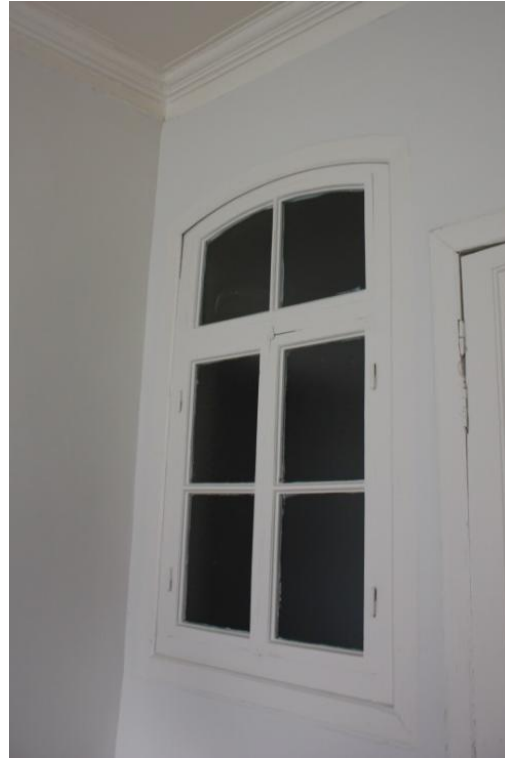
Şekil 4.148 : Z06 numaralı mekanın kuzeydoğu duvarında yer alan iç mekan penceresi örneği
