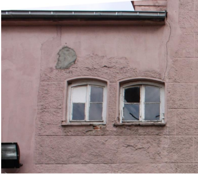
Şekil 4.140 : 110 numaralı tuvalet mekanının pencereleri
