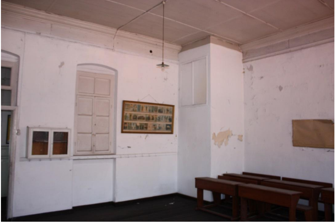
Şekil 4.157 : 108 numaralı sınıf mekanı batı köşesinden 113 numaralı mekana dahil edilen kısım
