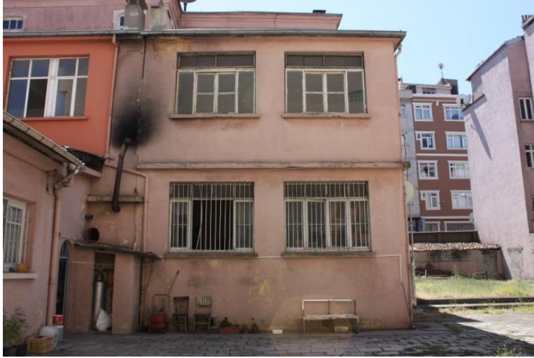
Şekil 4.92 : Kuzeybatı cephesi ek yapıların bulunduğu kısım
