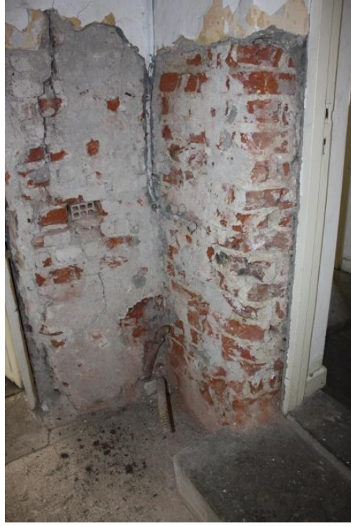
Şekil 4.56 : 110 numaralı mekanın sıvası kaldırılmış duvarları
