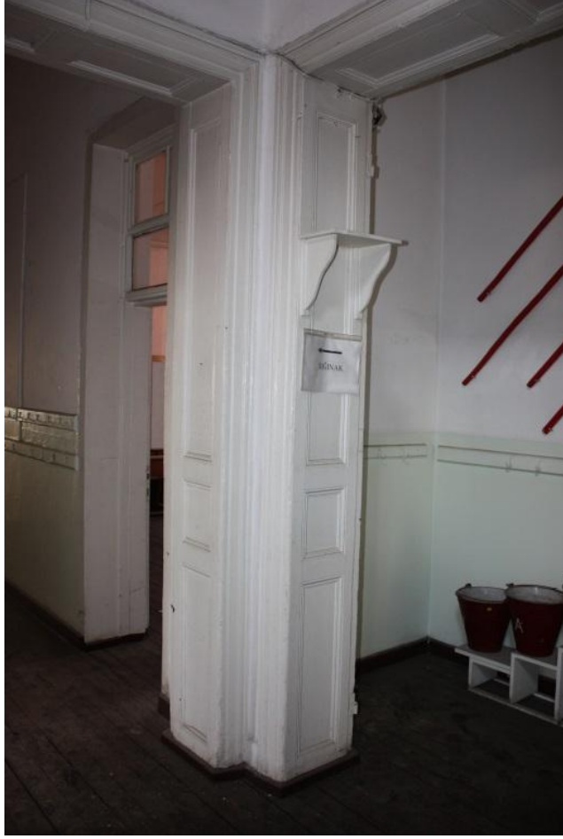
Şekil 4.127 : 101-102-108 mekanları arası özgün ahşap kapı kasaları
