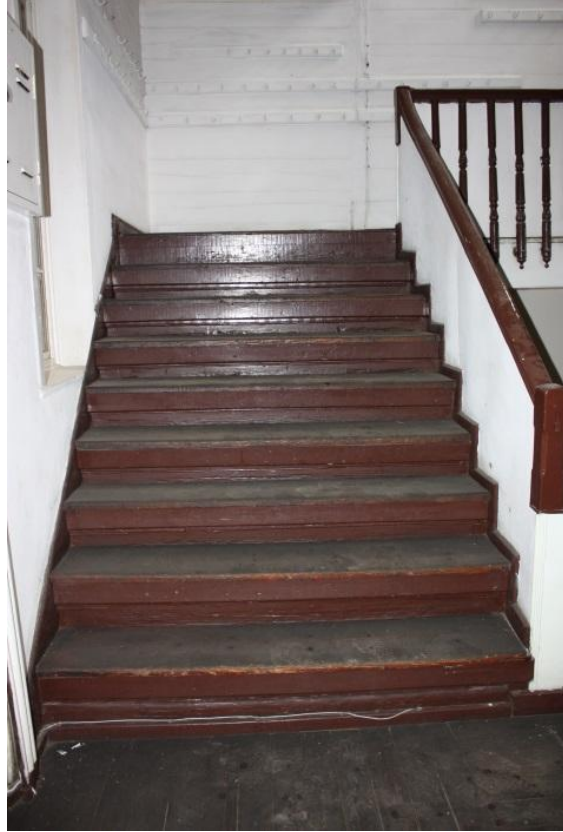
Şekil 4.107 : 101 numaralı merdiven holünde yer alan merdiven kolu
