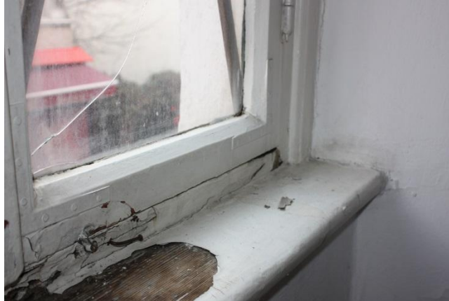
Şekil 4.170 : İç mekanda yer alan ahşap denizliklerde çürüme
