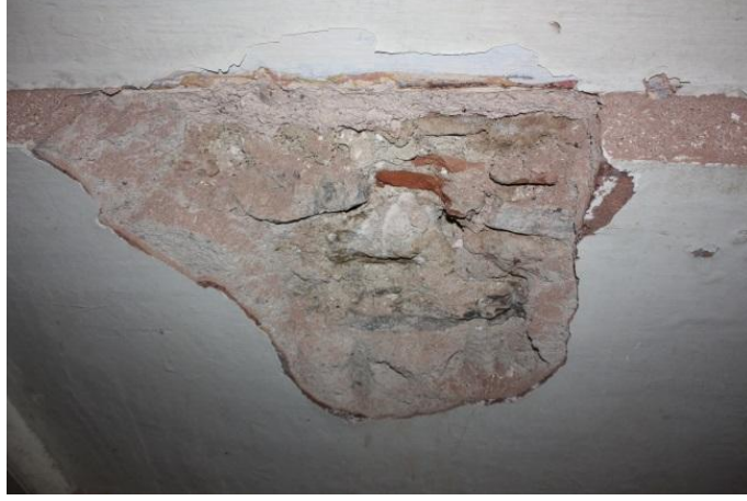
Şekil 4.96 : Z07 numaralı tuvalet mekanı onarım öncesi duvar yapı malzemesi
