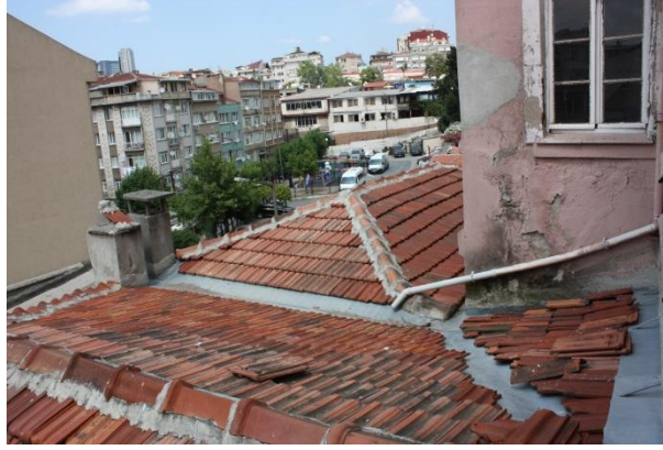
Şekil 4.114 : Yapının iki katlı ek kısmının çatısı
