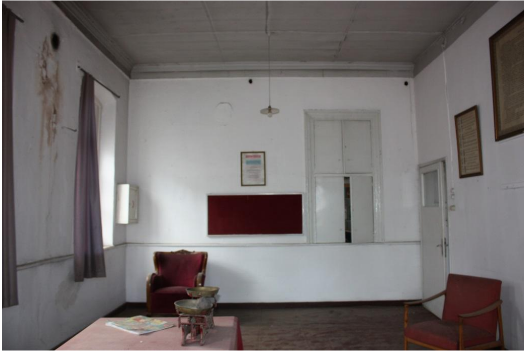
Şekil 4.77 : 204 numaralı mekan güneydoğu duvarı
