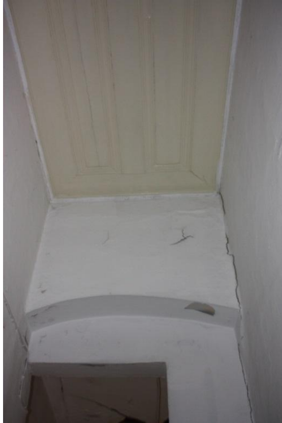
Şekil 4.47 : 117 ve 110 numaralı mekanlar arası geçişte yer alan kemer
