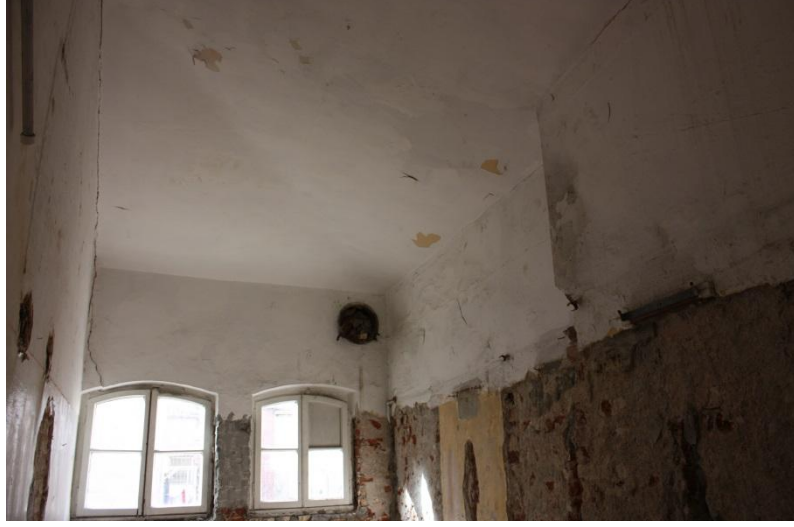
Şekil 4.60 : 111 numaralı mekanın tavanı
