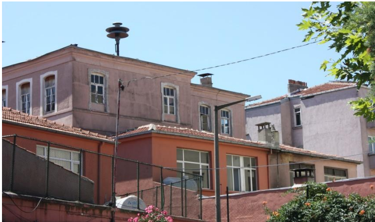
Şekil 4.93 : Kuzeybatı cephesi ikinci kat özgün kısım
