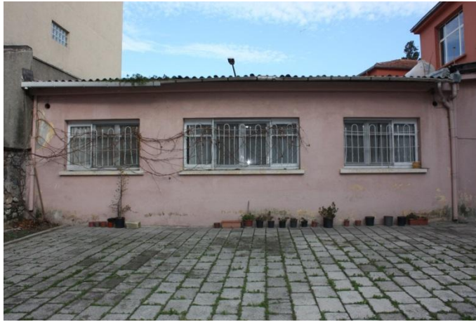
Şekil 4.146 : Tek katlı ek yapı güneybatı cephesi pencereleri
