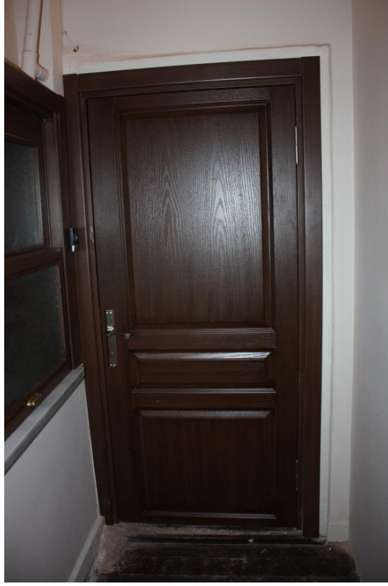
Şekil 4.155 : Z05 -Z09 numaralı mekanlar arası açılan kapı açıklığı
