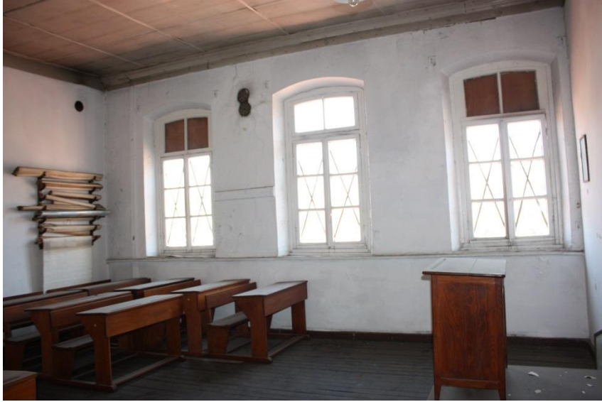
Şekil 4.80 : 205 numaralı sınıf kuzeydoğu cephesi pencereleri
