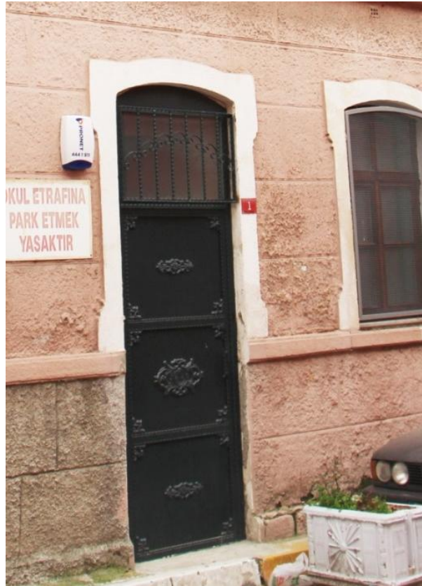
Şekil 4.118 : Kuzeydoğu cephesi demir kapı
