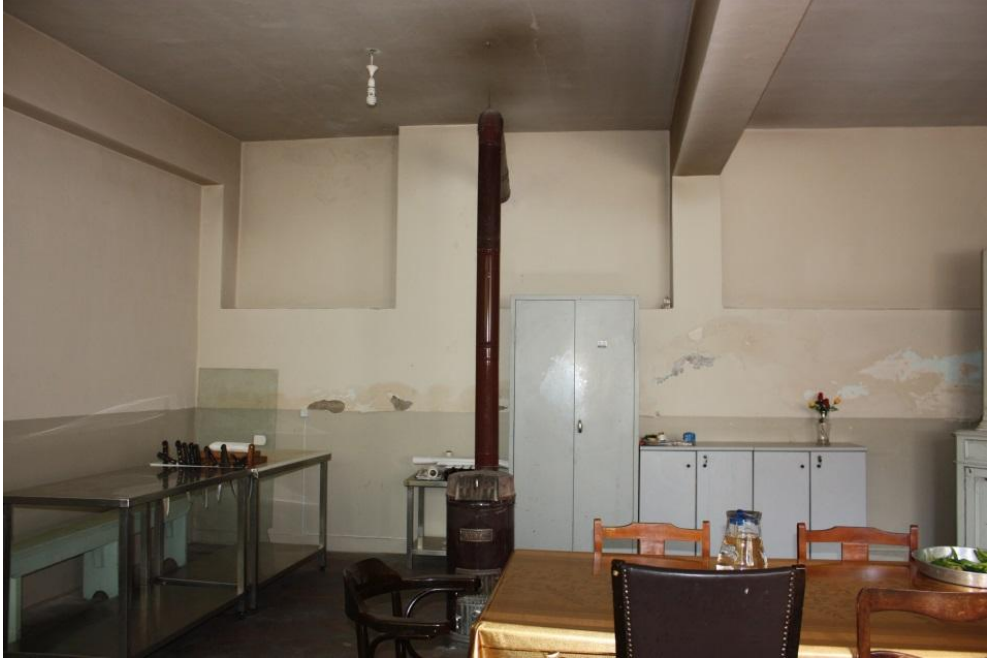
Şekil 4.27 : Z12 numaralı yemek odasının okulun kuzeydoğu cephesini oluşturan duvarı
