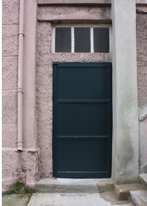
Şekil 4.120 : Güneybatı cephesi bahçe kapısı
