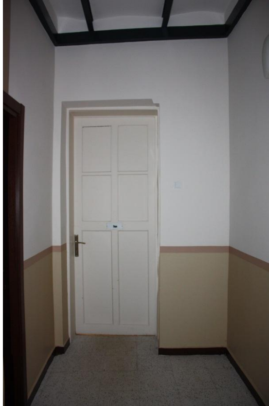
Şekil 4.156 : Z04-Z08 numaralı mekanlar arası açılan kapı açıklığı
