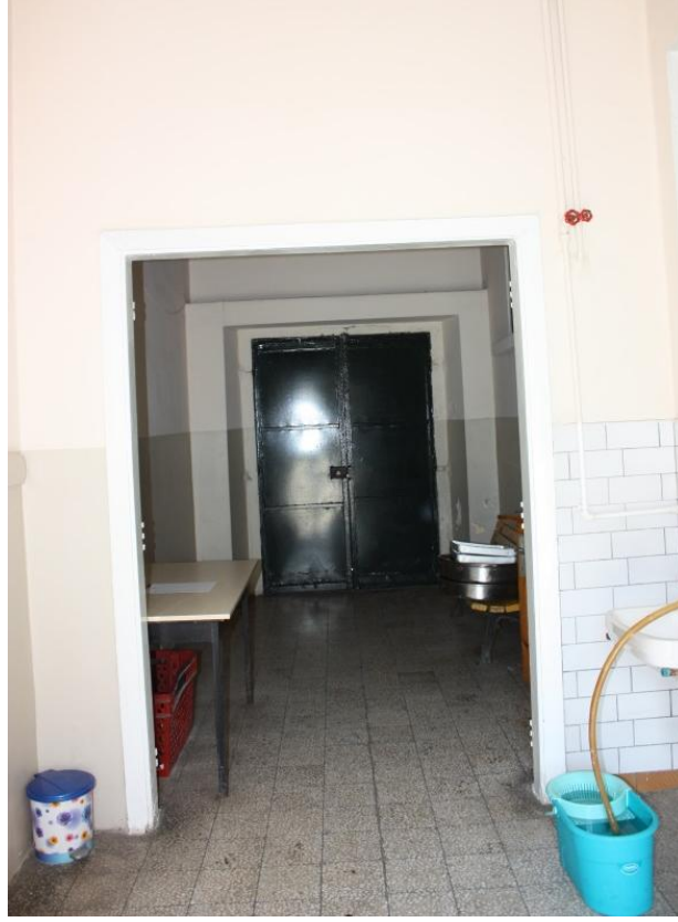
Şekil 4.25 : Z11 numaralı giriş holünü ikiye ayıran kapı açıklığı
