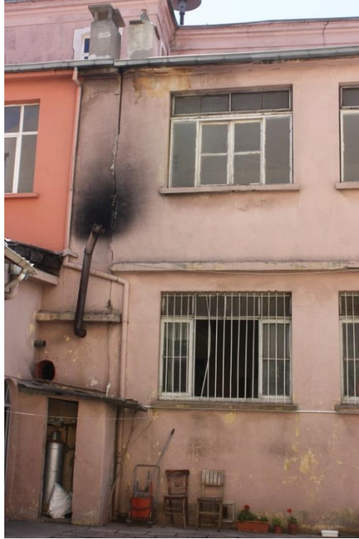
Şekil 4.168 : Yapının iki katlı ek kısmının orta kısmında yer alan çatlak
