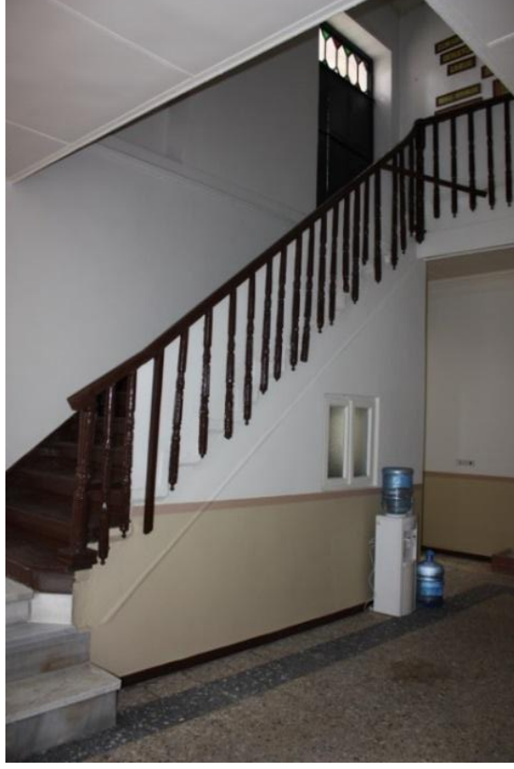
Şekil 4.106 : Z01 numaralı giriş holünde yer alan ahşap merdiven kolu
