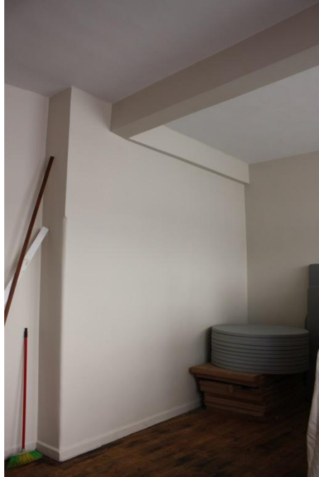
Şekil 4.22 : Z08 depo mekanında yer alan kirişler
