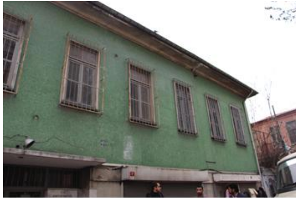
Şekil 3.3 : Yenişehir Rum İlkokulu
