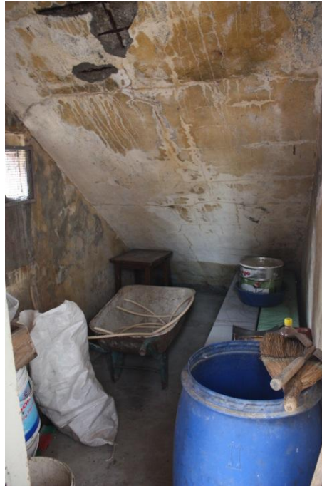
Şekil 4.29 : Z14 numaralı depo mekanı
