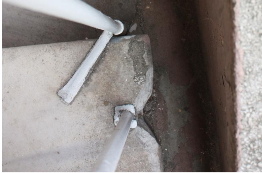
Şekil 4.176 : Mermer basamaklarda kopmalar
