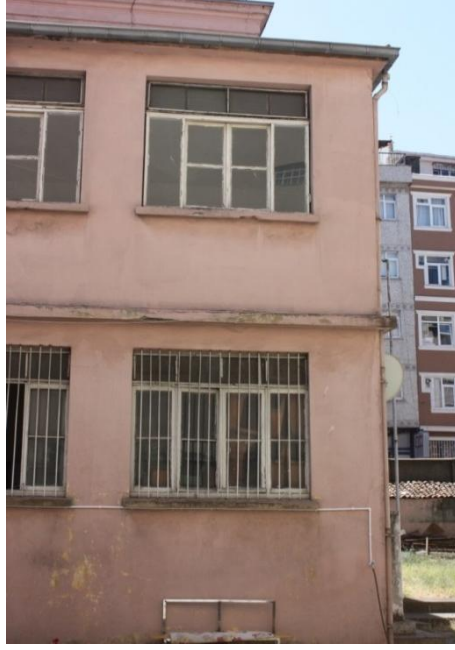
Şekil 4.144 : İki katlı ek yapı kuzeybatı cephesi ahşap pencereleri
