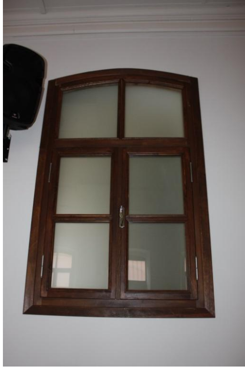
Şekil 4.147 : Z05 numaralı çok amaçlı salon güneybatı duvarında yer alan iç mekan yenilenmiş penceresi örneği
