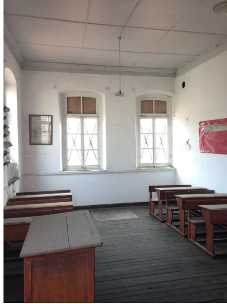
Şekil 4.81 : 206 numaralı sınıf kuzeydoğu cephesi pencereleri
