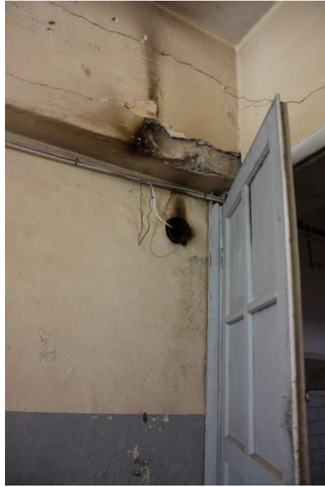
Şekil 4.95 : Z08 numaralı depo mekanı ek yapı betonarme giriş
