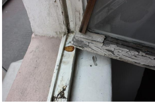
Şekil 4.171 : Ahşap doğramalarda çürüme
