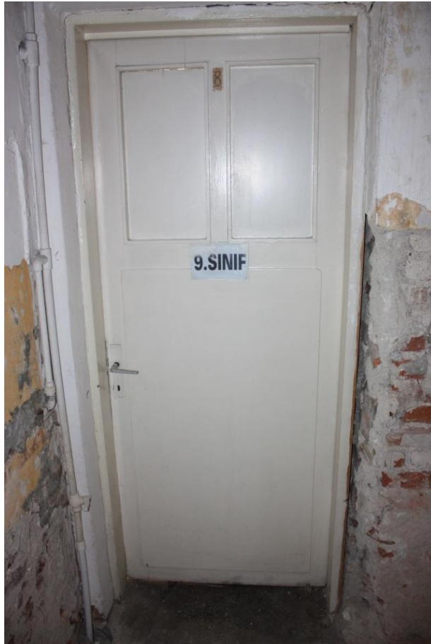
Şekil 4.158 : 110-112 numaralı mekanlar arası açılan kapı açıklığı
