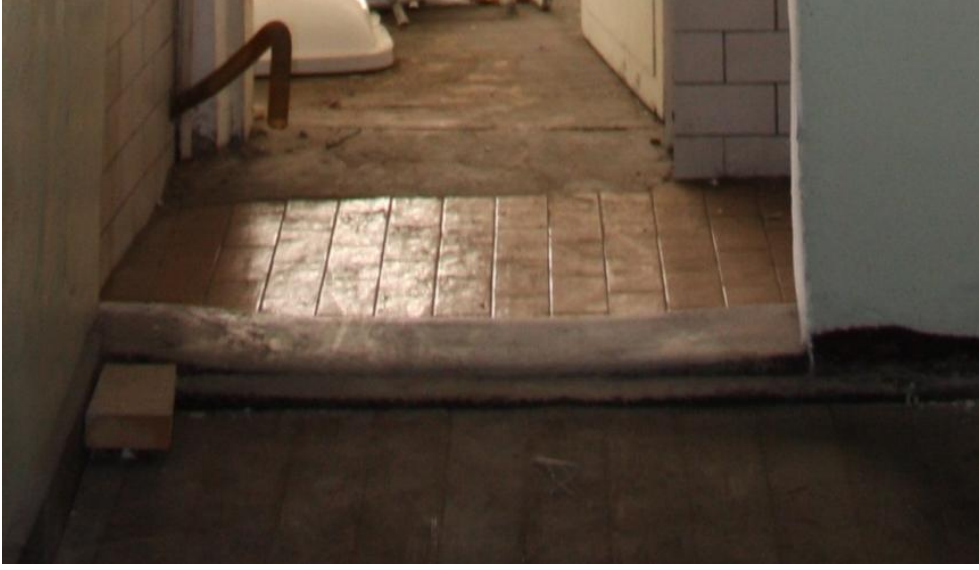
Şekil 4.48 : 110 numaralı mekana geçişteki mermer eşik
