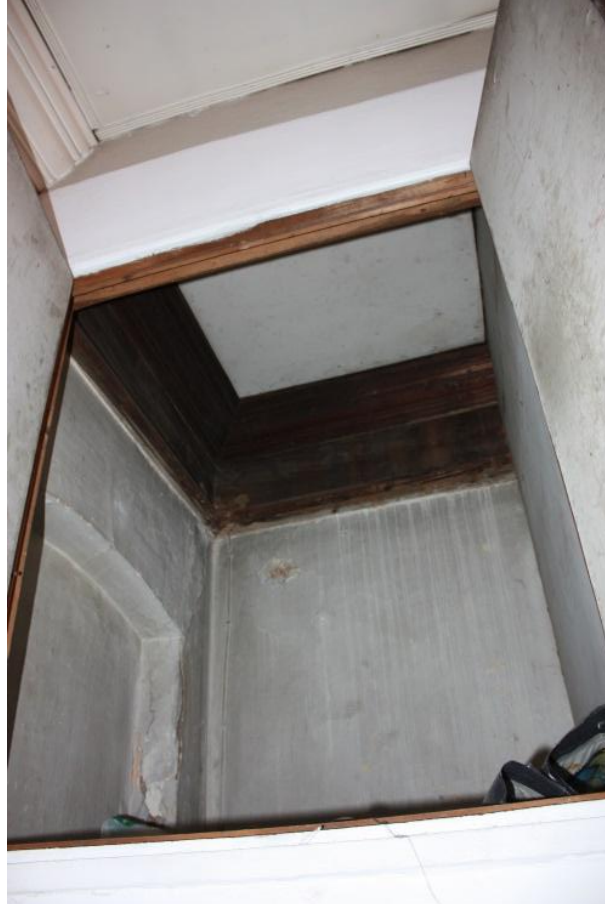
Şekil 4.51 : Mekanın batı köşesindeki dolap
