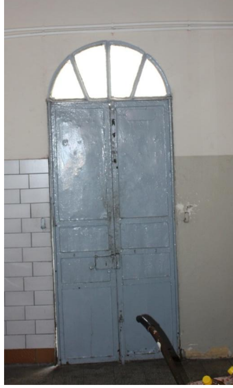
Şekil 4.121 : Güneybatı cephesi ek kısım bahçe kapısı
