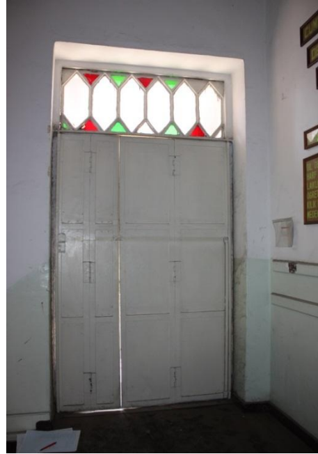
Şekil 4.122 : Güneybatı cephesi birinci kat kapısı
