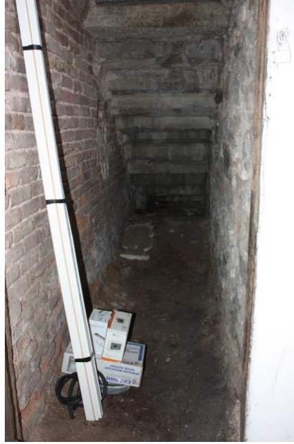
Şekil 4.97 : Z03 numaralı depo kuzeydoğu duvarı tuğla örgü
