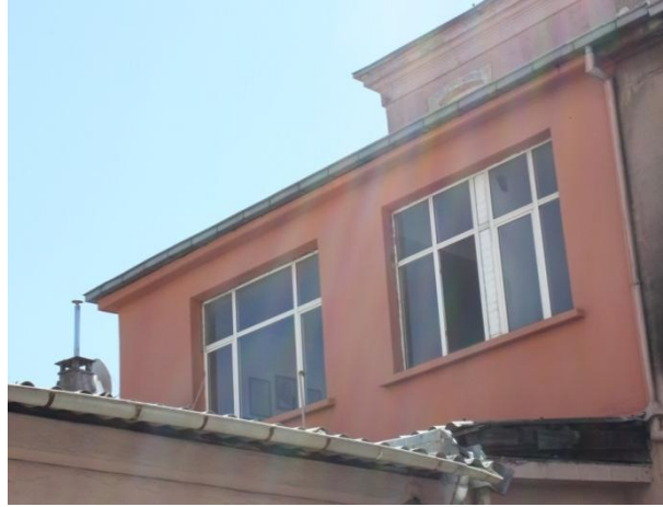
Şekil 4.145 : İki katlı ek yapı kuzeybatı cephesi alüminyum pencereleri
