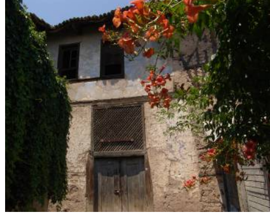
Resim 53 (2) Balaban C. No: 51 – Terk Edilmiş Pafta : 30 L I b4 Ada : 102 Parsel : 24
