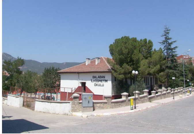
Resim 45 : Balaban İlköğretim Okulu
