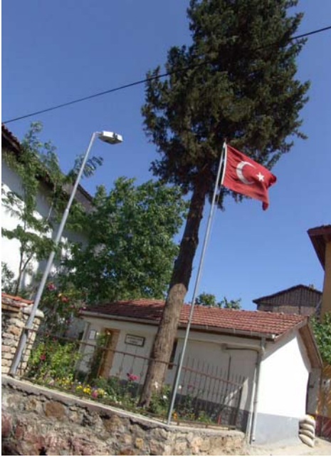
Resim 24 : Bayraklı Dede Türbesi dış görünümü
