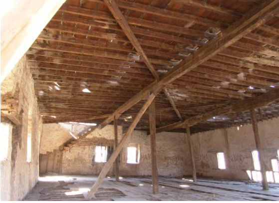
Resim 47 : İkinci katı taşıyan çapraz ahşap kirişler
