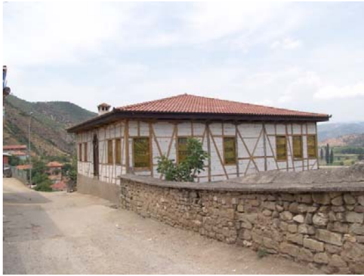
Resim 94 : Restorasyon sonrası doğu cephesi
