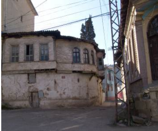
Resim 61 (10) Beyler Sok. No : 1 Kalemciöđlü Evi Pafta : 30 L I b4 Ada : 110 Parsel : 4
