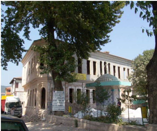
Resim 43 : Çatı Onarımı yapılan Hükümet Konağı
