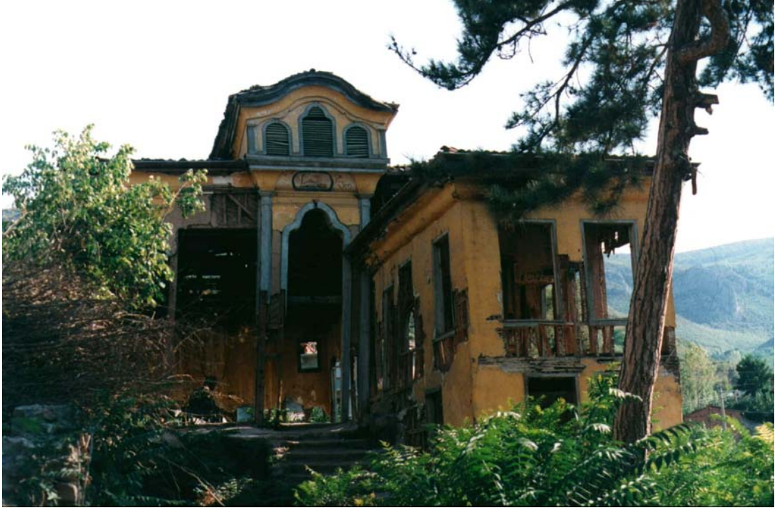
Resim 33 : Fabrika binasının yıkılmadan önceki durumu ( Battalgazi 2004)
