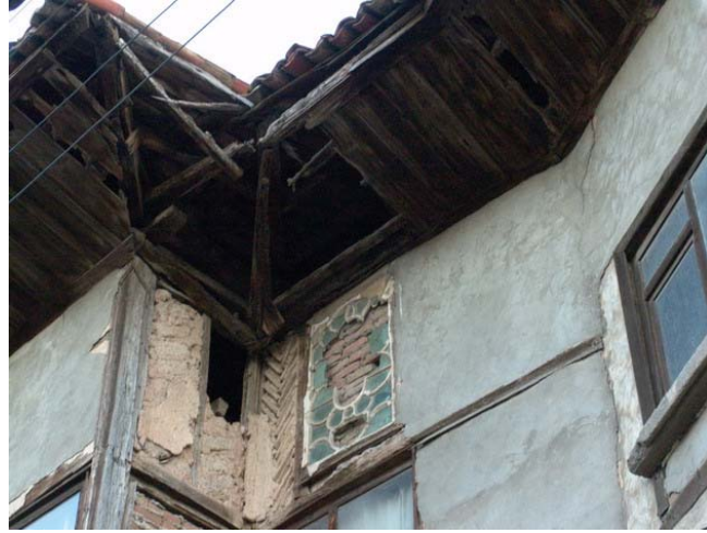
Resim 68 : Keskinzade Konağı Revzen ve Çatı Detayı ( 13 )
