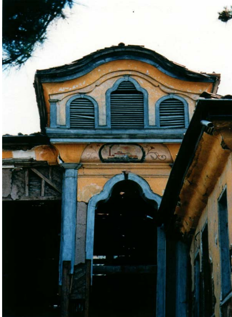
Resim 32 : İpek fabrikası giriş cephesi ( Battalgazi,2004)
