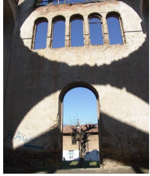
Resim 22 : Kuzey cephesi girişi
