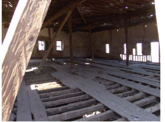
Resim 38 : Zemin ve Orta kat arasındaki taban dokusu
