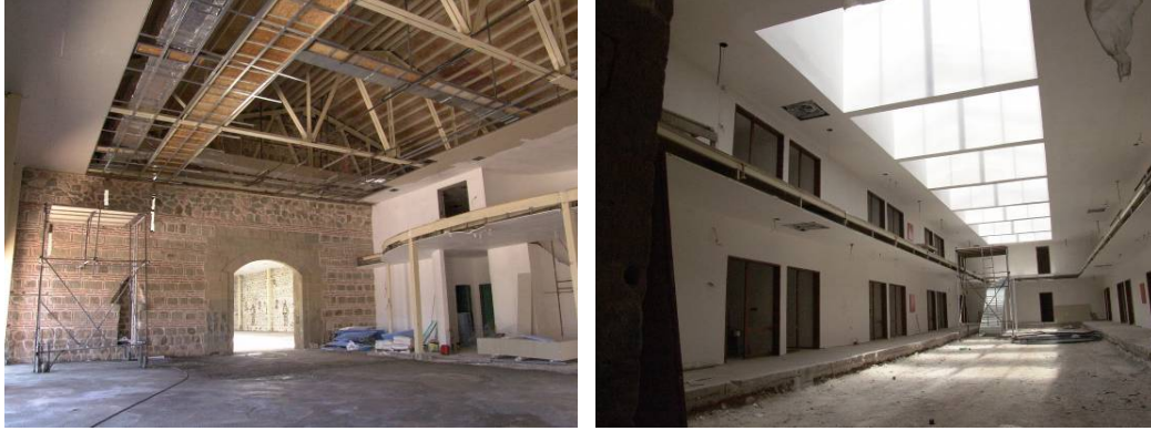
Resim 90 : Vezirhan Köprülü Kervansarayının restorasyon dönüşüm çalışmaları
