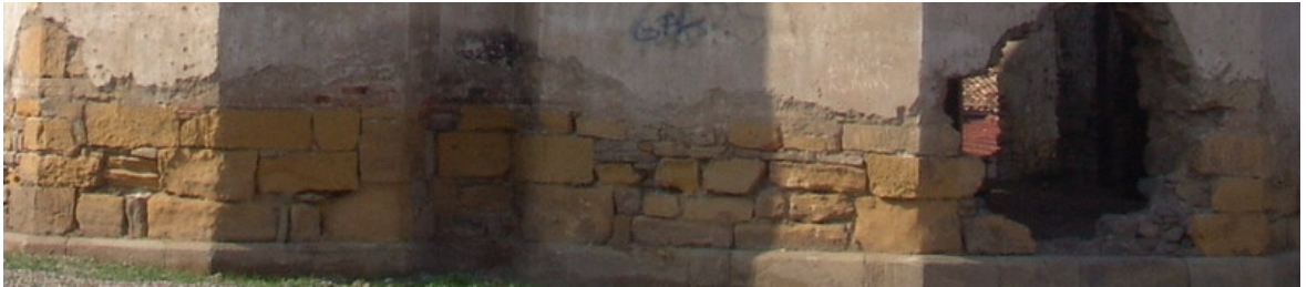
Resim 86 : Kilisenin beden duvarlarında kullanılan Lefke Taşı örnekleri
