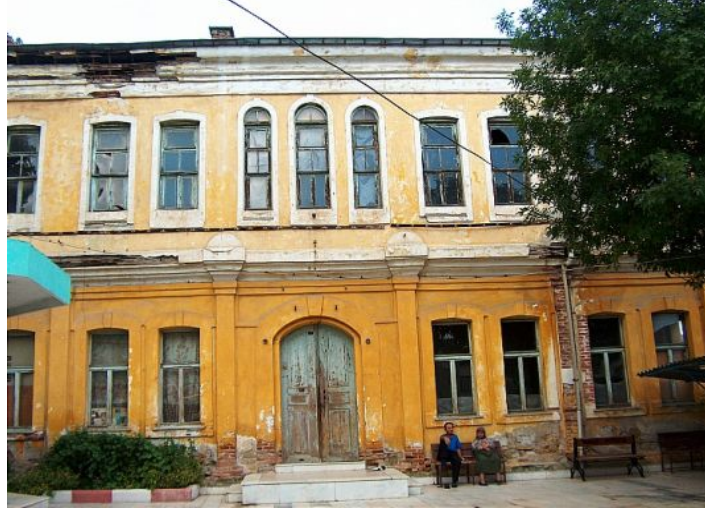
Resim 40 : Hükümet Konağı Ana Giriş Kapısı
