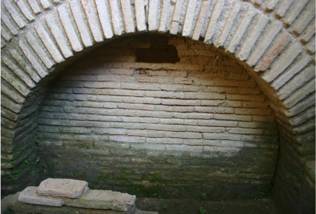
Resim 4.26. M6 kodlu mezar odası zeminden yükselen nem ve yosun oluşumu.
