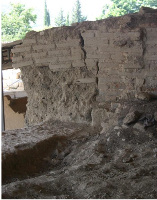
Resim 4.2. M9 kodlu mezar yapısı ikinci kat kuzey duvar
