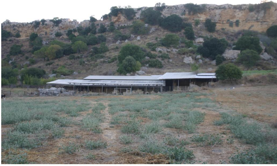
Resim 5.1. Perge Batı Nekropolis geçici çatı örtüsü
