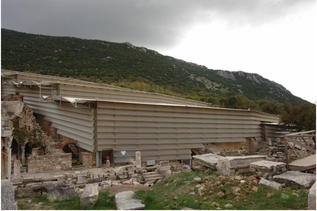
Resim 5.4. Efes Yamaç Evler koruyucu çatı strüktürü (Resim Çekimi: Özlem Toprak Cihan)
