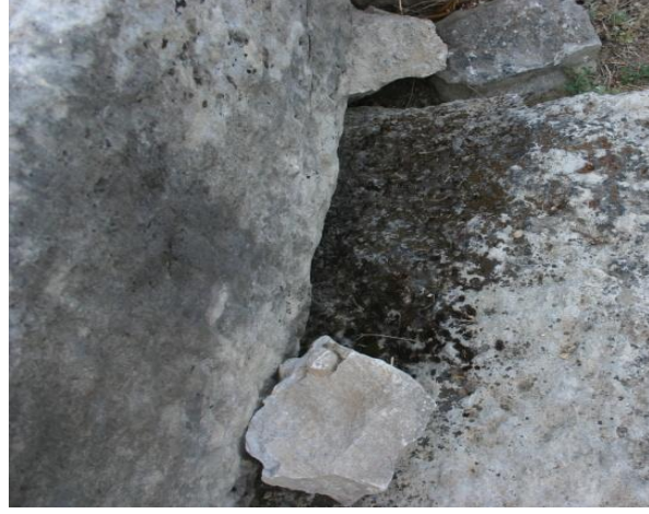
Resim 4.13. P12 kodlu mezar yapısı taş yüzeyinde yosun oluşumu
