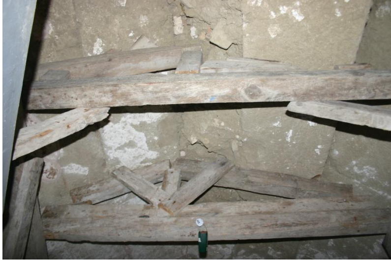
Resim 4.1. M9 kodlu mezar yapısı kuzey oda tonozu
