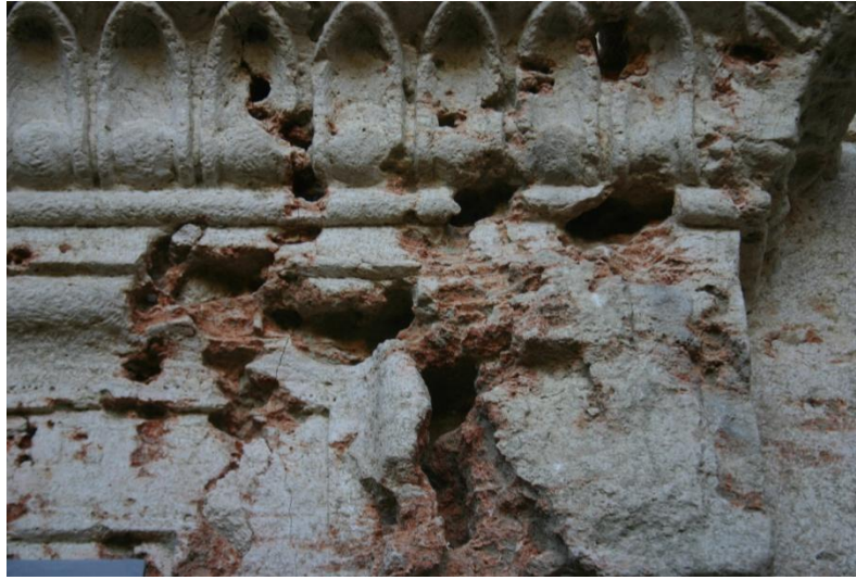
Resim 4.7. M9 kodlu mezar yapısı cephesi kuzey oda lentosu
