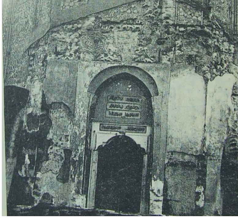
Fotoğraf 3.6 Mahmut Paşa Türbesi Giriş Kapısı, Güzel Sanatlar Mecmuası (1946) Sayı.6, s. 155
