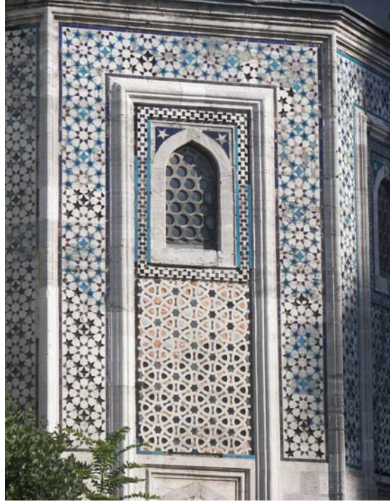
Fotoğraf 3.17 Mahmut Paşa Türbesi Kuzeybatı Cephe Görünüşü, G. Taşkiran, 2013
