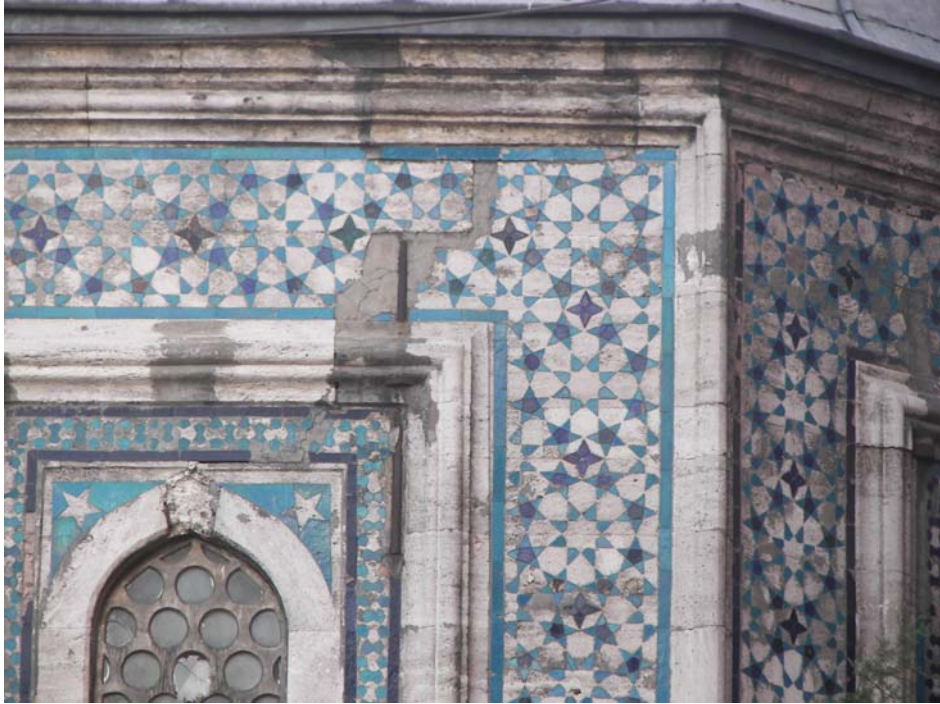
Fotoğraf 4.20 Yapının batı cephesinden detay, G. Taşkiran, 2013
