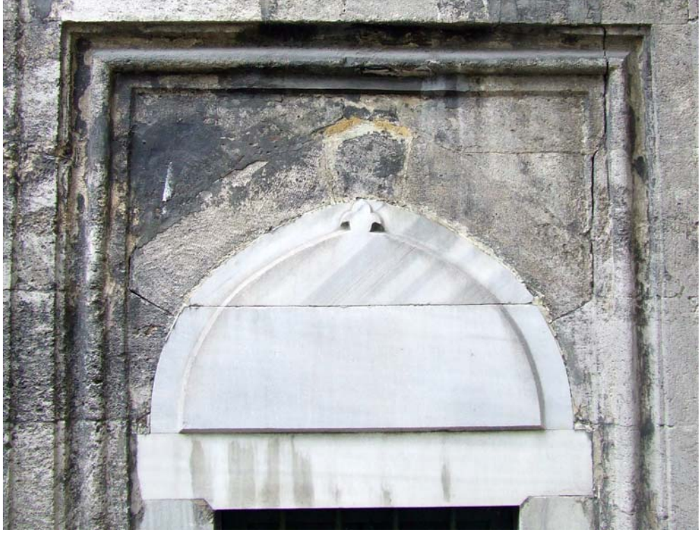
Fotoğraf 4.10 Yapının dođu cephesindeki alt pencerenin alınlığında grlen kabuklařma, G. Tařkiran, 2013
