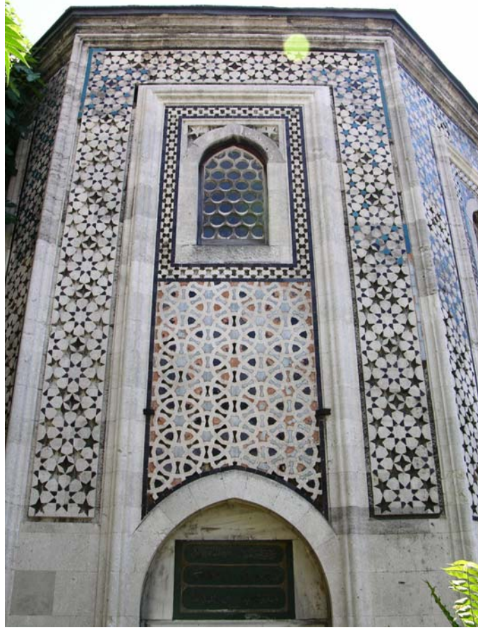
Fotoğraf 3.11 Mahmut Paşa Türbesi Kuzey Cephesi, G. Taşkıran, 2013
