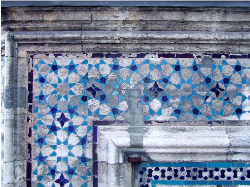
Fotoğraf 4.14 Yapının güneybatı cephesindeki patlıcan moru mozaik şerit çinilerdeki sır dökülmeleri, G.Taşkıran,2013
