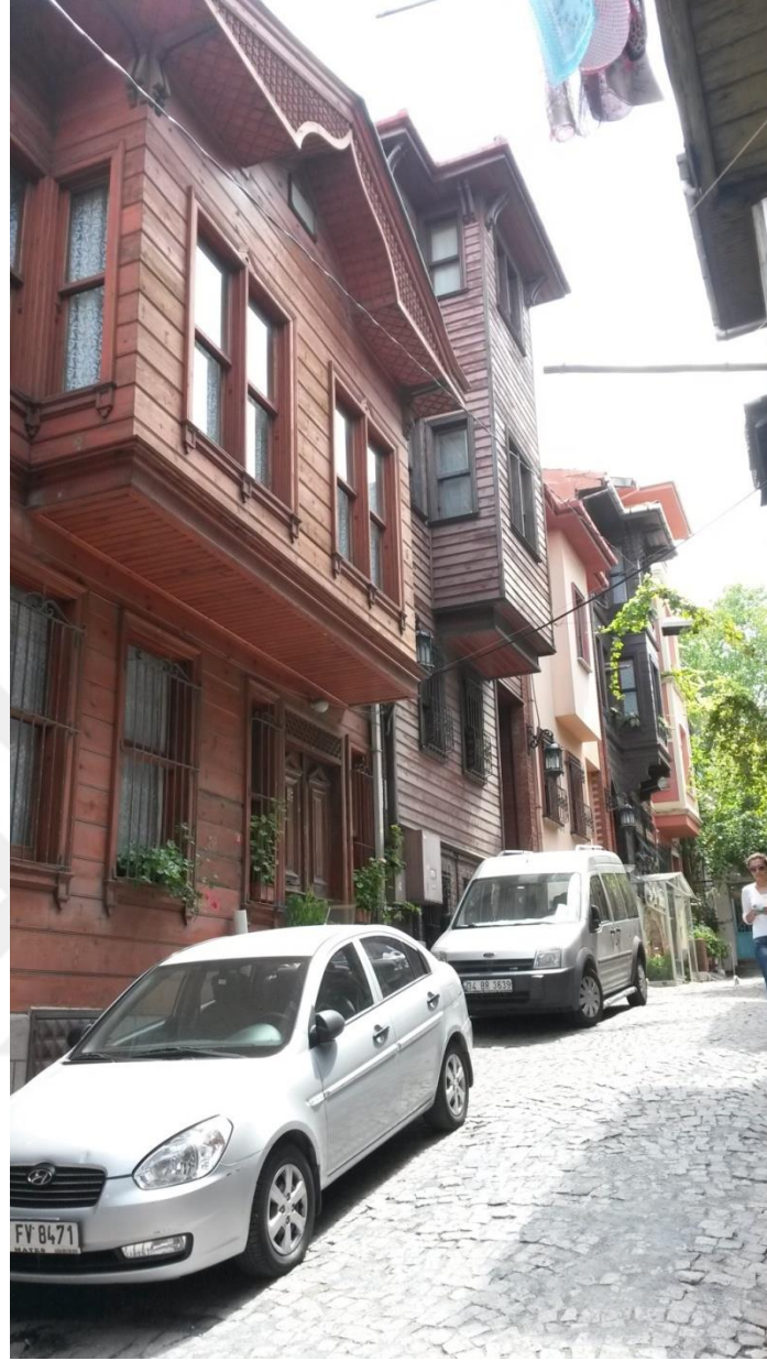
Fotoğraf - 16: 494 ada, 65 parseldeki betonarme rekonstrüksiyon yapıları
