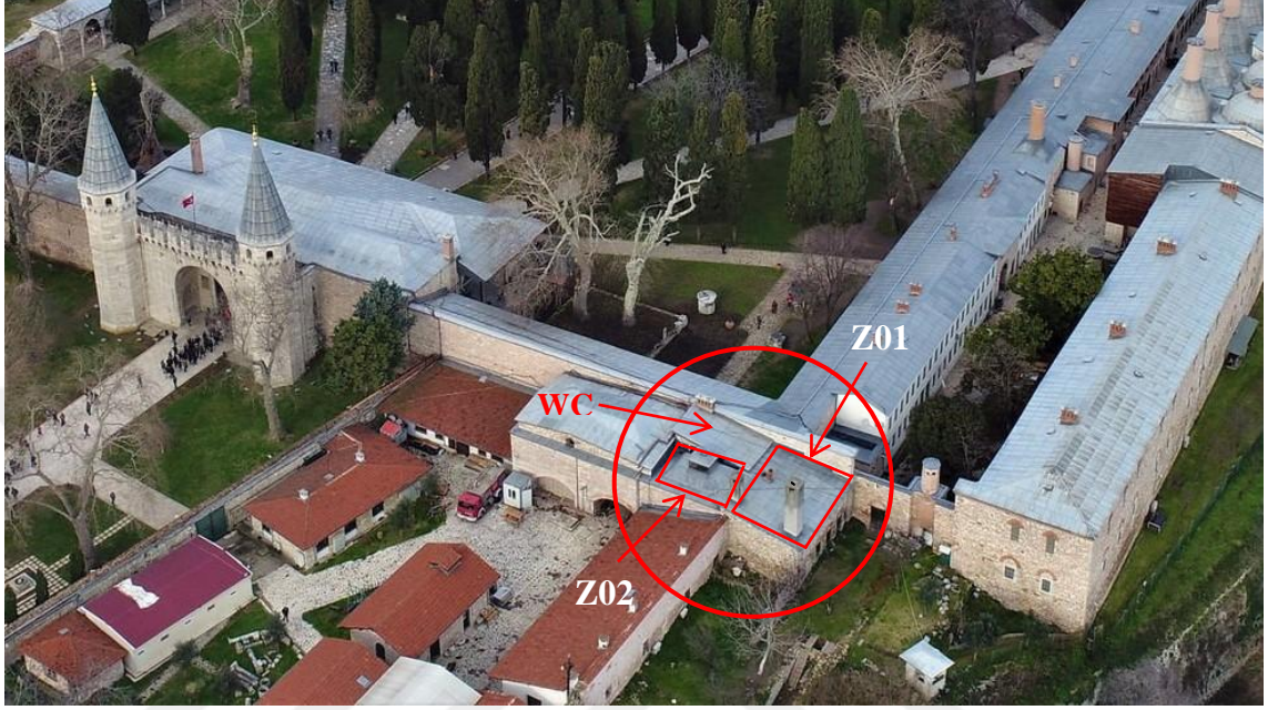
Şekil 2.25. Topkapı Sarayı Kurşunluk Yapısı'nın hava fotoğrafı (Habertürk Gazetesi, 2018)
