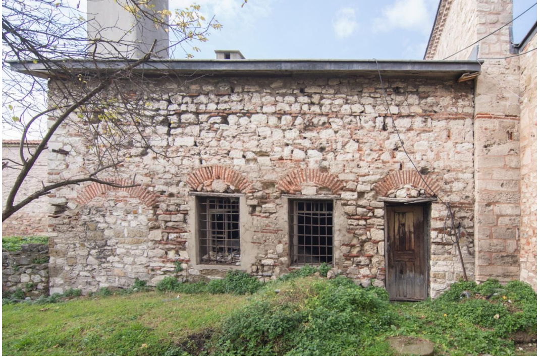
Şekil 2.81. Güneydoğu cephesinin günümüzdeki görünümü
