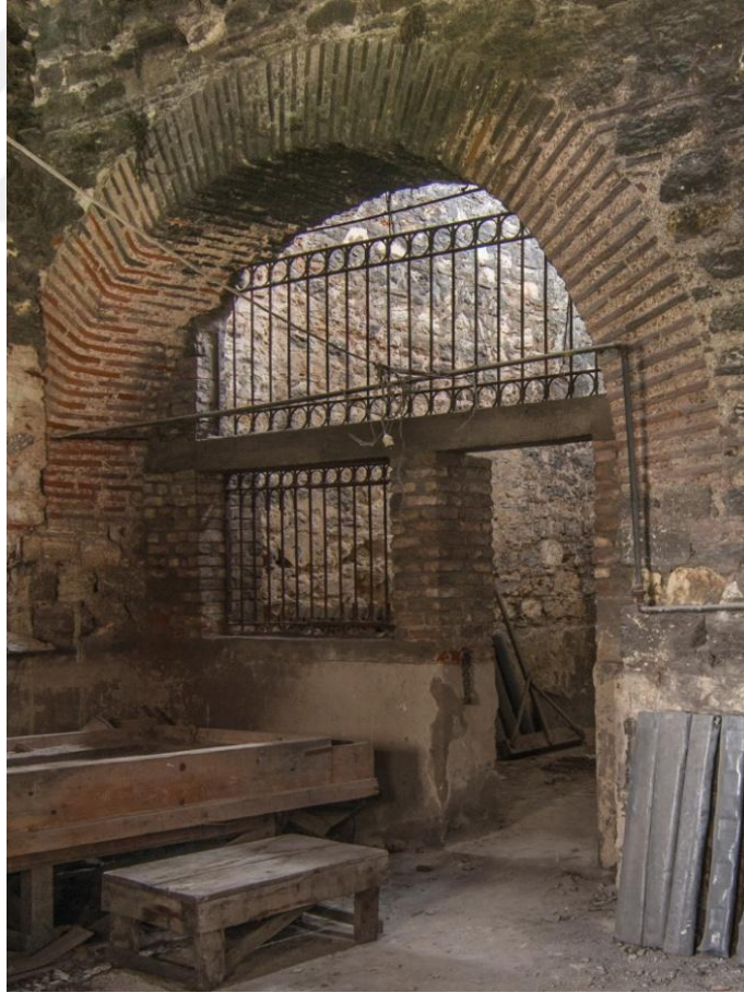
Şekil 2.56. Mekanları ayıran yuvarlak kemerin görünümü
