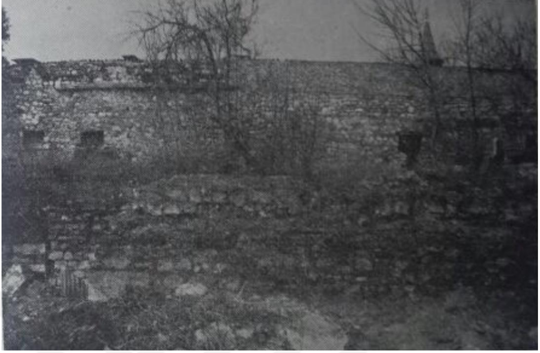
Şekil 2.78. Atölyeler tarafında ayakta kalmış üst yapıya ait duvar kalıntısı (Tezcan, 1984)
