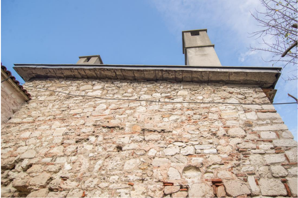
Şekil 2.53. Moloz taş-tuğla almalı örgülü kagir duvarın görünümü
