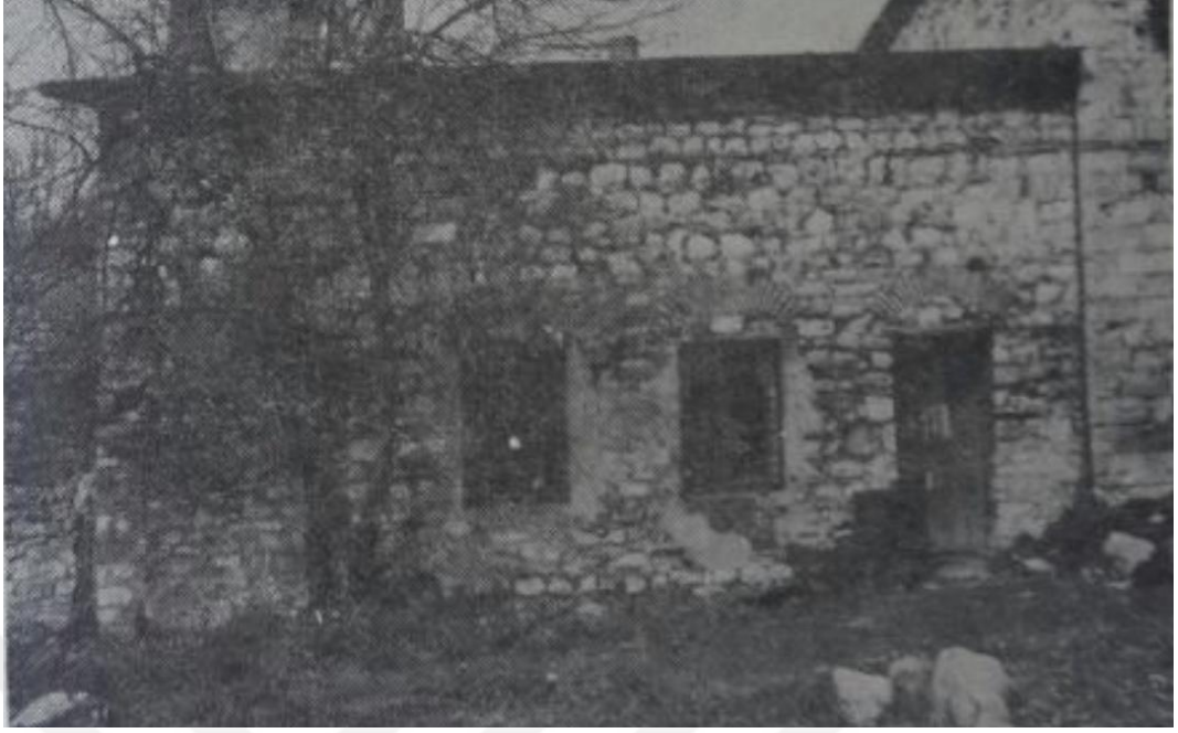
Şekil 2.80. Yapının güneydoğu cephesi (Tezcan, 1984)
