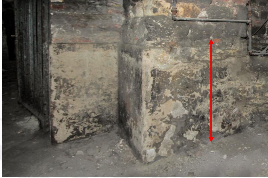
Şekil 2.57. Z01 mekanı iç sıva görünümü
