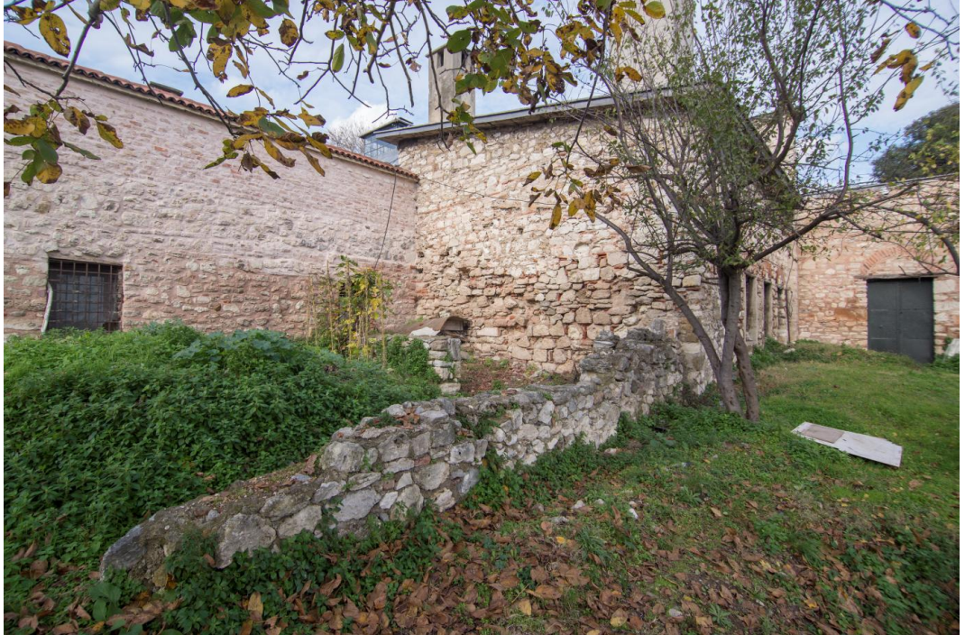
Şekil 2.79. Atölyeler tarafında ayakta kalmış üst yapıya ait duvar kalıntısının günümüzdeki görünümü
