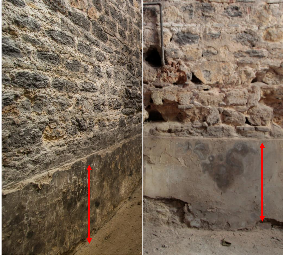
Şekil 2.58. Z02 mekanı iç sıva görünümü
