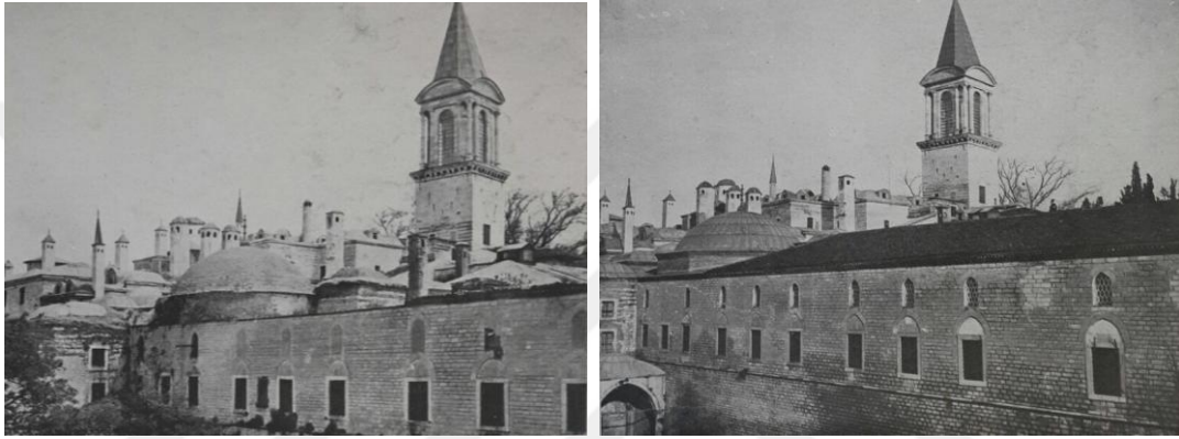
Şekil 2.88. Has ahır çatı ve dış cephesi onarımdan önce, 1939 (solda), onarımdan sonra, 1942 (sağda) (Öz, 1948, p. 13)
