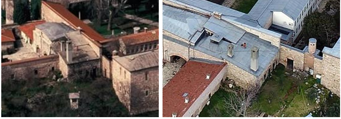
Şekil 2.55. Yapının örtü sisteminde yer alan beton plaklar (solda) (www.istanbullite.com, 2015) ve günümüzde kurşun kaplamaların görünümü (sağda) (Habertürk Gazetesi, 2018)
