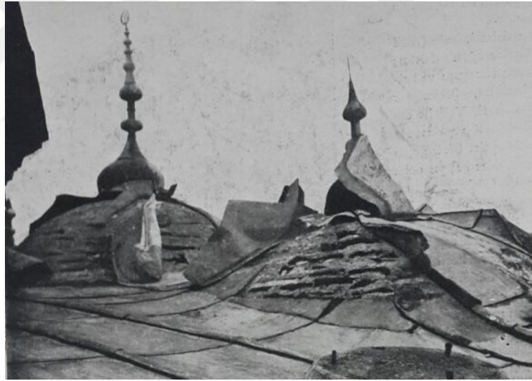
Şekil 2.89. Bir fırtınadan sonra Topkapı Sarayı kubbelerinde kurşun örtülerin açılması (Öz, 1948, p. 68)
