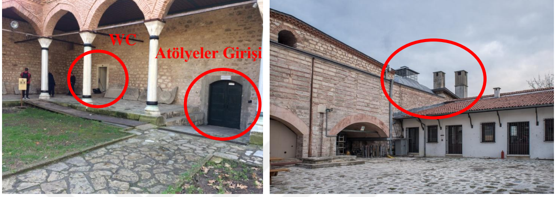
Şekil 2.45. İkinci Avlu revakları ve Dolap Ocağı (Restorasyon Atölyeleri) bölümlerinden görünümler
