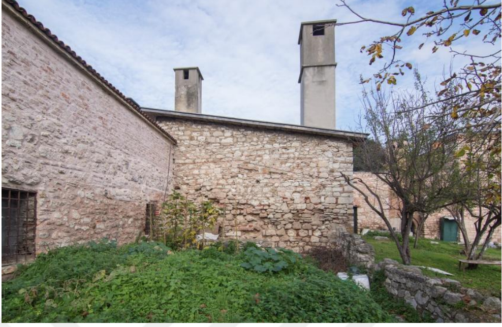
Şekil 2.52. Yapının güneybatı cephesi
