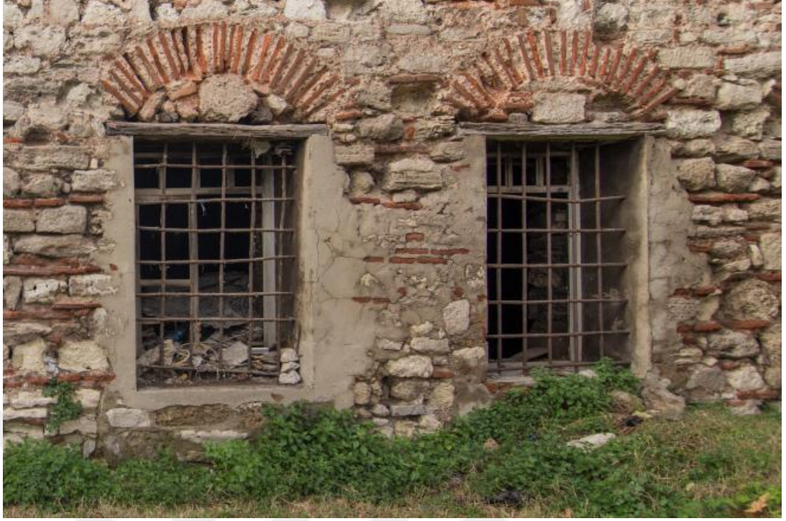
Şekil 2.33. Yapının güneydoğu cephesinde yer alan pencereler
