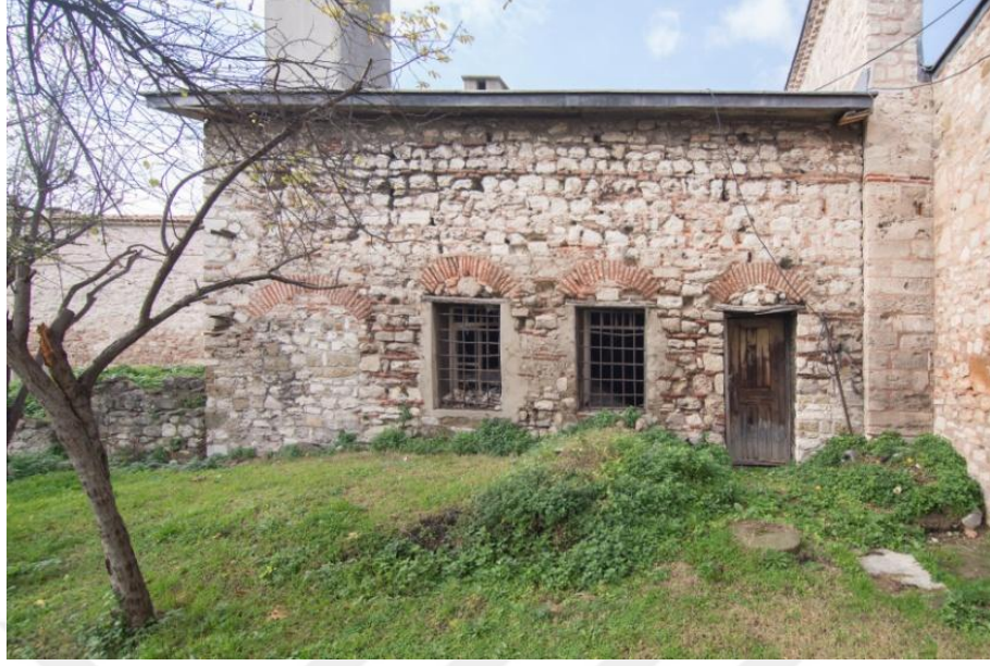
Şekil 2.49. Yapının güneydoğu cephesi
