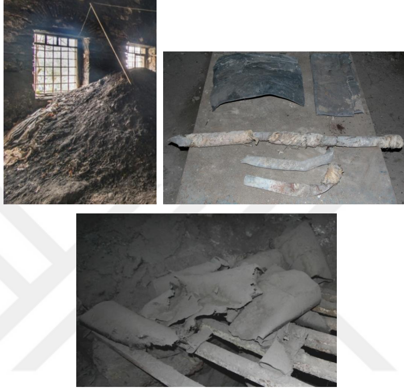
Şekil 2.68. Z01 mekanındaki üretime bağlı birikmeler ve kirlilikler (moloz, kurşun kalıntıları, cüruf vb.)
