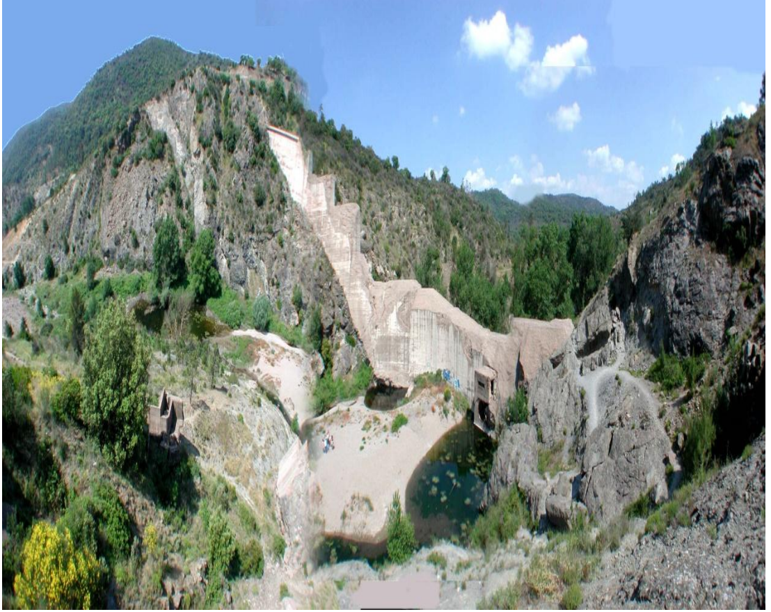
Şekil 2.4 : Yıkılmasından sonra Malpasset Barajı
