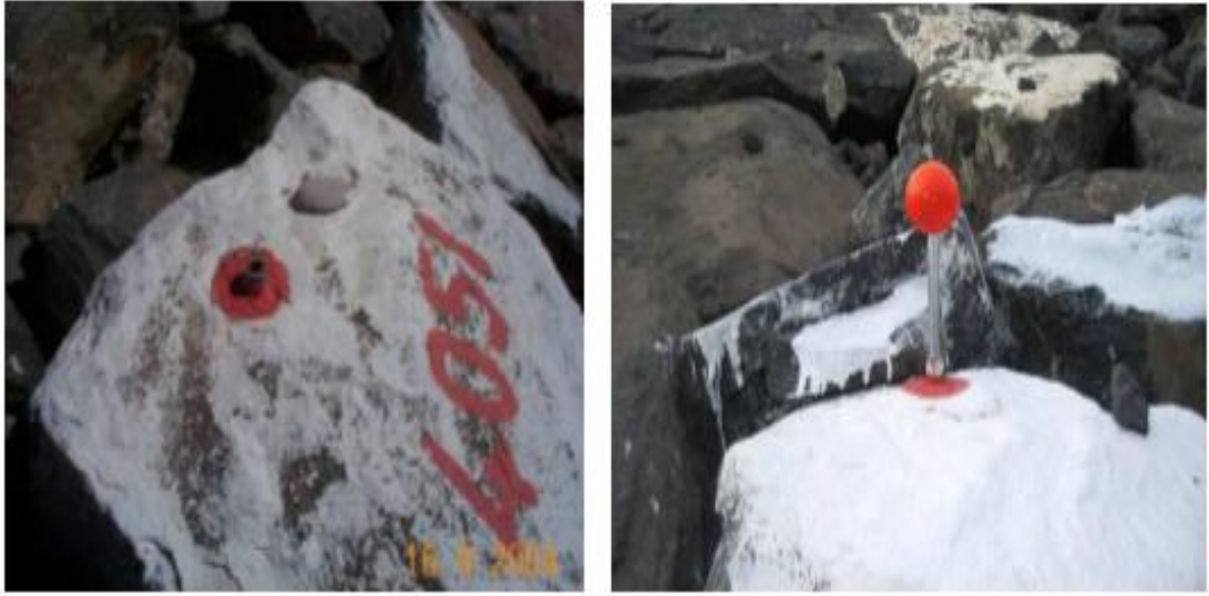
Şekil 5.1 : Obje noktaları için zorunlu merkezlendirilmeli zemin tesisleri (Kalm, 2010)
