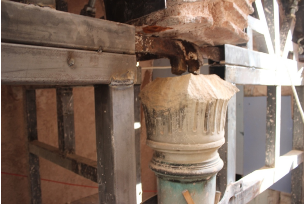
Şekil 3.39 : Sütun başlığında gergi birleşim detayı
