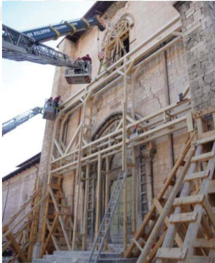
Şekil 3.47 : İtalya L'Aquila St. Domenico Kilisesi'nin ahşap elemanlar ile askıya alınması (Modena ve diğ., 2011)
