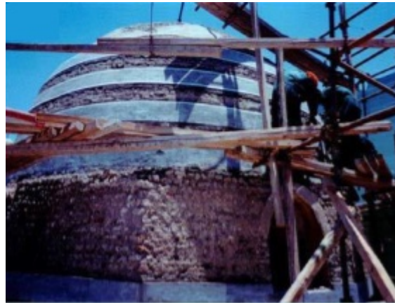
Şekil 3.43 : LP ile Mısır El-Eini Kubbesi'nin güçlendirilmesi (Mahfouz ve Rizk, 2003)
