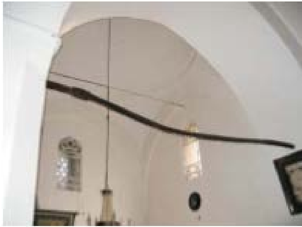
Şekil 3.19 : Vasat Atik Ali Paşa Camiisi - Gergi çubuğunda burkulma (Sesigür ve diğ., 2007)
