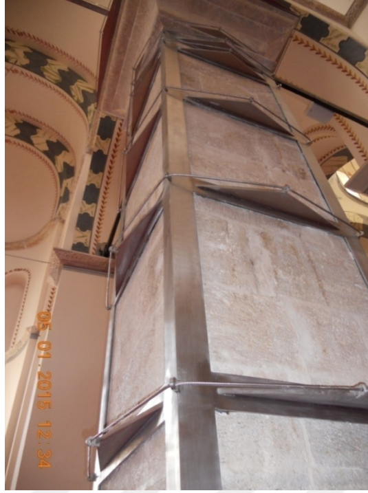
Şekil 3.33 : Öngerilme elemanları ile güçlendirme örneği
