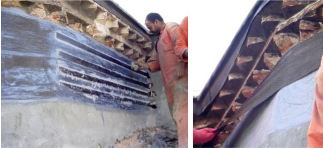
Şekil 3.42 : LP kumaş ile Küçük Ayasofya Camisi'nin güçlendirilmesi (Aköz, 2008)
