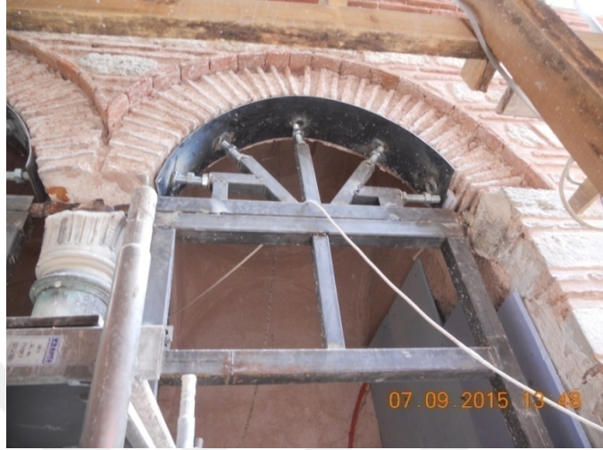
Şekil 3.46 : Çelik elemanlar ile yapının askıya alınması
