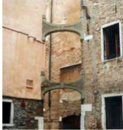
Şekil 3.24 : İki binayı birbirine bağlayan berkitme kemeri (İslam, 2008)
