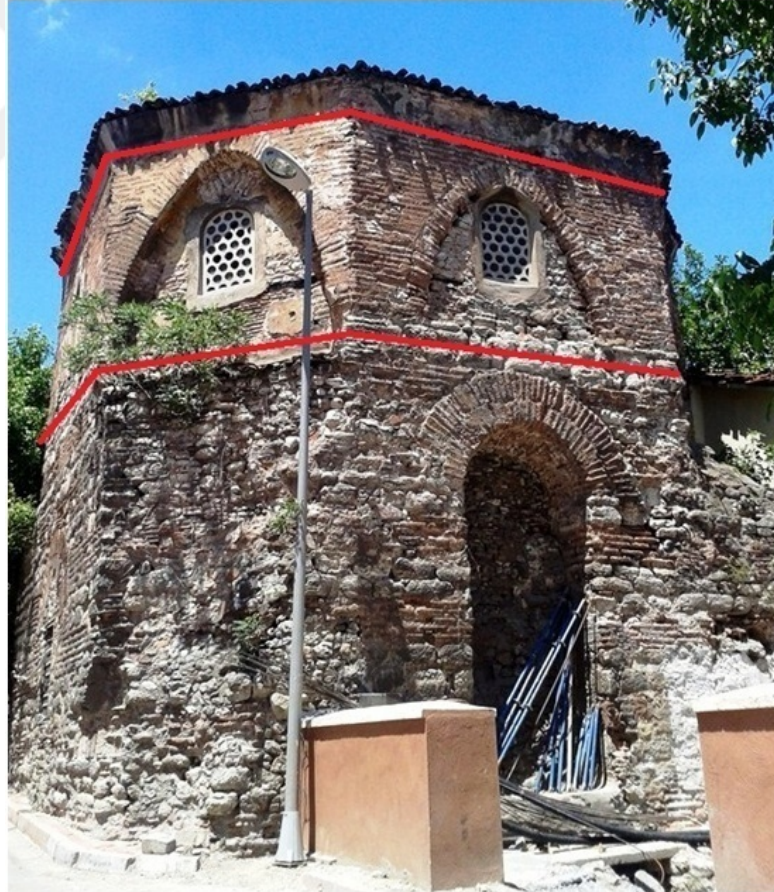
Şekil 4.67 : Çelik çubukların yerleştirilmesi önerilen bölgeler
