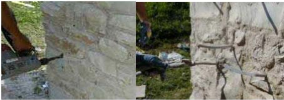
Şekil 3.22 : Enjeksiyon yapımı (da Porto ve diğ., 2003)
