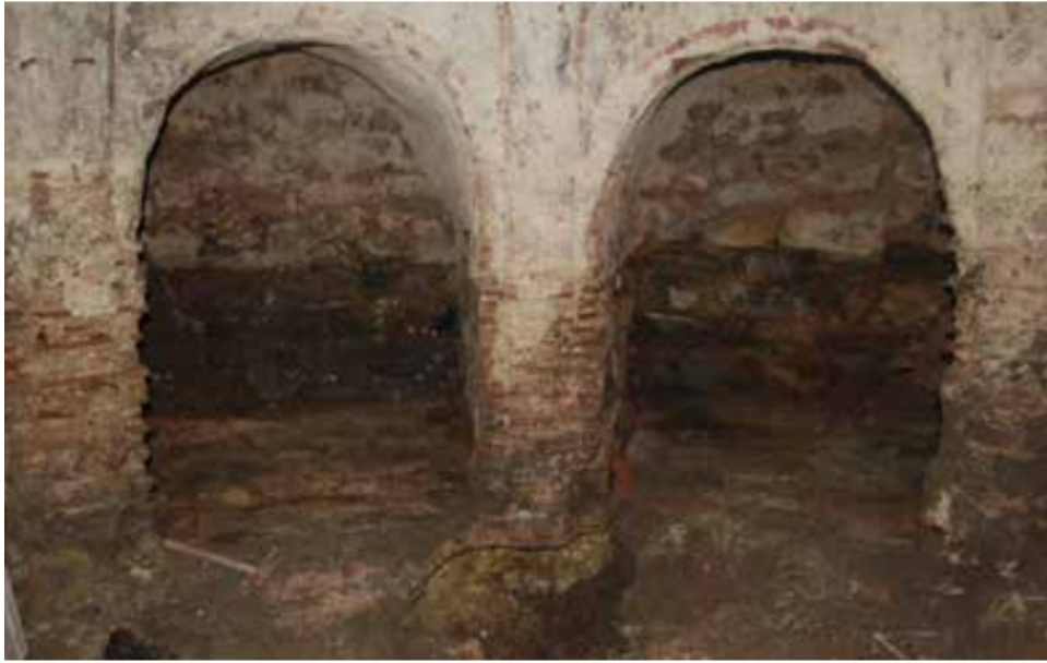
Şekil 4.6 : Krypta iç görünüşü (Url-1, 2015)
