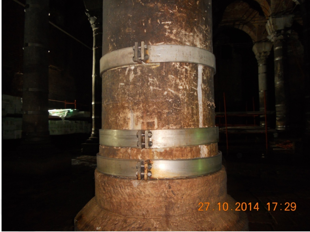
Şekil 3.29 : Sütunlarda çekme çemberi ile güçlendirme örneği detayı
