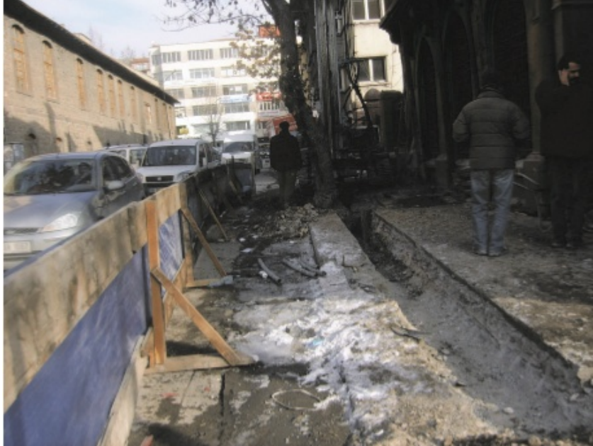
Şekil 3.45 : Eski Tekel Binası temel güçlendirmesi 2 (Özdemir, 1997)
