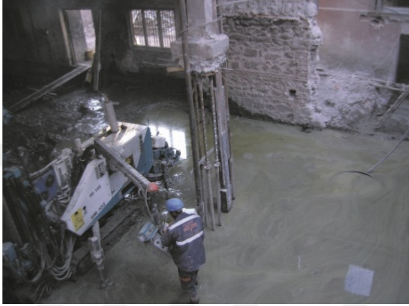
Şekil 3.44 : Eski Tekel Binası temel güçlendirmesi 1 (Özdemir, 1997)
