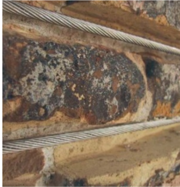
Şekil 3.32 : İtalya Padova Saat Kulesi'nin çelik çubuk ile güçlendirilmesi (Modena ve diğ., 2011)
