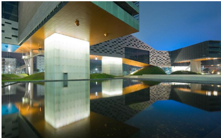
Şekil 3.12 : Horizontal Skyscraper/ Vanke Center, Karma Kullanım(Sergi, Ofis, Park), Steven Holl Architects, 2009 (URL-28).
