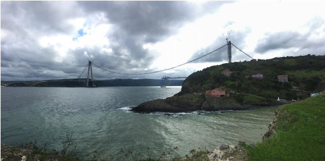
Şekil 3.24 : Yavuz Sultan Selim Köprüsü inşa çalışmaları sırasında Garipçe Köyü'nden görünüş (fotoğraf: Meliz Akyol).
