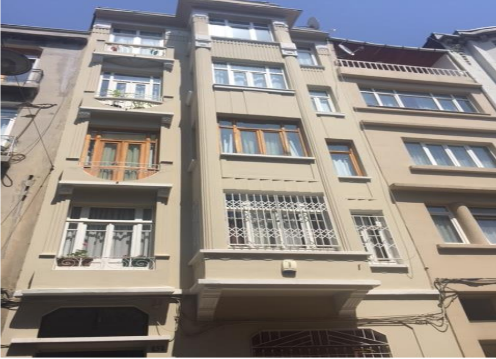
Şekil 3.3: Güneşli Sokak, No:32, Ada:651, Parsel:5
