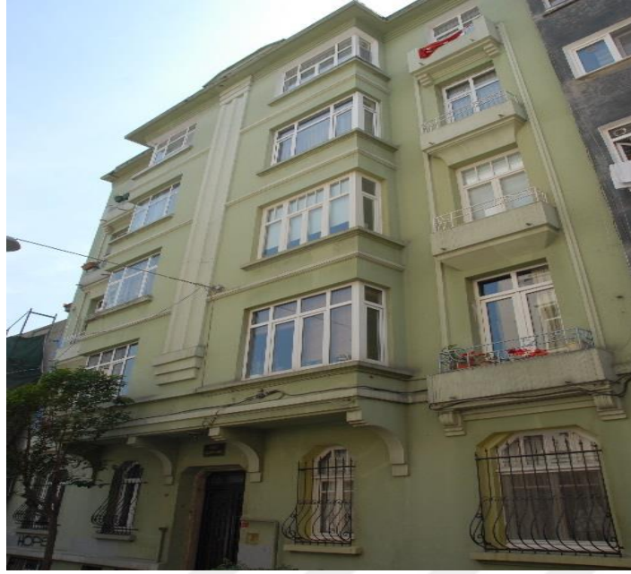
Şekil 3.23: İkinci Sigorta Han Apartmanı, No:1, Ada:644, Parsel:36
