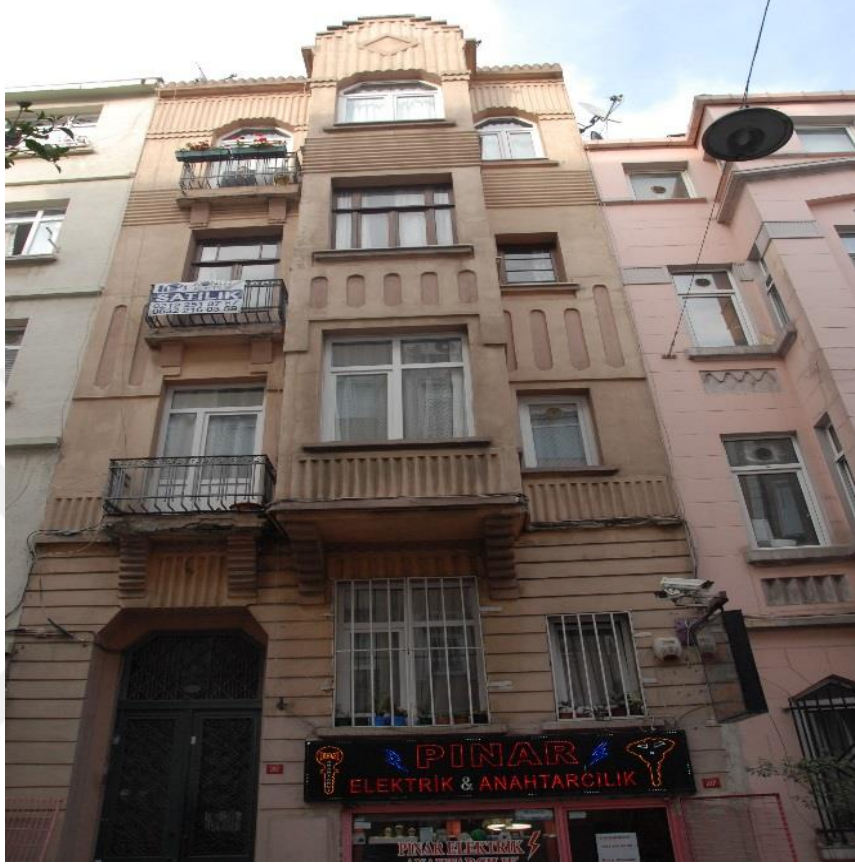
Şekil 3.62: Güneşli Sokak, No:20, Ada:38, Parsel:16
