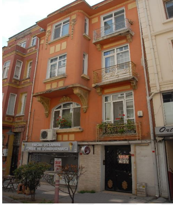
Şekil 3.37: Bakraç Sokak No:9, Ada:644, Parsel:30
