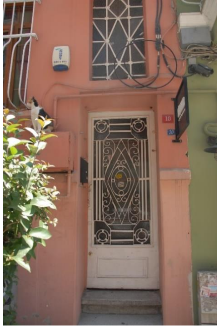
Şekil 3.28: Havyar Sokak Giriş Kapısı, No:10, Ada:48, Parsel:43
