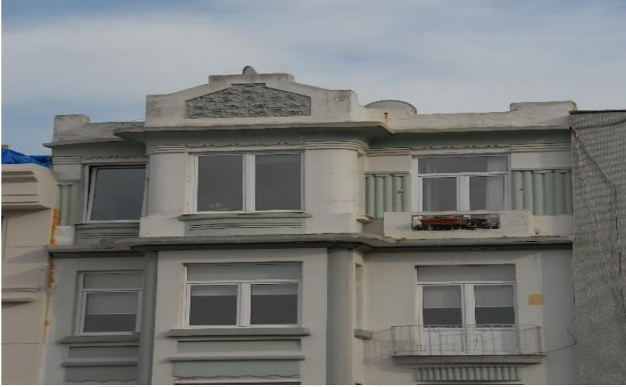
Şekil 3.60: Lenger Sokak, No:5, Ada:38, Parsel:22
