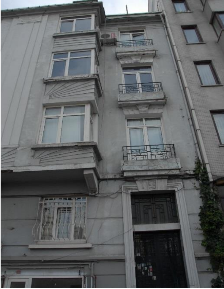
Şekil 3.26: Güneşli Sokak Giriş Kapısı, No:21, Ada:650, Parsel:1
