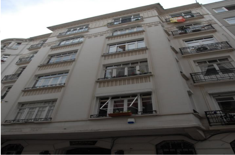
Şekil 3.7: Santral Apartmanı, Şimşirci Sokak, No:6, Ada:47, Parsel:9
