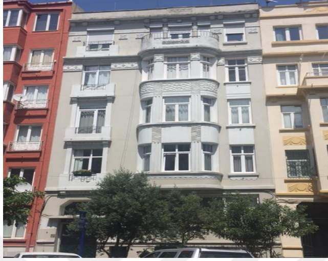
Şekil 3.46: Kaptan Apartmanı, Cihangir Caddesi, No:16, Ada:37, Parsel:46
