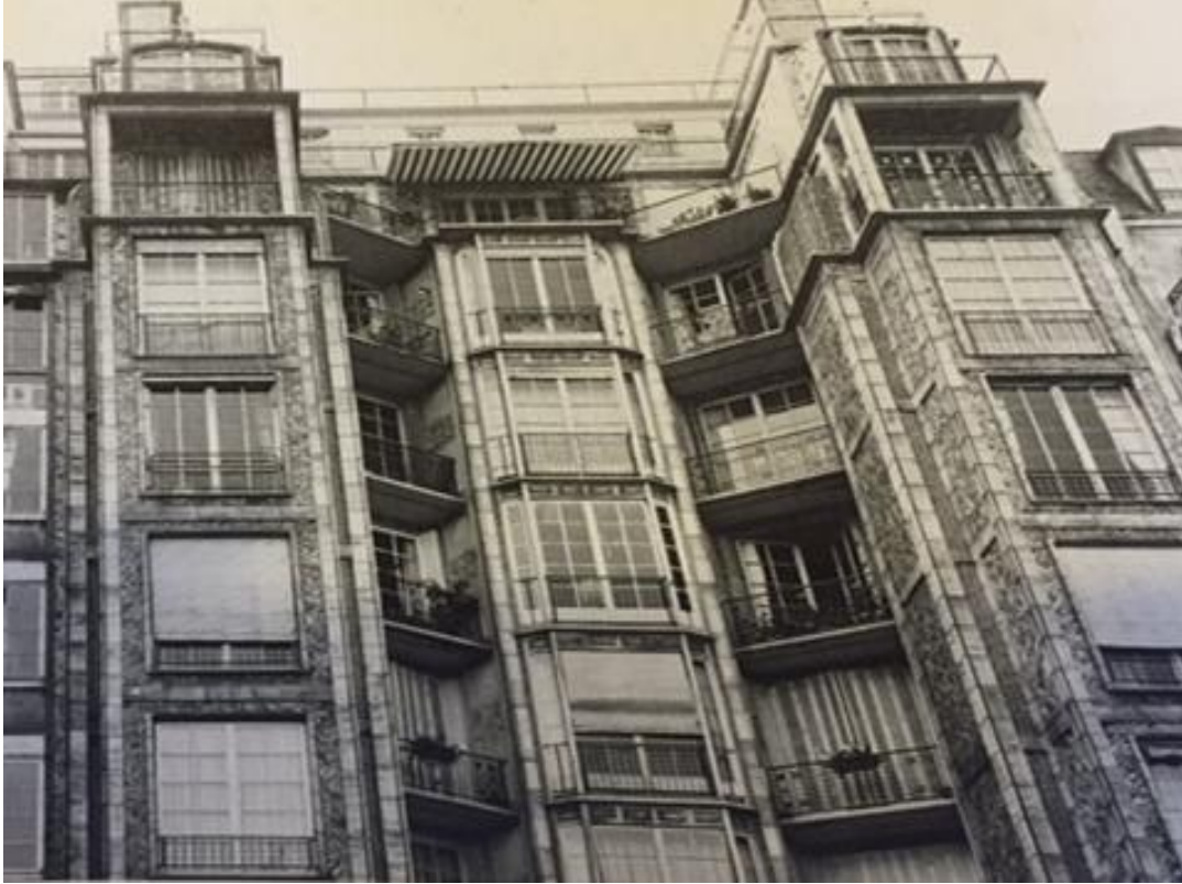
Şekil 2.9: Auguste Perret Apartmanı, Paris,1902, (Bayer, 1992,s.26)
