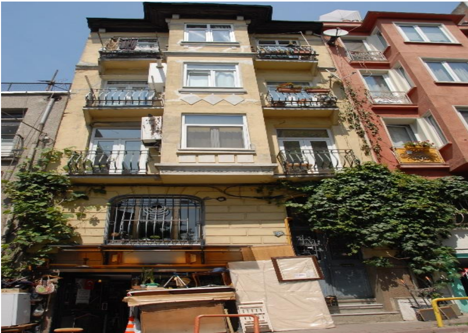
Şekil 3.13: Bakraç Sokak, No:28, Ada:647, Parsel:46
