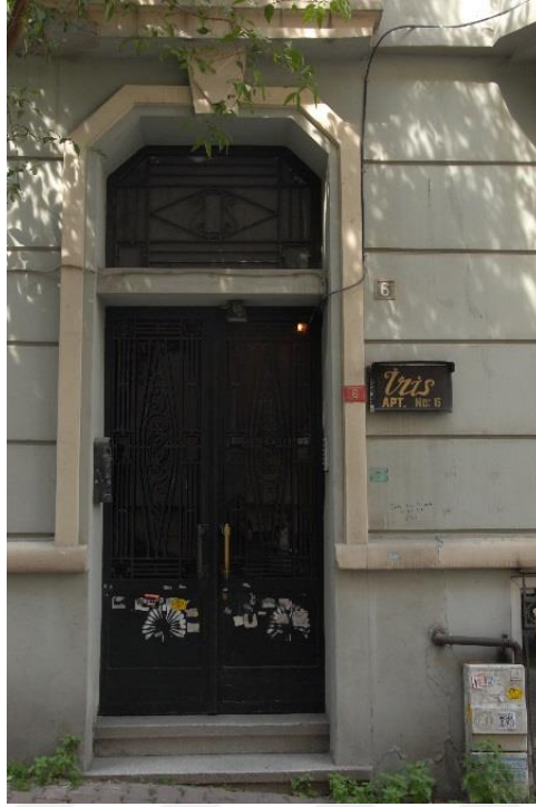
Şekil 3.10: İris Apartmanı, Yeni Yuva Sokak, No:6 Ada:644, Parsel:2
