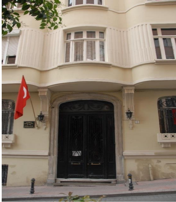
Şekil 3.45: Şimşirci Sokak, No:1, Ada:48, Parsel:34
