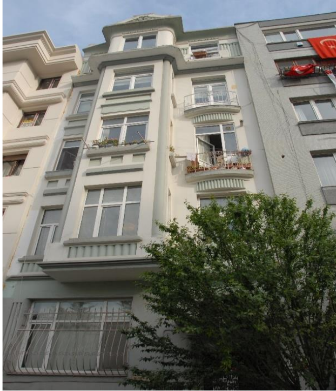
Şekil 3.61: Lenger Sokak, No:5, Ada:38, Parsel:22
