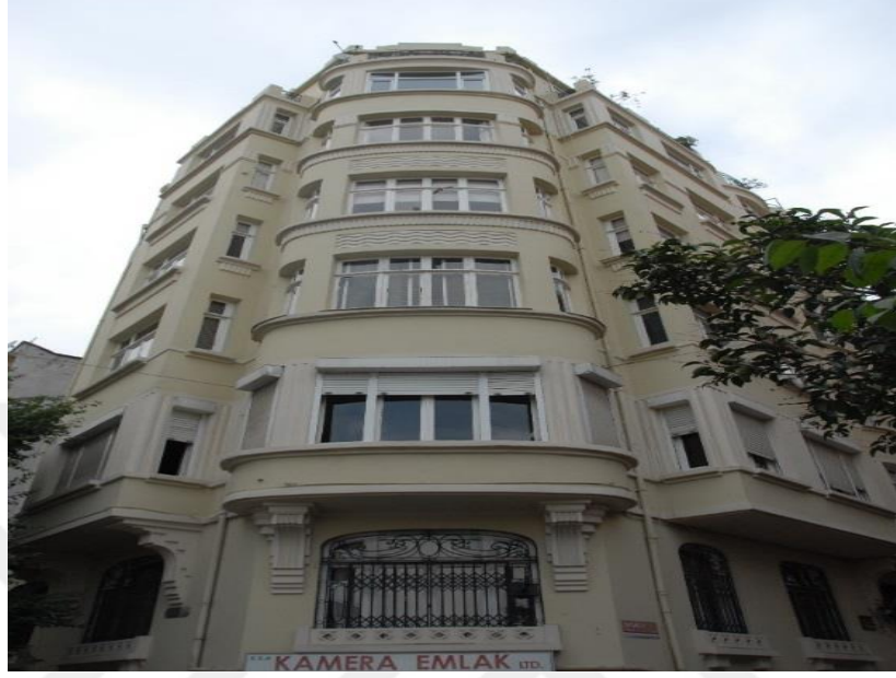
Şekil 3.44: Şimşirci Sokak, No:1, Ada:48, Parsel:34
