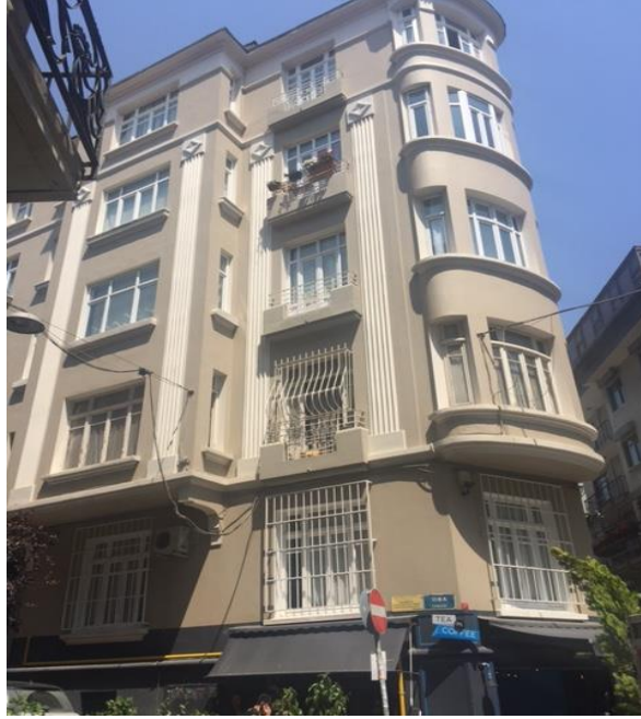
Şekil 3.76: Oba Sokak, No:12, Ada:647, Parsel:42
