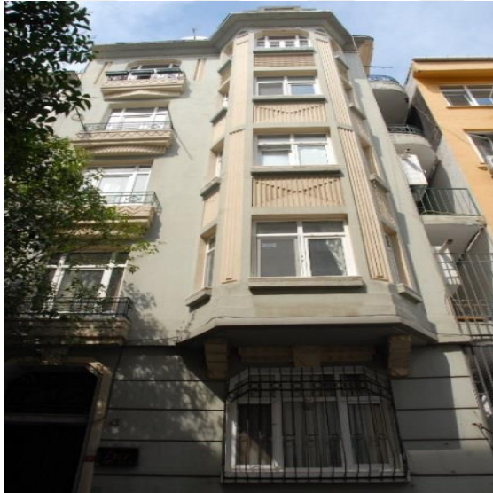
Şekil 3.11: İris Apartmanı, Yeni Yuva Sokak, No:6 Ada: 644, Parsel:2
