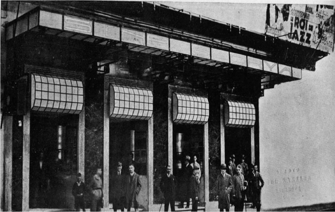
Şekil 2.52: Glorya Sineması Cephe Görünüşü, (Arkitekt, Sayı:2, 1931)
