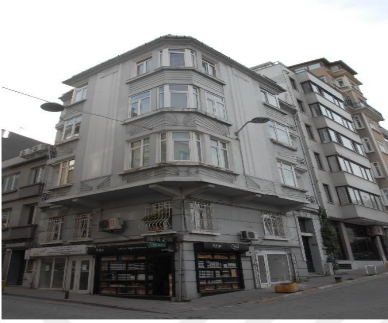
Şekil 3.25: Güneşli Sokak No:21, Ada:650, Parsel:1
