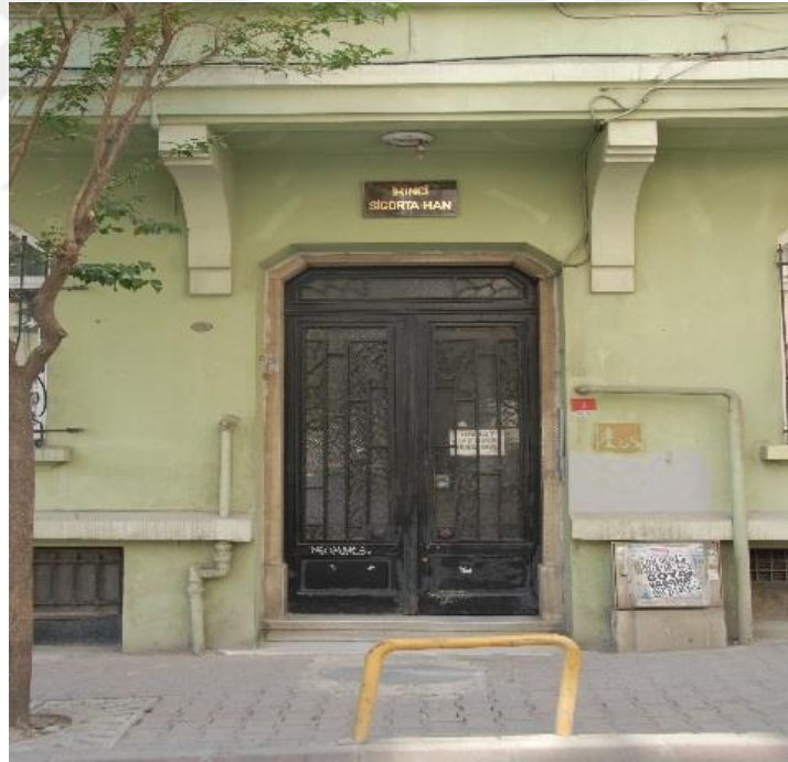
Şekil 3.24: İkinci Sigorta Han Apartmanı Giriş Kapısı, No:1, Ada: 644, Parsel:36
