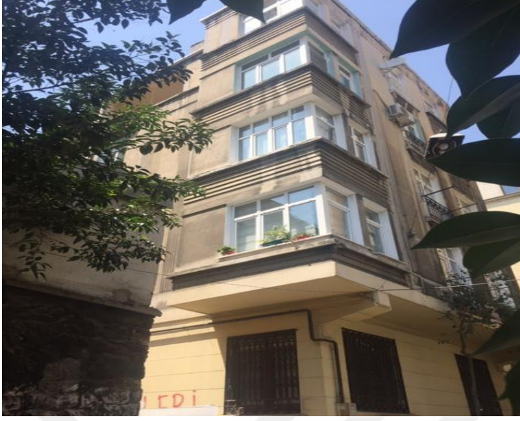
Şekil 3.8: Arslanyatağı Sokak, No:5, Ada:655 ,Parsel:18
