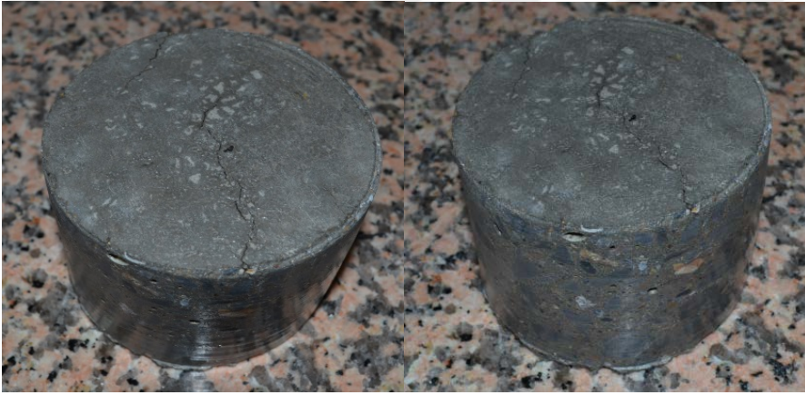
řekil 4.32 : Kür çatlađı bulunan beton silindir numune örnekleri.
