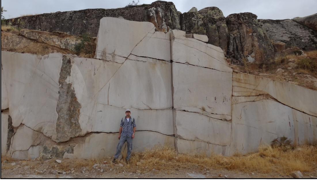
Şekil 4.25 : Ocak üretim kademelerinde bulunan farklı konumdaki çatlakların görünümü.
