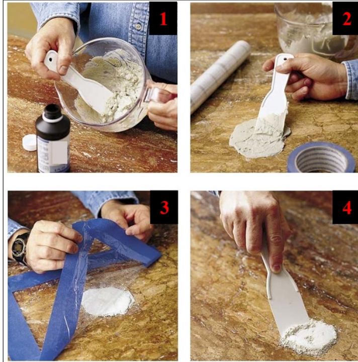
Şekil 5.64 : Doğal taş yüzeyindeki pas lekelerinin temizlenmesinde kullanılan “poultice” karışımının uygulama aşamaları (Url-15).
