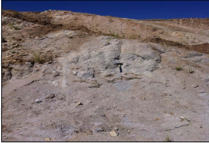
Şekil 4.21 : Granit blok taş ocağının üst kesimlerinde gözlenen ayrışma zonu.
