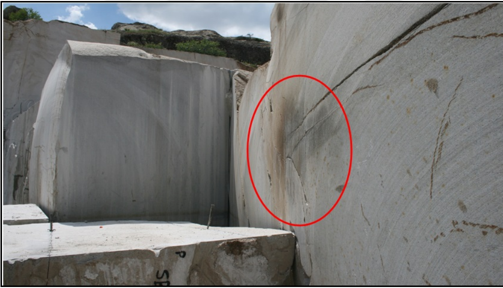
Şekil 4.42 : Üretim kademelerinde pirit oksidasyonu sonucu oluşan pas lekeleri.
