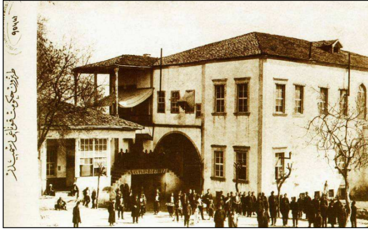
Şekil 7.29 : 20.yüzyıl başlarında Trabzon Hükümet Konağı, Yıldız Albümleri (Yazıcı, 2008, s.958).
