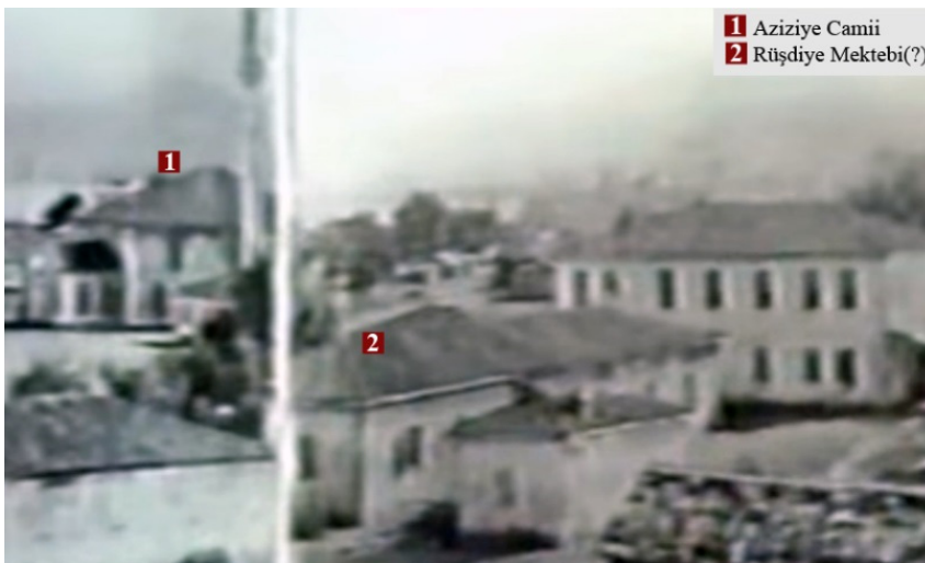
Şekil 7.51 : Aziziye Camii ve Rüştiye mektebi konumunda inşa edilen yapı (ZMA).
