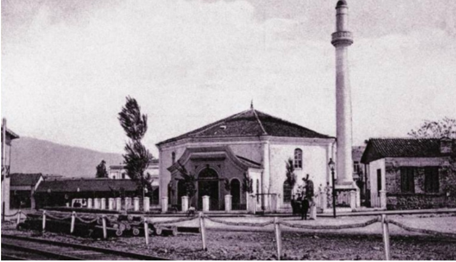
Şekil 7.34 : Aziziye Camii ön cephe görünüşü (Yedikıta Dergisi, sayı:53, s:56).
