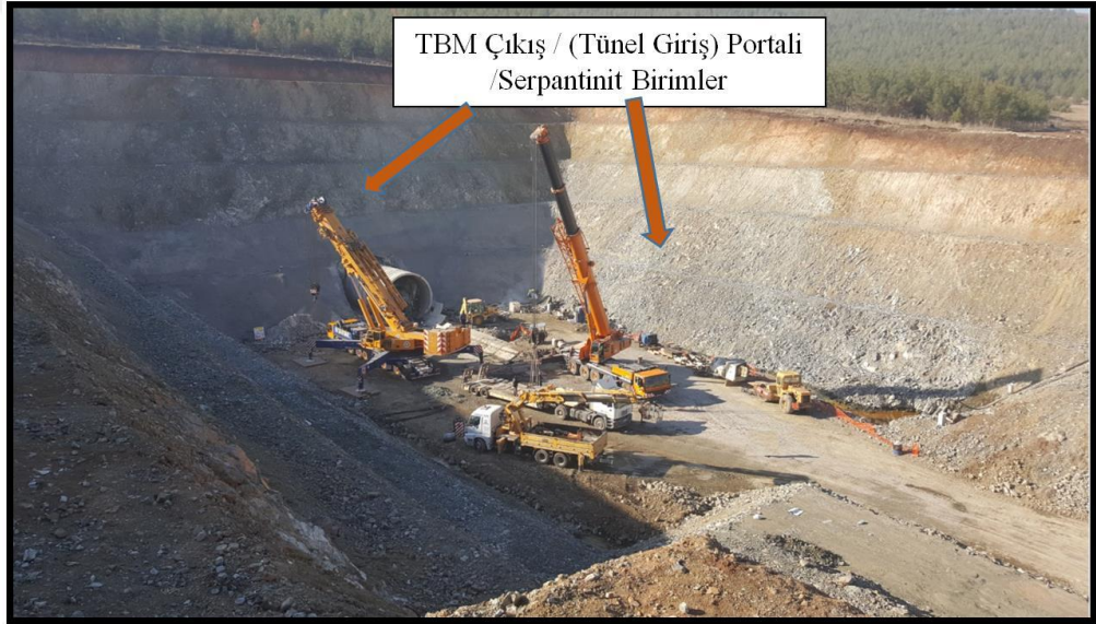
Şekil 3.5: TBM çıkış portalı genel görünümü.
