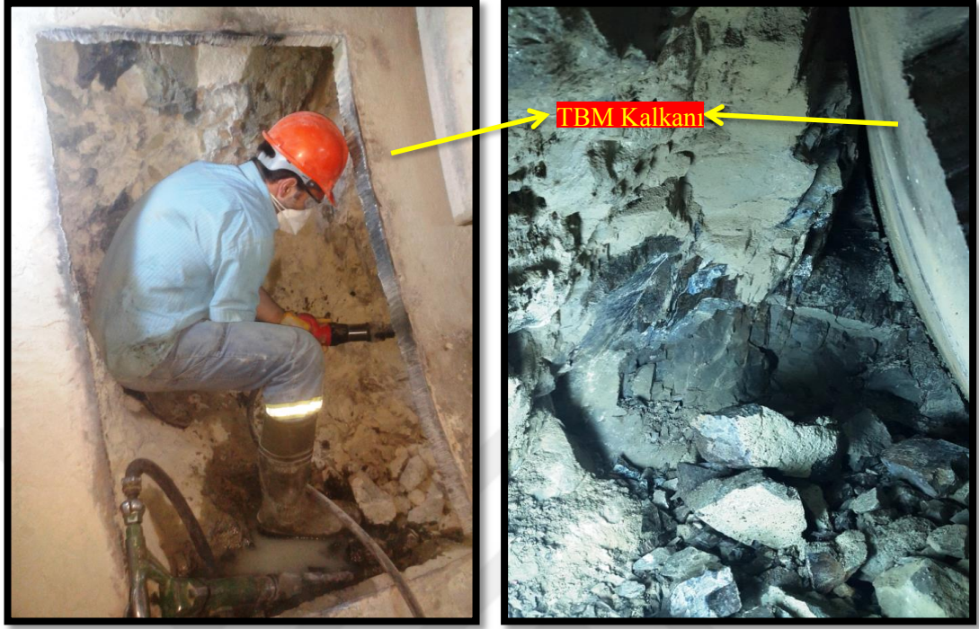
Şekil 6.4: TBM kalkanı etrafında yapılan patlatma çalışmaları.
