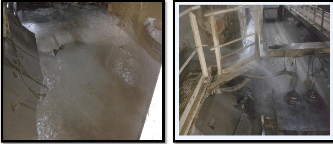
Şekil 6.3: Tünele basınçlı su ve ince daneli zemin girişi.
