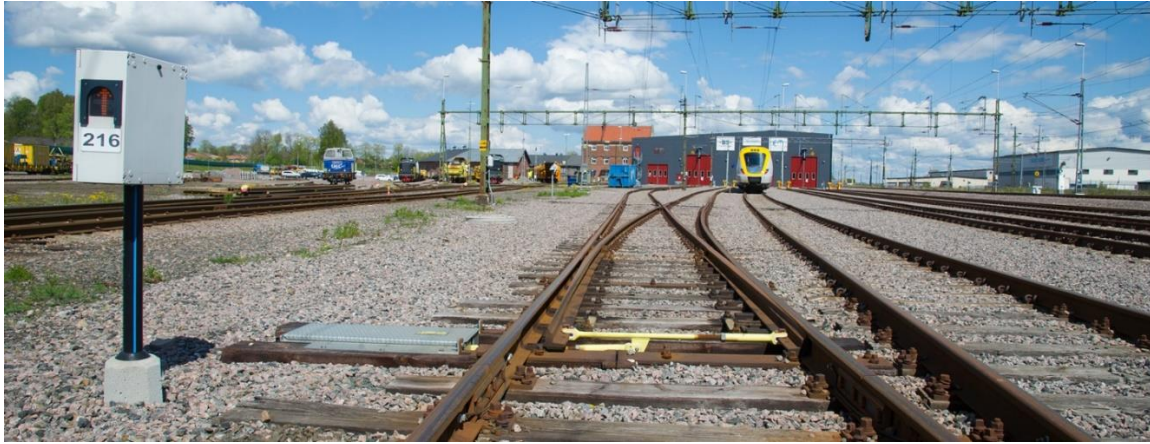
Şekil 7: Trenlere hareket kabiliyeti kazandıran makaslara örnek.
