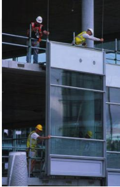
Şekil 3.6 : Panel sistem dış duvar örneği (Url-8).
