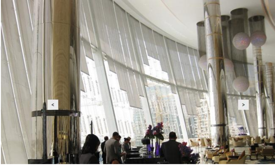
Şekil 3.19 : İçten uygulanan güneş kontrol elemanı örneği; Abu Dhabi Hotel, Abu Dhabi, United Arab Emirates (Url-15).
