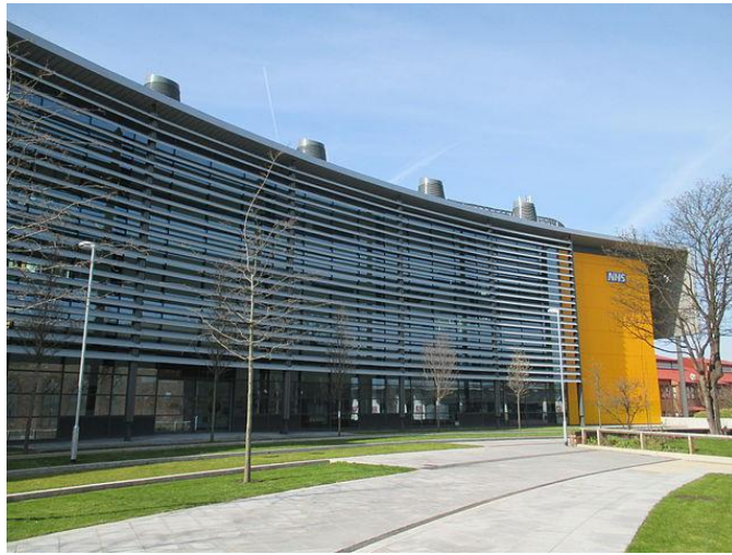
Şekil 3.18 : Sabit alüminyum lamel güneş kontrol elemanı örneği; St Catherine's Health Centre, Birkenhead, Merseyside (Url-14).
