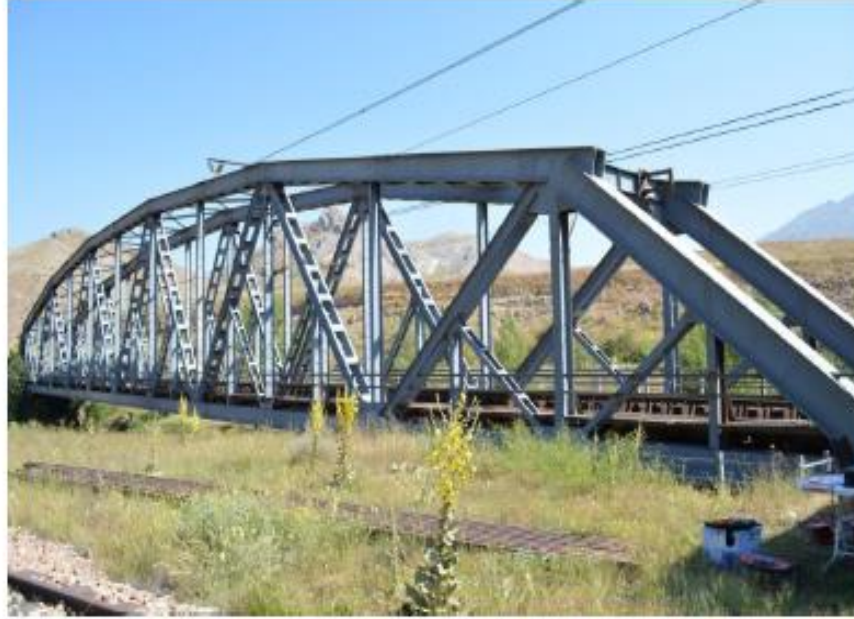
Şekil 2.1: Köprünün genel görünüşü.
