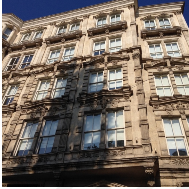
Şekil 5.3 : Onarım gören bir cephenin durumu.
