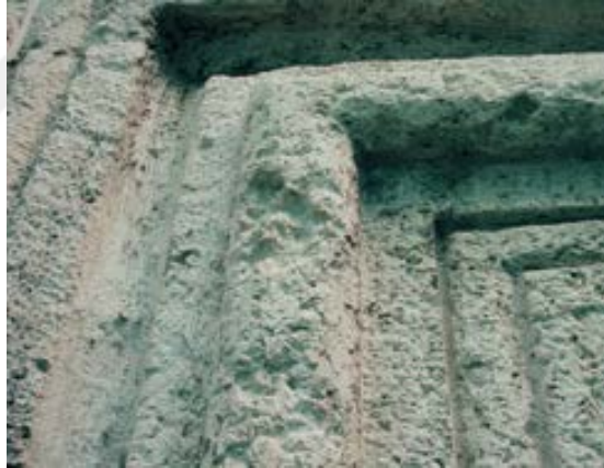
Şekil 3.4 : Kireçtaşının alçıtaşına dönüşmesi ve yıkanarak çözünmesi sonucu oluşan 5 cm'den az yüzey kaybı (Verdön ve Ersen, 2009, s. 12).
