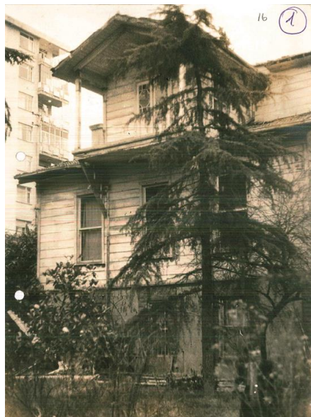
Şekil 3.64: 29 EN yapı – cephe kaplama malzemesi genişliğini gösteren fotoğraf.
