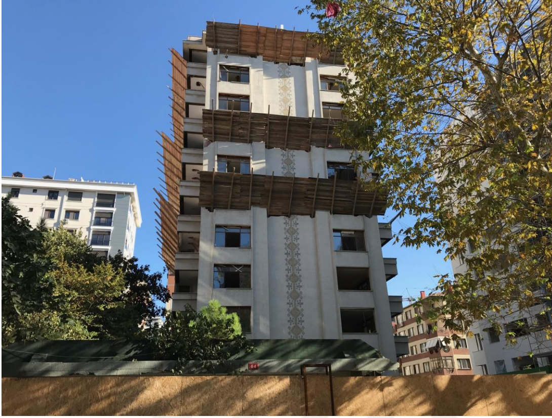
Şekil 2.14 : Çalışma alanında yer alan, kentsel dönüşüm kapsamında yıkılmakta olan bina (Eki.2017).
