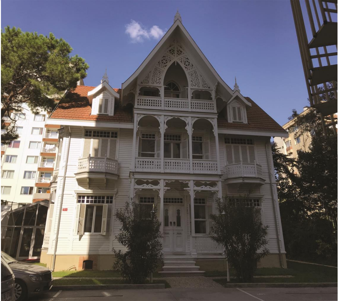
Şekil 3.18 : 4 envanter numaralı yapının çalışma kapsamında çekilmiş fotoğrafı (Ekim 2017).
