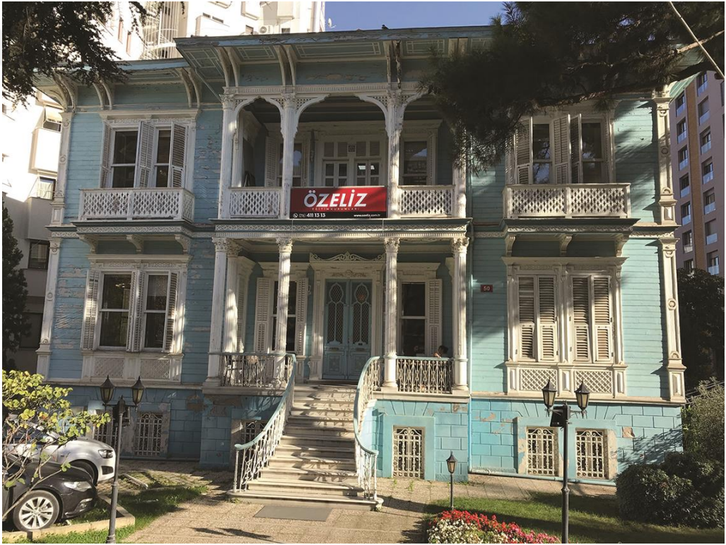
Şekil 3.21 : 31 envanter numaralı yapının çalışma kapsamında çekilmiş fotoğrafı (Ekim 2017).
