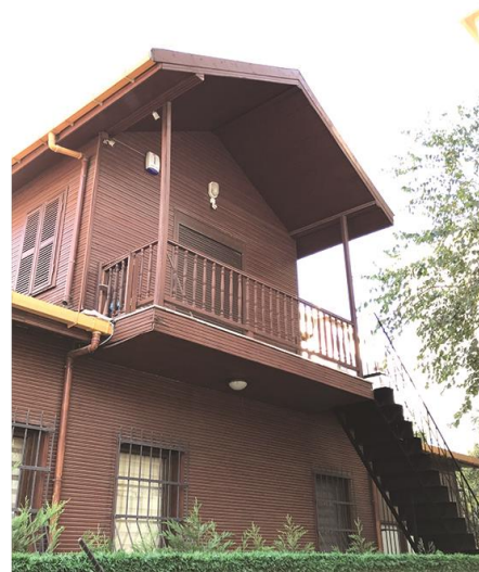
Şekil 3.64: 29 EN yapı – cephe kaplama malzemesi genişliğini gösteren fotoğraf.
