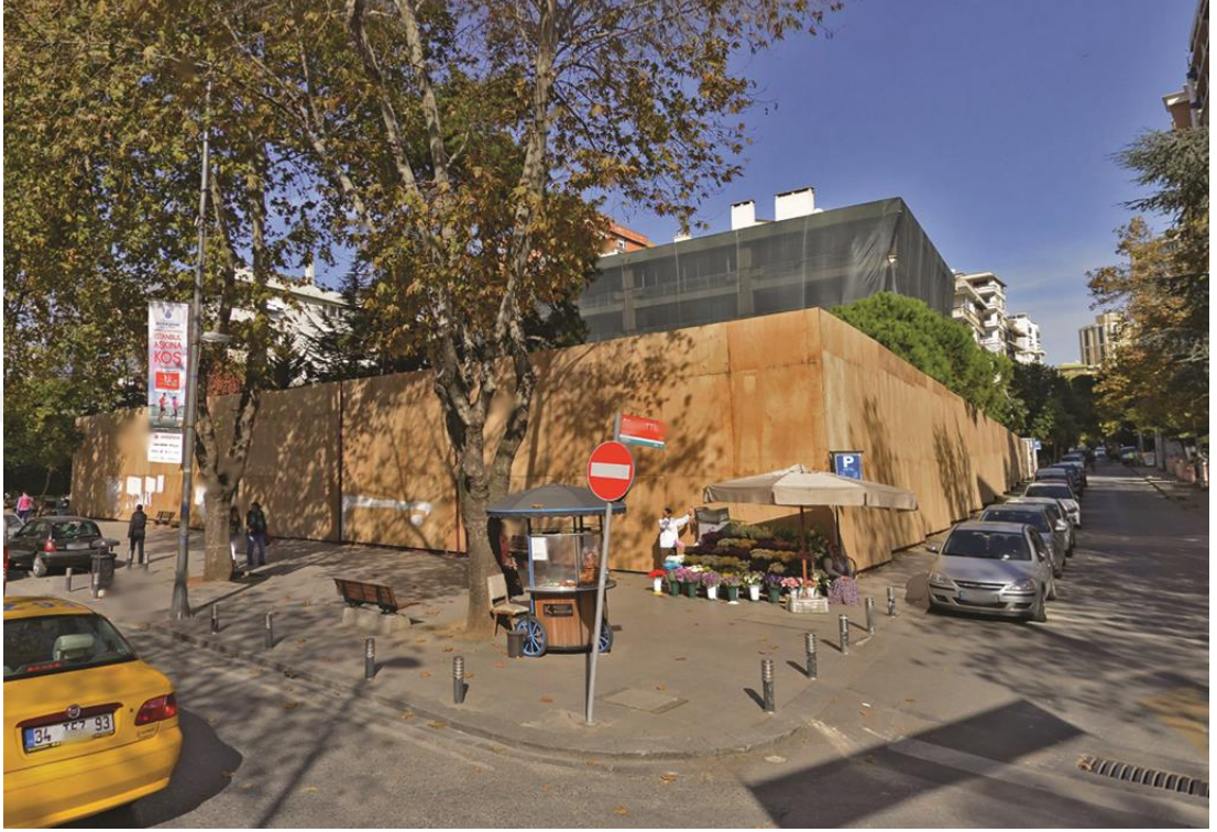
Şekil 2.15 : Kültür varlığı olarak değerlendirilen apartmanın yıkım aşamasını gösteren fotoğraf (2015)
