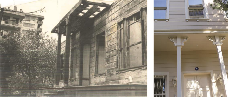
Şekil 3.65 : 18 EN yapı – ahşap işçilik detaylarının değiştiğini gösteren fotoğraf.
