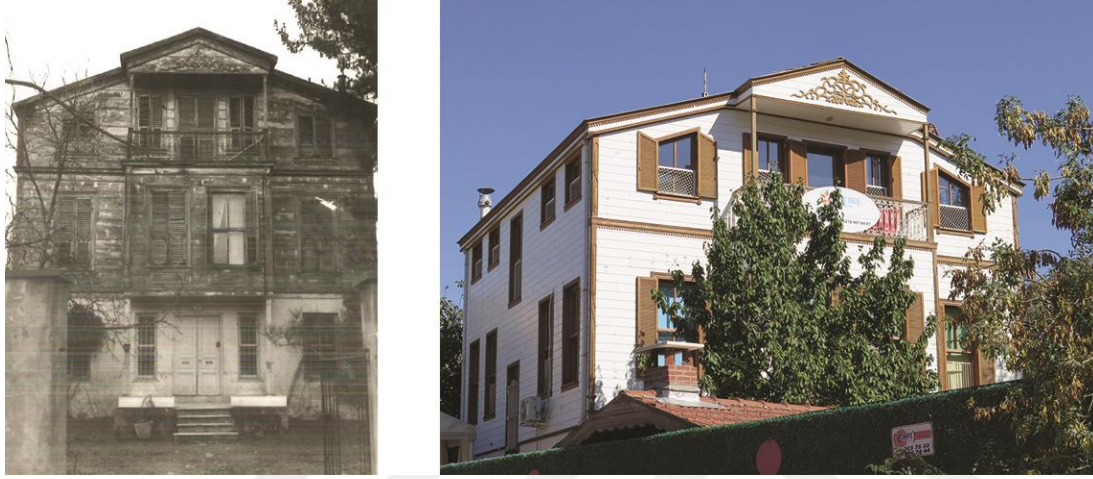
Şekil 3.28 : 14 envanter numaralı yapının özgün ve güncel durumlarını gösteren fotoğraflar (İ5NKVKBK Arşivi ve çalışma kapsamında çekilmiş).
