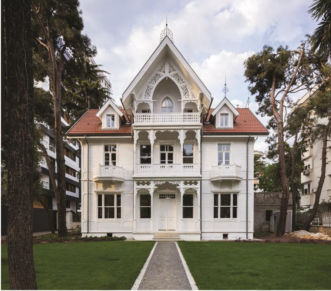
Şekil 3.19 : Cavut Paşa Köşkü'nün fotoğrafı ( http://www.altkat.com ).
