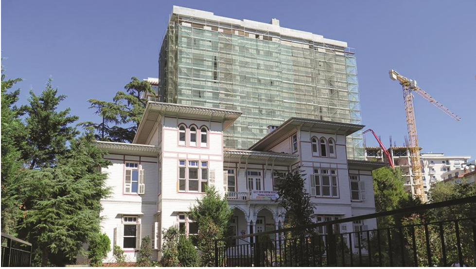
Şekil 4.19 : Çalışma kapsamında çekilen, kültür varlığı konut yapısı çevresinde devam etmekte olan inşaat faaliyetlerini gösteren fotoğraf (Ekim 2017).
