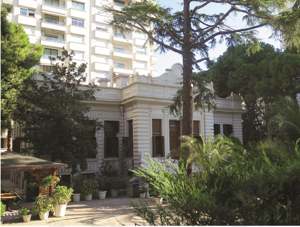
Şekil 3.16 : 45 envanter numaralı yapının çalışma kapsamında çekilmiş fotoğrafı (Ekim 2017).
