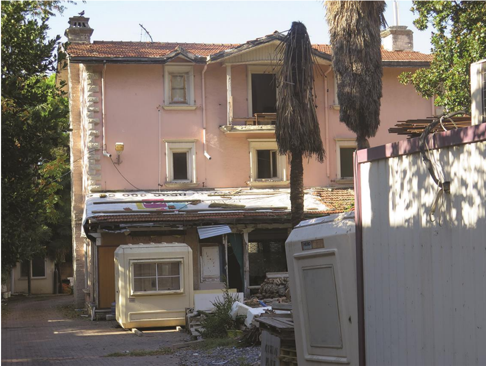
Şekil 3.13 : 44 envanter numaralı yapının çalışma kapsamında çekilmiş fotoğrafı (Ekim 2017).
