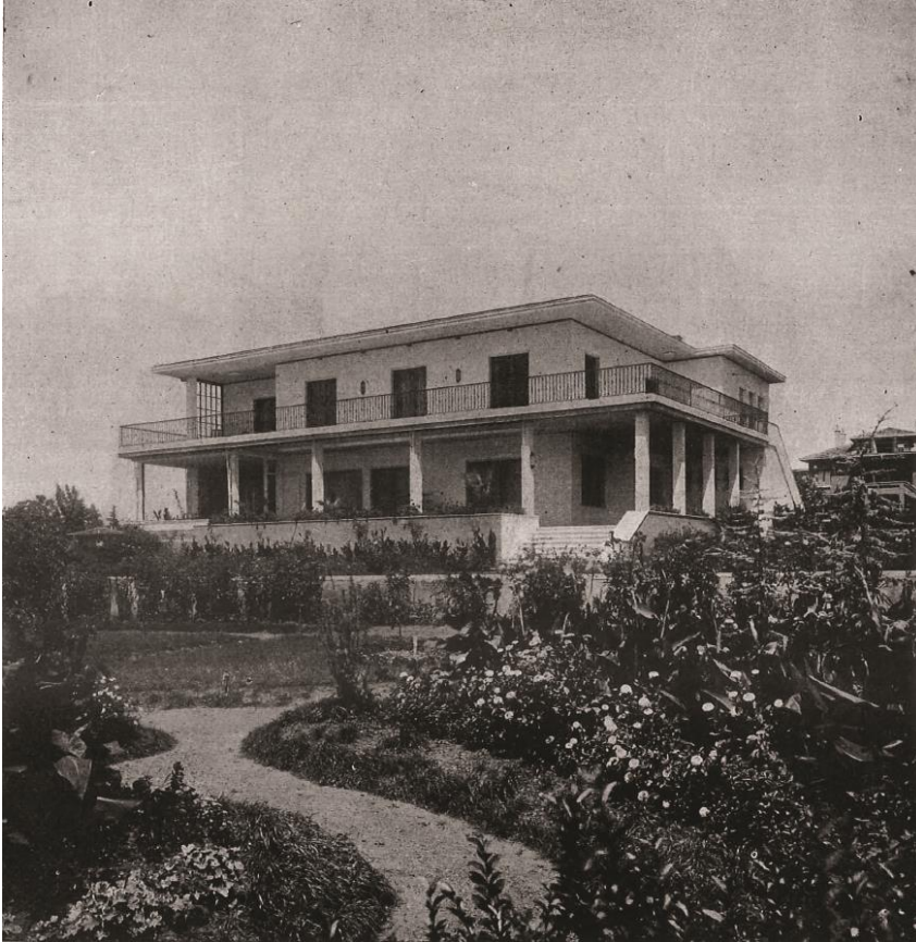
Şekil 3.38 : 38 envanter numaralı yapının özgün durumunu gösteren fotoğraf (Arkitekt Dergisi).
