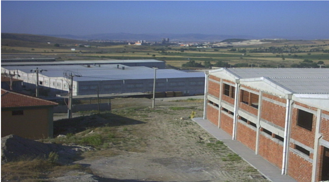
Şekil 26: Balıkesir Organize Sanayi Bölgesinden bir görünüm. Arka planda Balıkesir Çimento Fabrikası ve Balıkesir kenti görünmekte.
