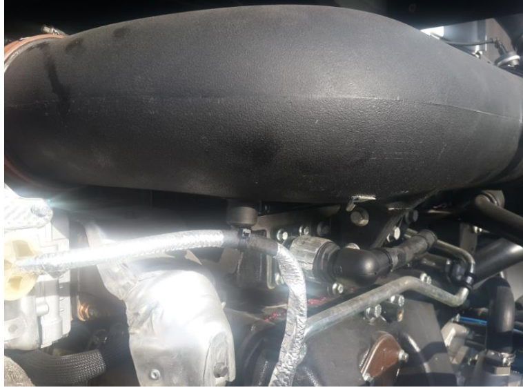
Şekil 2.10 : EGR ünitesine dayanak oluşturan düşük basınç borusu.
