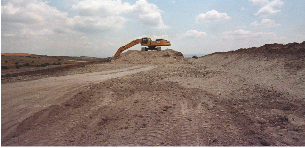
Resim 3: Yeni İnşaat Alanında Diğer Hırsızlık Suçuna Maruz Kalan Dozer.
