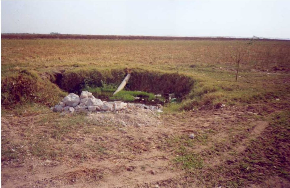
Foto 18: Deniz Yalısı mevkiinde çökme yapmış bir artezyen kuyusu
