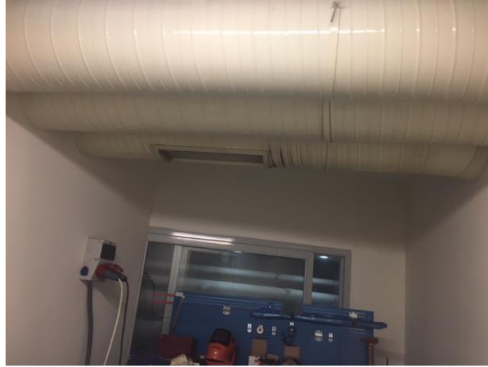
Şekil 6.13 Kaynak odası havalandırma sistemi.
