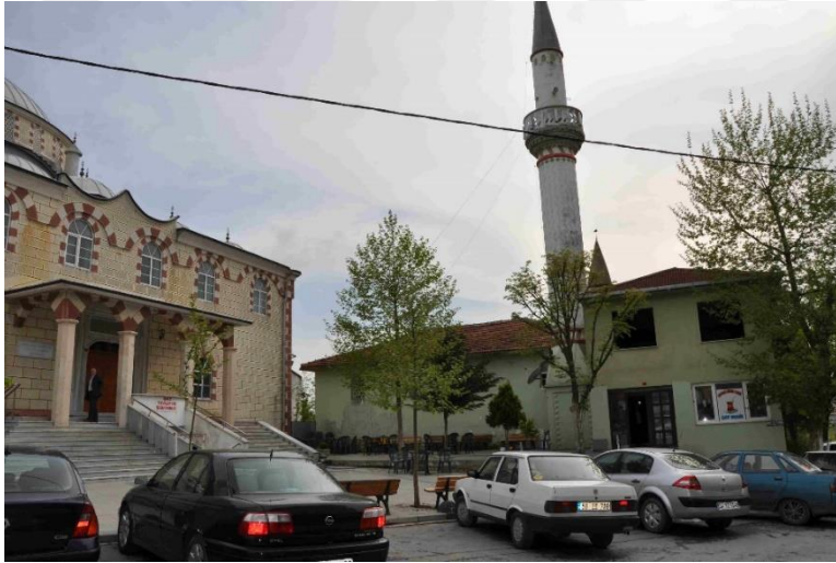
Şekil 3.98 : Haraççı Camisi (ortada), solda 2006 yılında inşa edilmiş Haraççı Merkez Camisi ve sağda tarihi camiye bitişik inşa edilmiş betonarme kahvehane yapısı.
