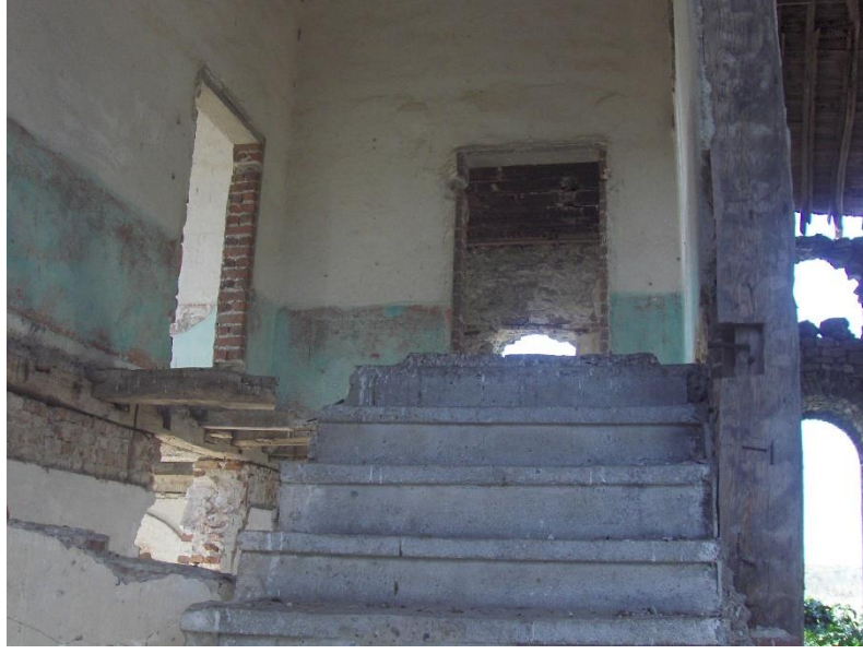
Şekil 3.227 : Değirmenköy Kilisesi okula dönüştürüldüğünde eklenen betonarme merdiven ve döşeme.
