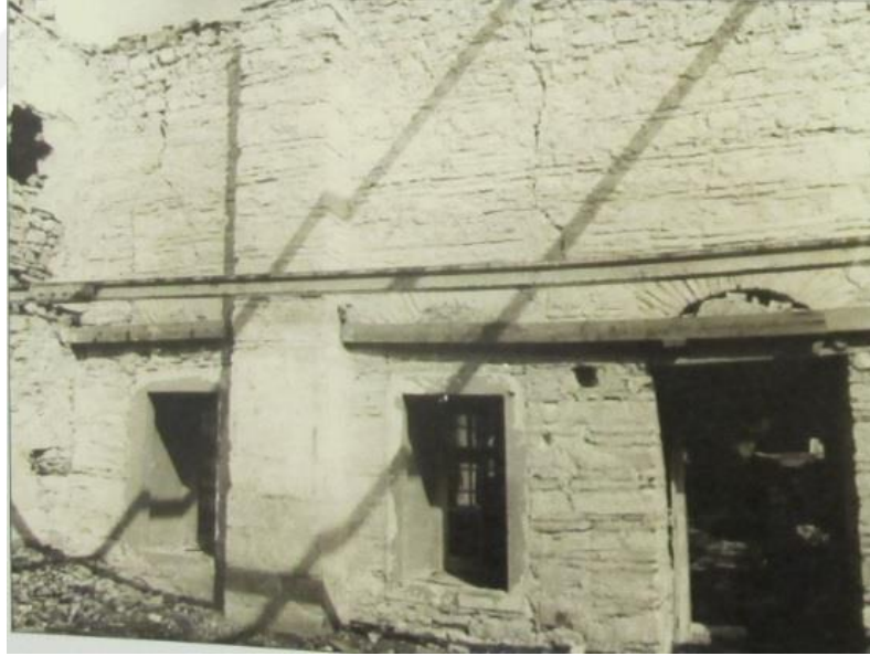
Şekil 3.134 : 1983 restorasyon sürecinde kuzey duvarı (VBMA).
