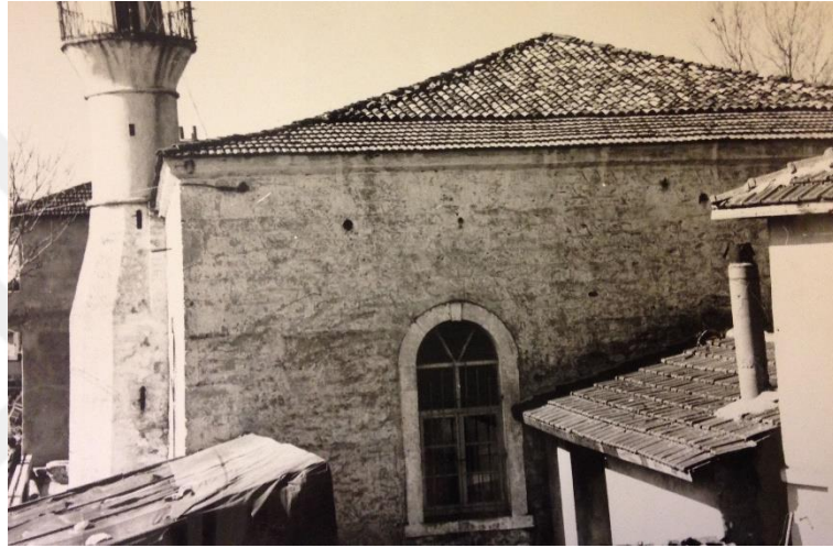
Şekil 3.6 : Çatının saçak kotu özgün olmakla birlikte çatı örtüsünün bir kısmının alaturka, bir kısmının Marsilya kiremit olduğu dikkati çekmektedir (VBMA).
