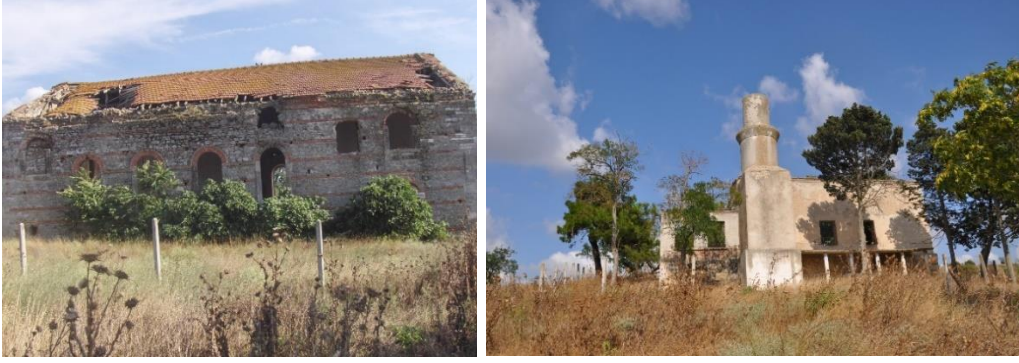
Şekil 5.8 : Heyelan sonrası atıl kalan Değirmenköy'deki kilise (solda) ve cami (sağda).
