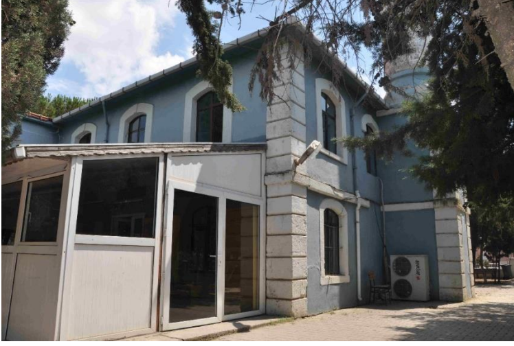
Şekil 3.108 : Kuzeybatı yönünden Ali Paşa Mahallesi Camisi'ne bakış.
