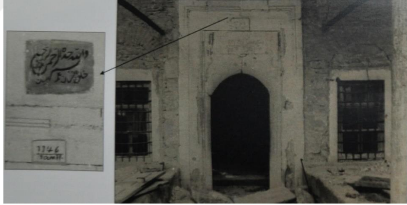
Şekil 3.122 : 1983 fotoğrafında giriş kapısı üzerindeki 1946 tarihli onarım kitabesi (VBMA).
