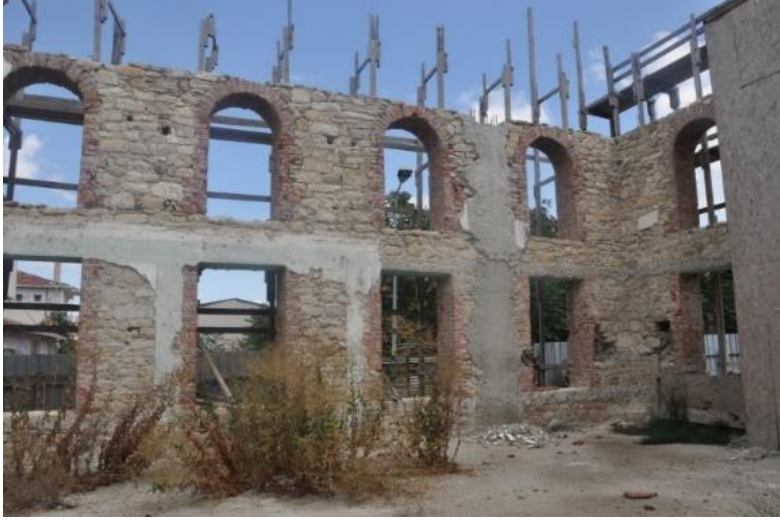
Şekil 3.247 : Kaleiçi Camisi'nin kuzeydoğu cephesinde raspa yapıldıktan sonra ortaya çıkan moloz taş duvar, tuğla söveler ve betonarme kolon ve kiriş sistemi (Küçük, 2016).
