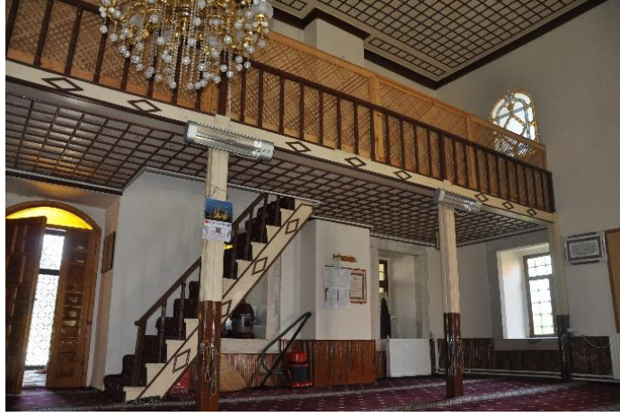
Şekil 3.135 : Batı duvarının günümüz durumu.
