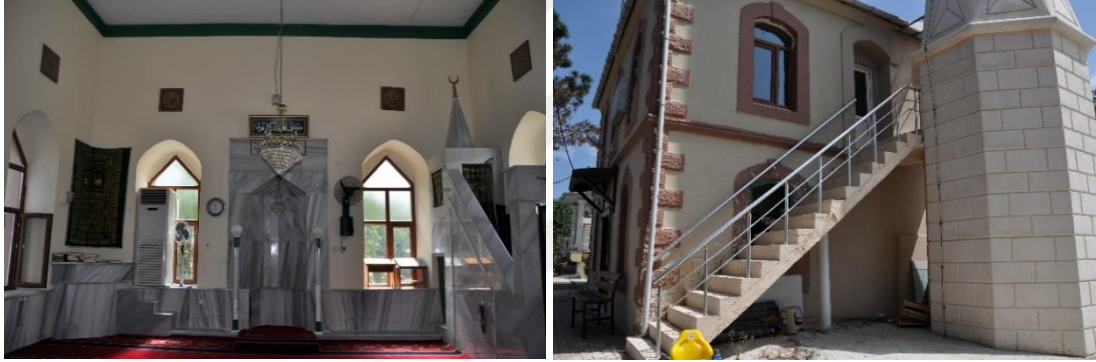
Şekil 4.11 : Caminin iç mekânında mermer kaplı mihrap, minber ve vaaz kürsüsü (solda) ve batı cephesi üzerinde muhdes merdiven ve üst kottaki kapı (sağda).
