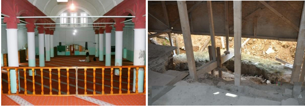
Şekil 3.239 : Boğazköy Camisi'nin 2011 yılında çekilmiş, restorasyon öncesi iç mekanı (solda) (KVKBKA) ve kazılarla ortaya çıkmış apsisin temeli (sağda).
