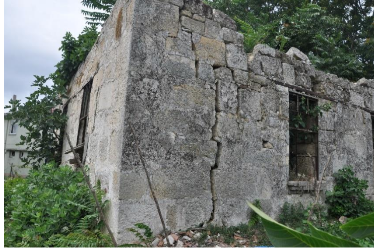
Şekil 2.22 : Anastasius sur taşlarından yapılmış olduğu, anıt fişinde ifade edilen Silivri’deki Bekirli Camisi.
