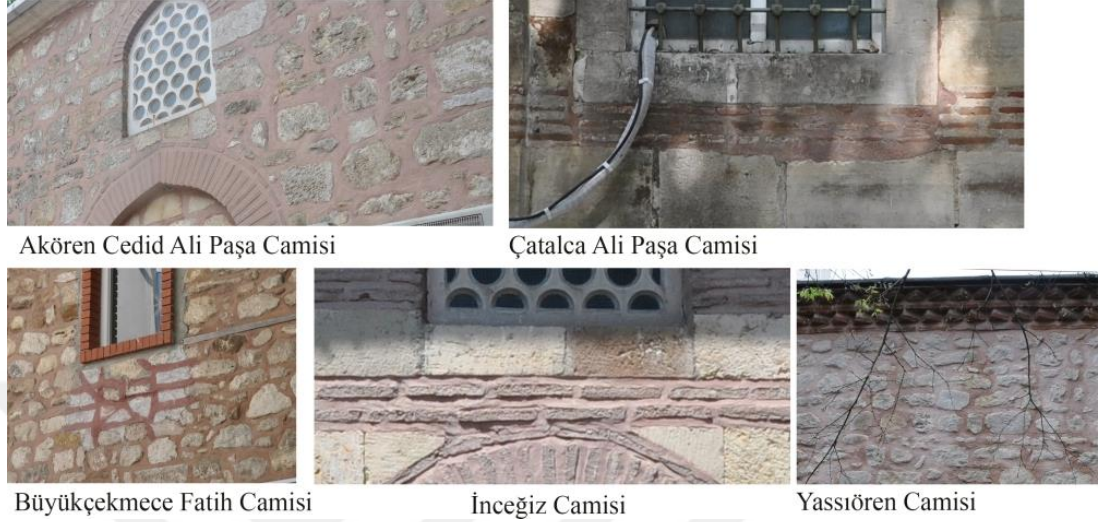
Şekil 5.5 : Çimento esaslı harç ile onarılmış camilerin cepheleri.
