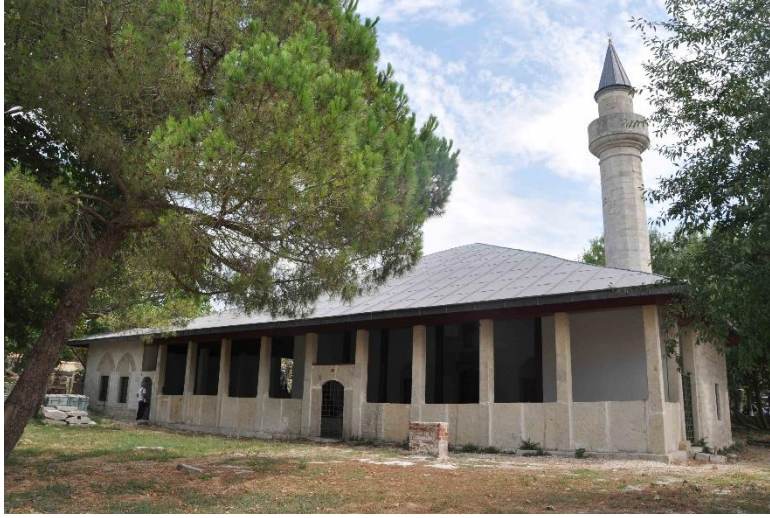
Şekil 3.50 : Baba Nakkaş Camisi kuzey (giriş) cephesi.
