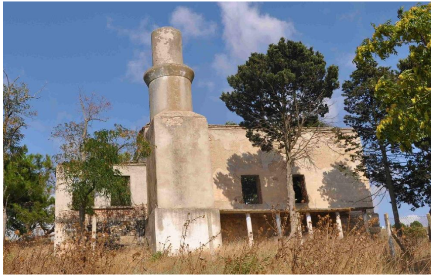
Şekil 3.184 : Değirmenköy Camisi batı cephesi.
