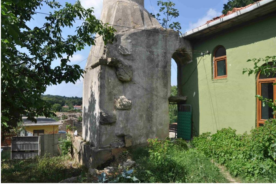
Şekil 3.72 : Minarenin güney cephesi üzerinde, eskiden burada duvar olduğunu işaret eden taşlar.
