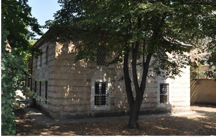
Şekil 3.45 : Sokollu Mehmed Paşa Camisi güney cephesi.
