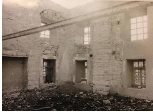
Şekil 3.133 : 1983 restorasyon sürecinde doğu duvarı (VBMA).
