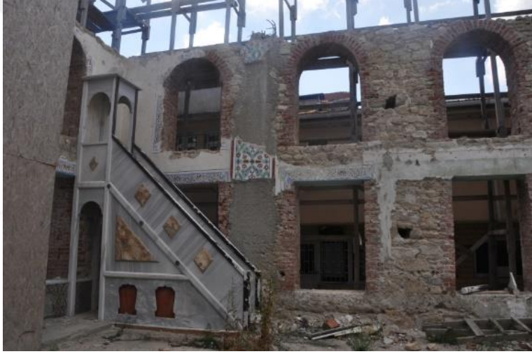
Şekil 3.248 : Kaleiçi Camisi'nin güneybatı cephesi, raspalı ve raspasız duvarlar (Küçük, 2016).
