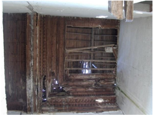
Şekil 3.228 : Değirmenköy Kilise-camisi'nin 2010 yılında çekilmiş kuzey cephesi ve özgün ahşap ara kat döşemeleri fotoğrafları.
