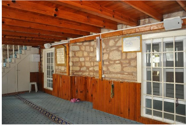
Şekil 5.4: Büyükçekmece Fatih Camisi'nin son cemaat yerine ara kat yapılmasıyla üst katta kadınlar mahfilinin genişletilmesi.
