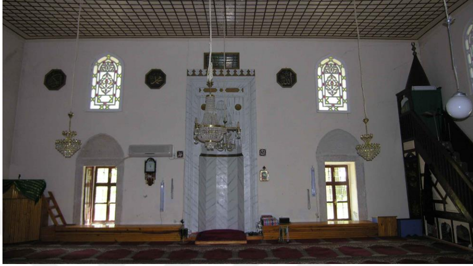
Şekil 3.58 : Restorasyon öncesi (2010) cami iç mekânı ve boya kaplı mihrap ve minber.
