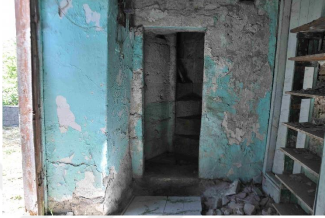
Şekil 3.164 : Çakmaklı Camisi'nin giriş kapısı (solda), minareye giriş (karşıda) ile kadınlar mahfiline giriş ve ayakkabılıklar (sağda).
