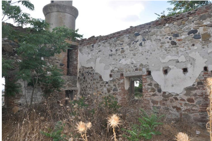
Şekil 3.186 : Değirmenköy Camisi iç mekânı, kuzey (sağda) ve batı (solda) cepheler. Harimin kuzey duvarı üzerinde, iki kanatlı kapıya ait olduğu düşünülen, 1.75 m genişliğinde 2.05 m yüksekliğinde kapı açıklığı, iki yanında 1 m eninde 1.4 m yüksekliğinde birer pencere, güney duvarında orta aksta mihrap, iki yanında diğerleriyle aynı boyutta ikişer pencere, doğu duvarında üç, batı duvarında iki pencere
