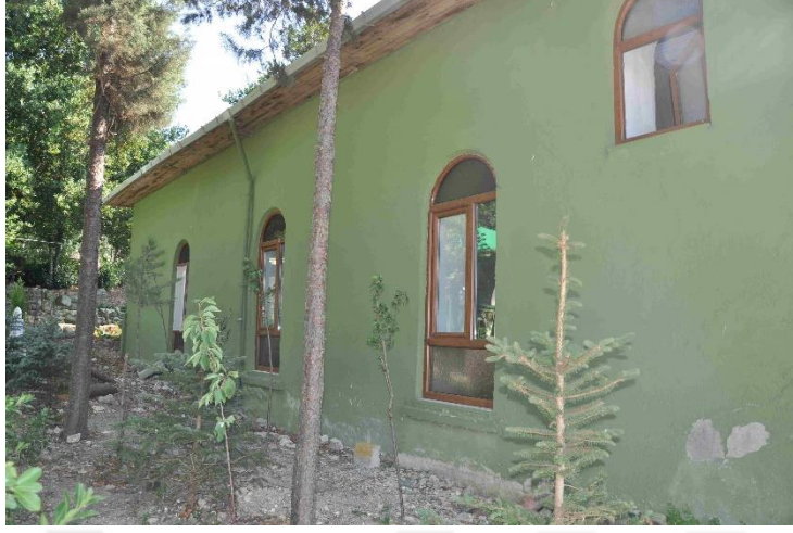
Şekil 3.69 : Kalfaköy Şeyh Sinan Camisi'nin doğu cephesi.
