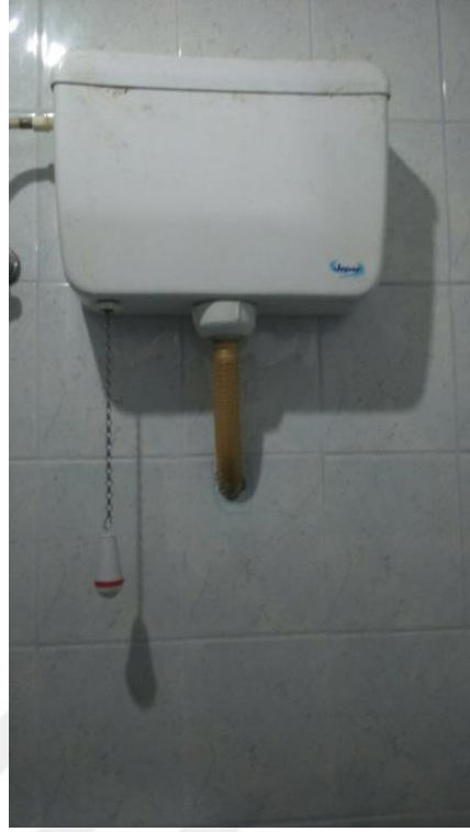
b. Mühendislik Fakültesi 2. Etap binasında kullanılan rezervuar tipi
