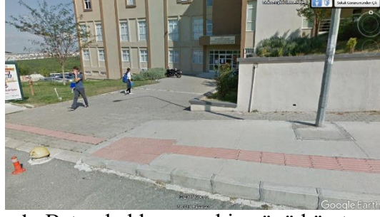
b. Beton kaldırım ve bina önu küp taş
