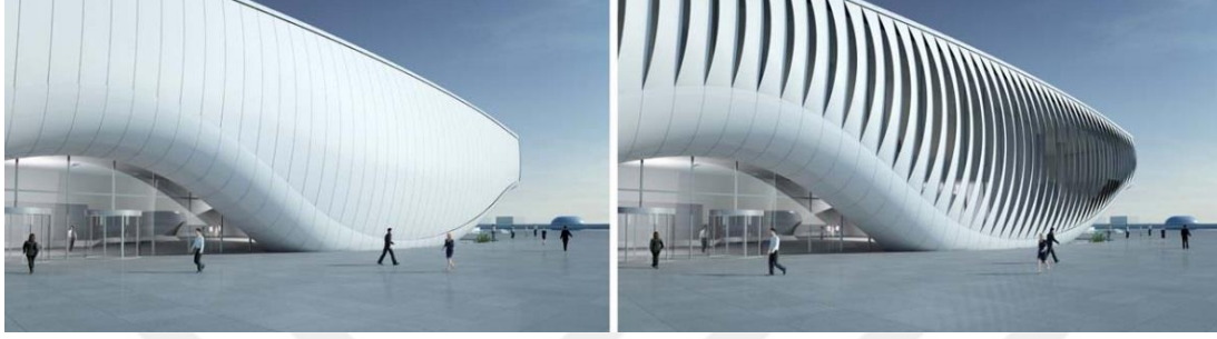
Şekil 3.56 : Ocean Thematic Pavilion, açık ve kapalı hareketli cephe panjurları, SOMA Architecture, Güney Kore (Url-18).
