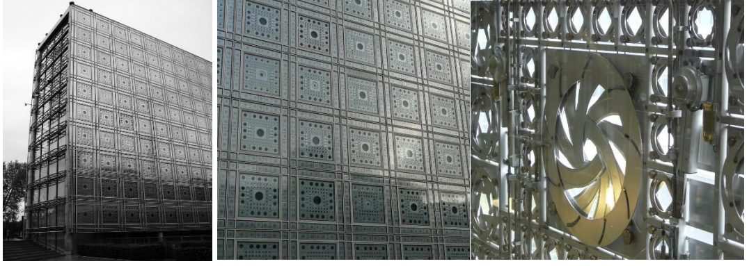
Şekil 3.44 : Arap Dünyası Enstitüsü genel cephe görünüşü ve cephe metal panel detayları (Url-17).
