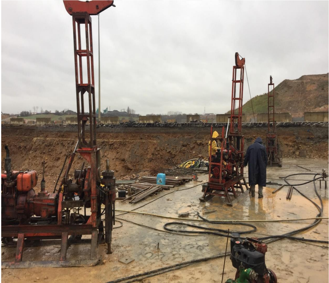
Şekil 2.9 : Çimento enjeksiyonu uygulanması. (Bağlantı tüneli çimento enjeksiyonu, 2016).
