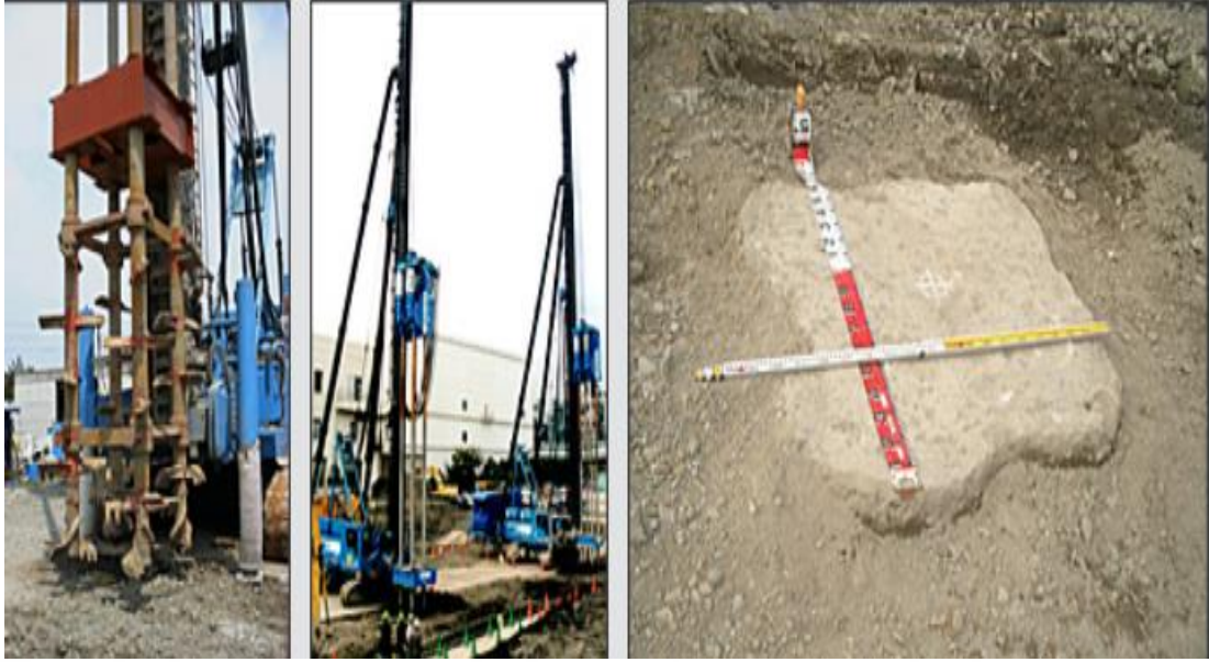
Şekil 3.6 : CDM-Land 4 yöntemi uygulama ekipmanları ve uygulanan zeminin görüntüsü. (Url-5)
