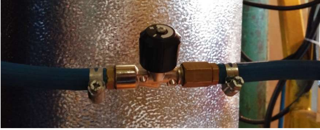
Şekil 3.3: Oksijen regülatöründen sonra debiyi kontrol etme amaçlı eklenen iğne vana.
