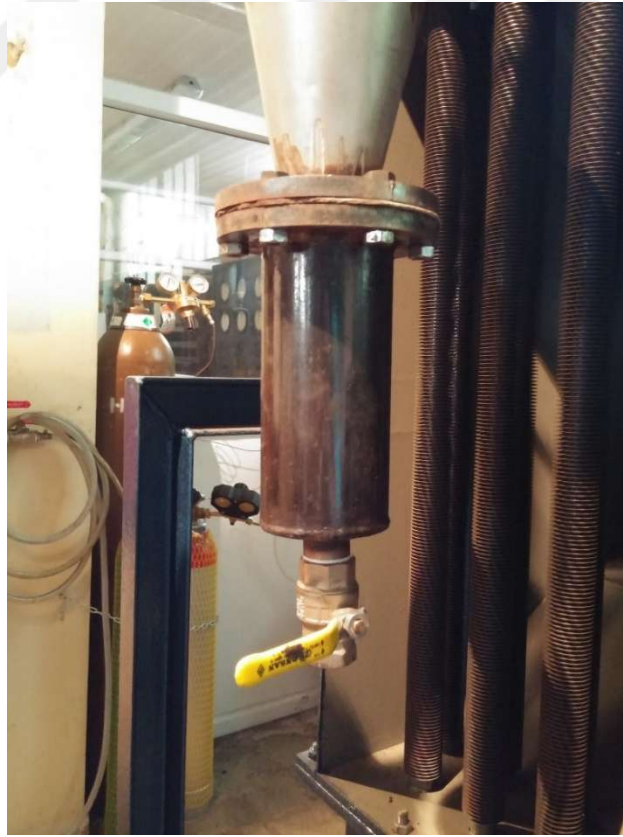
Şekil 3.7: Siklon ve arkasında soğutucunun montaj halinde görünümü.
