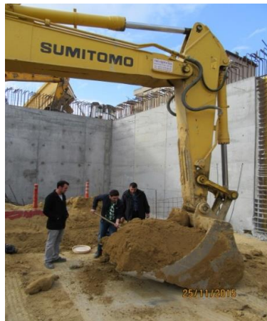
Şekil 5.45: Mahmutbey-Mecidiyeköy Tüneli Kazım Karabekir İstasyonu'ndan numune alınması.
