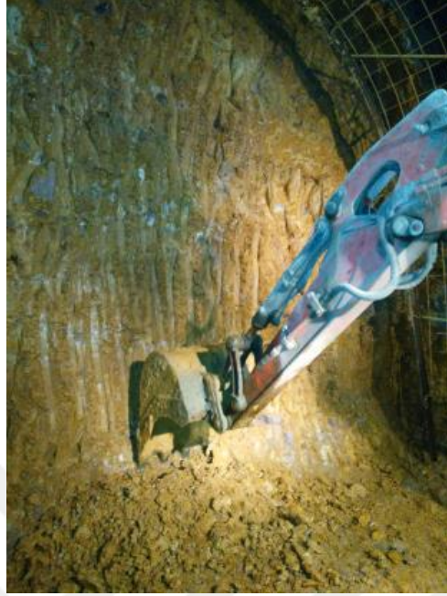
Şekil 5.41: Tuzla Akfırat Atıksu Tüneli S8-236 şaftı kuyruk tüneli aynasından numune alınması.
