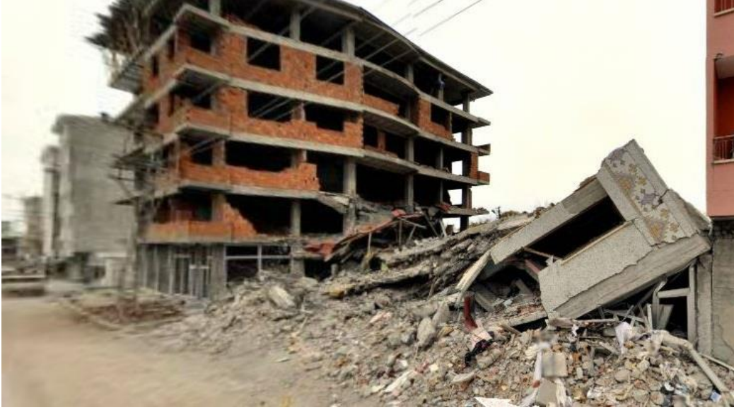
Şekil 2.4: Van-Erciş depremi sonrası yıkılmamış ve yıkılmış betonarme tipi yapı örnekleri [85].
