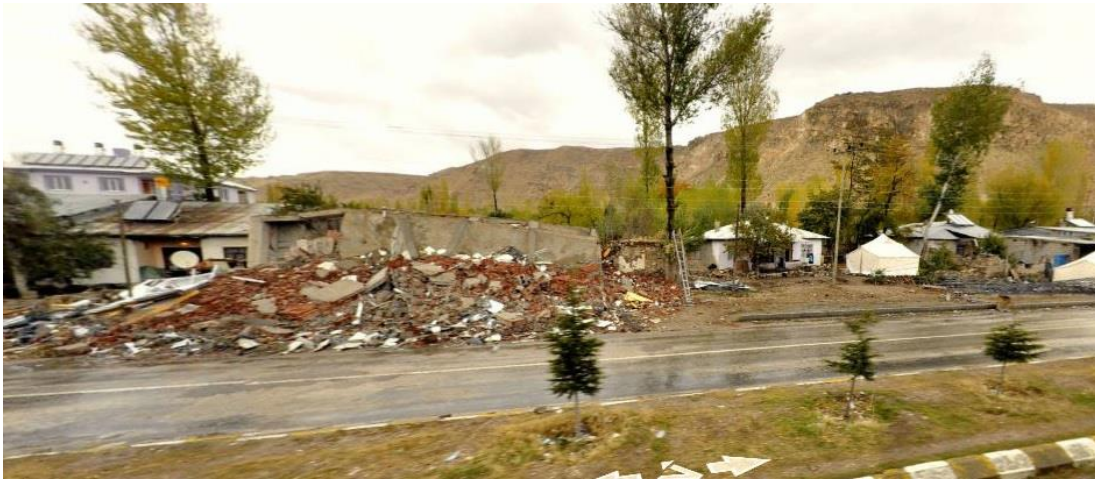
Şekil 2.5: Van-Erciş depremi sonrası köylerdeki yıkılmış bina örnekleri [85].
