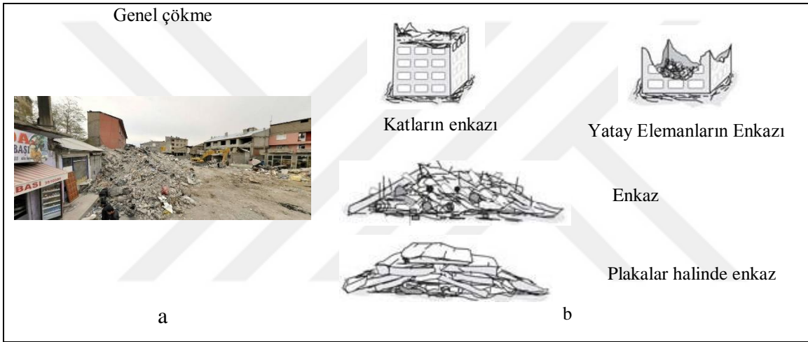
Şekil 2.8: Genel çökme. (a) Van-Erciş depremi sonrası genel çökme örneği.
