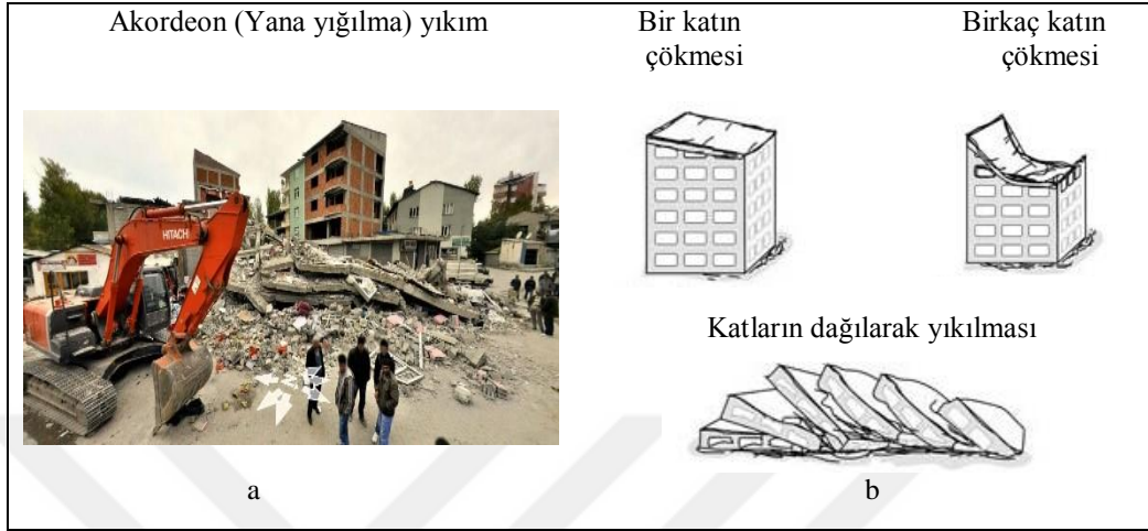
Şekil 2.9: Akordeon yıkım. (a) Van-Erciş depremi sonrası akordeon yıkım örneği. (b) Akordeon (Yana yığılma) yıkım türleri.
