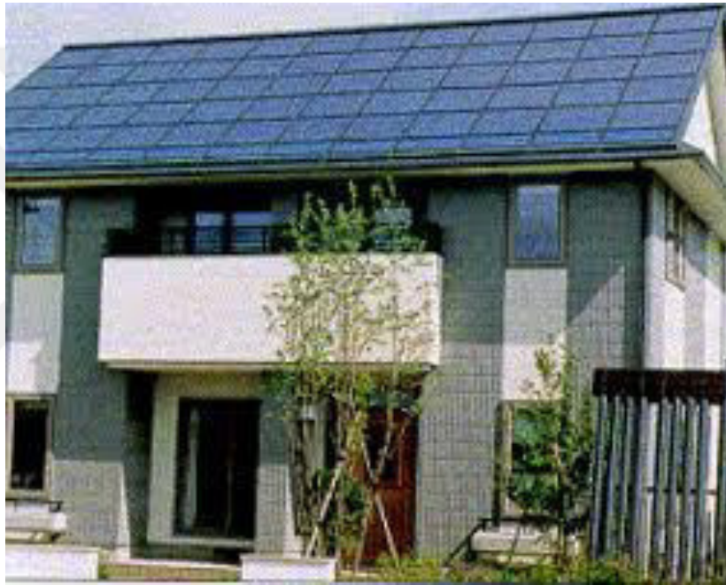
Şekil 3.8:Güneş pillerinin çatıya uygulanması [45].
