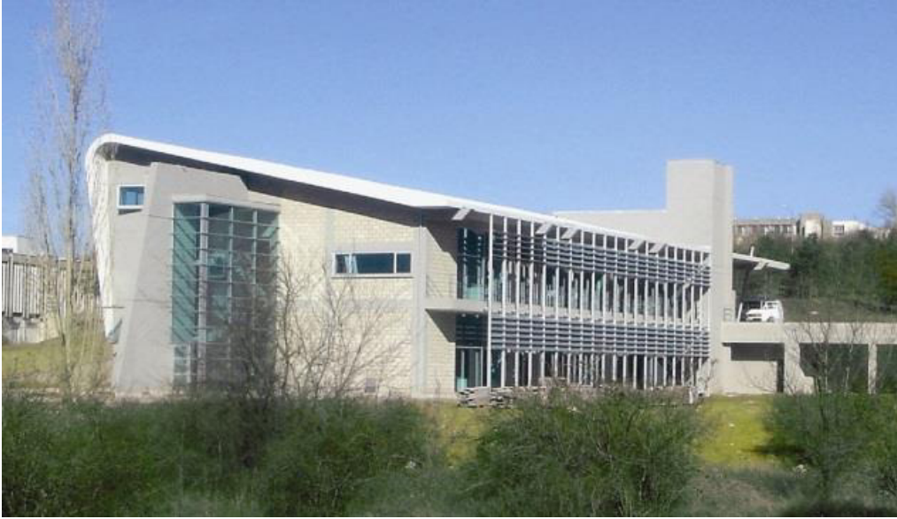
Şekil 3.9:ODTÜ Mimarlık Fakültesi Tasarım Planlama ve Araştırma Merkezi Güneş Kırıcılar
