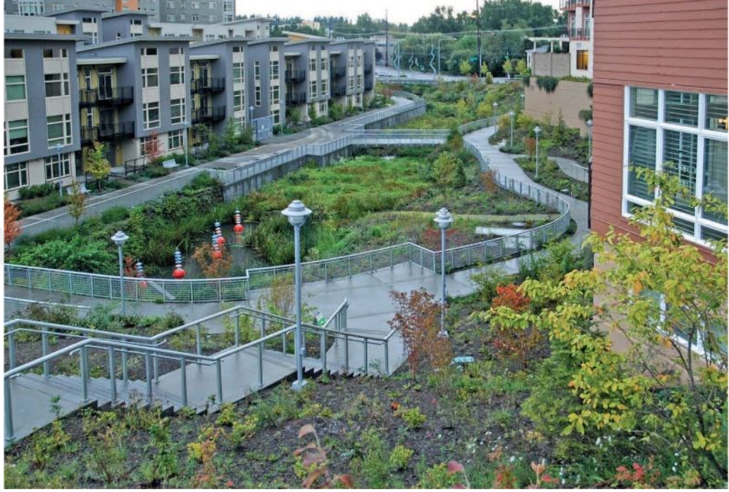
Şekil 2.1 : Kentsel ortamda dere kenarı rekreasyonu ve sulak alan oluşturulması ile geliştirilen yeşil altyapı örneği, Thornton Creek, Seattle/Washington (Austin, 2014a).
