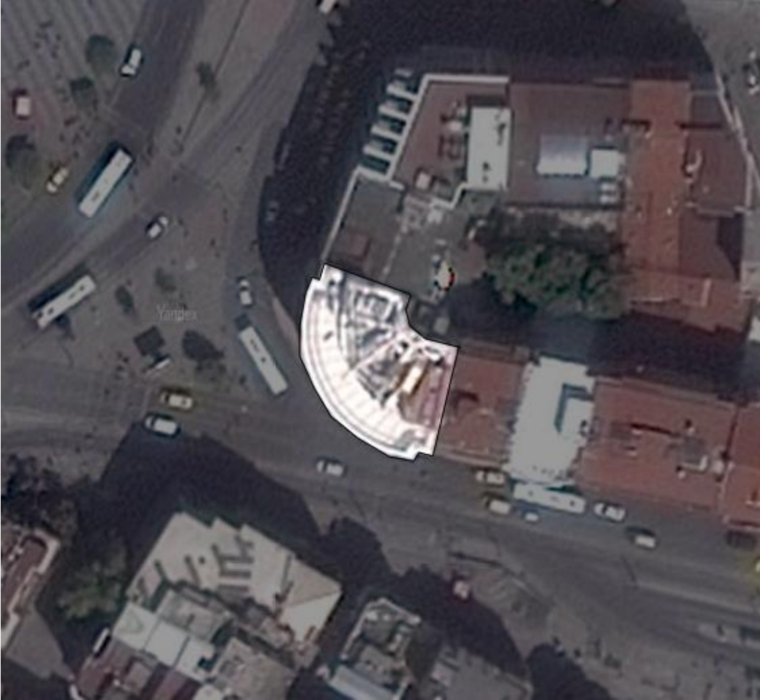
Şekil 4. 32. TİB Kadıköy Şubesi (Yandex Hava Fotoğrafı, 2019).
