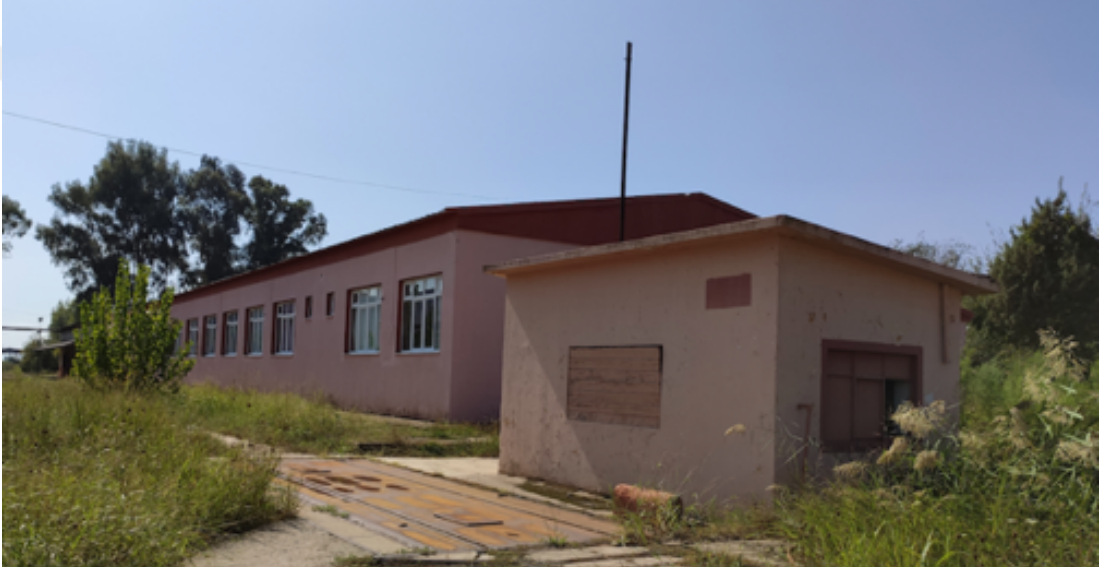
Şekil 4.19 : 17 Dersliğe dönüştürülen ambar binaları
