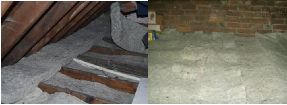
Şekil 3.18: İskoçya Newtongrange'deki Kır Evinde Çatı İyileştirmesi (Snow, 2018)
