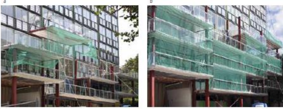
Şekil 3.8: Ekleme-Dış (Add-On) Stratejisi (Konstantinou, 2014).
