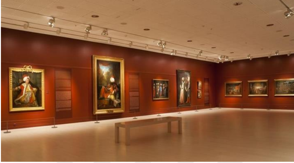
Şekil 4.7. Pera Müzesinde eserler aydınlatılırken ray üzeri yönlendirilebilir aygıtlar kullanılmıştır (URL-17).
