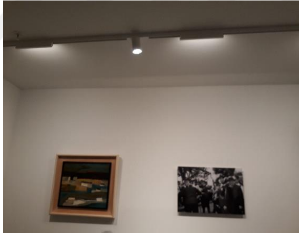
Şekil 5.11. Galeri 3 sergi mekânı yapma aydınlatma kurgusu, yönlendirilebilir ve duvar boyama aygıtları (Fotoğraf, Özgür, P.C. 2018).
