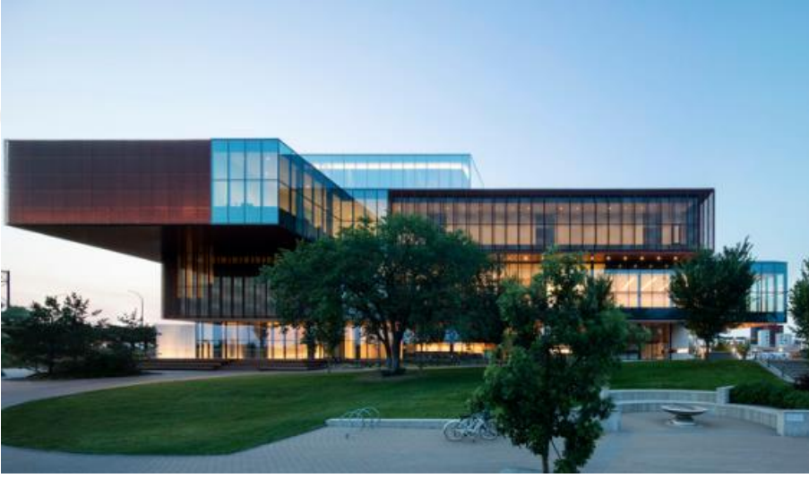
Şekil 2.9. Remai Modern Sanat Müzesi dış cephe fotoğrafı (URL-10).
