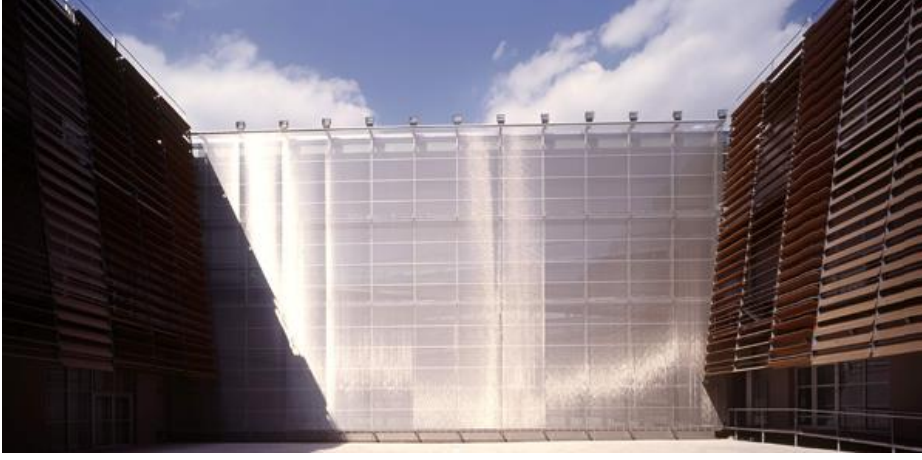
Şekil 4.4. Benaki müzesinin avlu cephesinde kullanılan güneş kontrol sistemi (URL-15).
