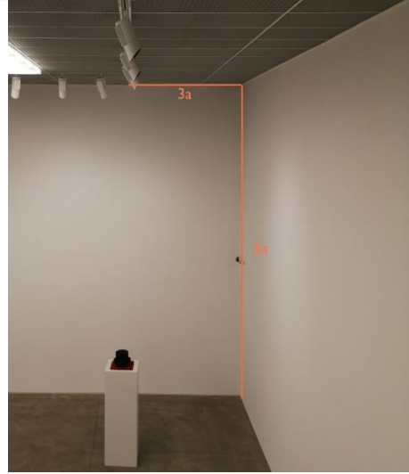
Şekil 5.19. Yönlendirilebilir aygıtların eserlerin olduğu duvara olan uzaklığı (Fotoğraf, Kömürcü, D, 2019).
