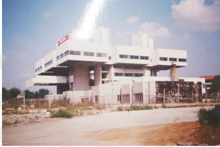
Şekil 3.49 : Ek bina inşaat halindeyken (ZBA).
