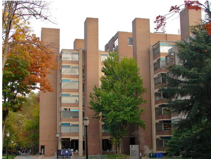
Şekil 3.23 : Richards Tıbbi Araştırma Binası cephesinde kulelerin kütleli olarak cephedeki belirleyici etkisi (Url-5).
