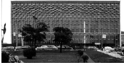
1956-69-77, İstanbul Atatürk Kültür Merkezi, İstanbul Mimarlar: Hayati Tabanlıoğlu yönetiminde Bayındırlık Bakanlığı Bürosu
