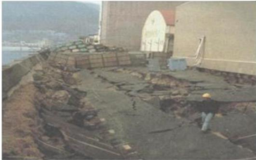
Şekil 2.18 : İstinat yapısı yenilmesi (Lai, 1998).
