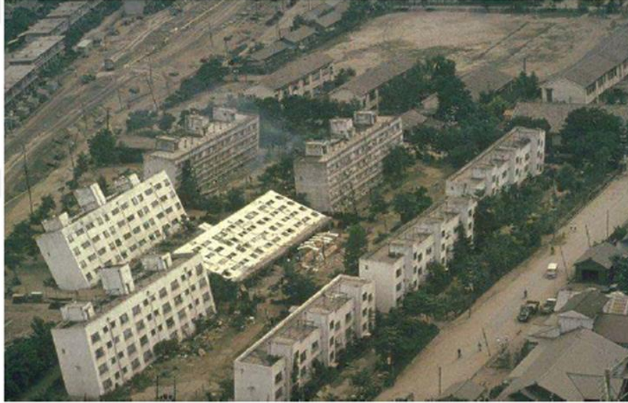
Şekil 2.15 : 1964'de Niigata'da yaşanan depremde sıvılaşma kaynaklı taşıma gücü kaybı sonucu yapıların devrilmesi (Day, 2002).
