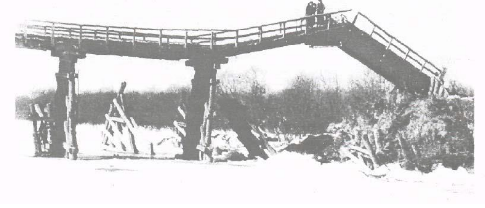
Şekil 2.2 : Alaska (1964) depreminde sıvılaşma sonucu köprüde oluşan hasar (Kramer, 1996).
