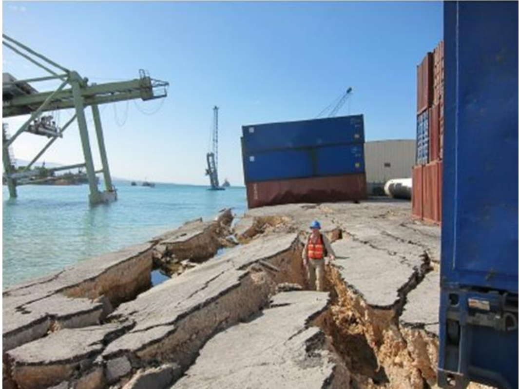
Şekil 2.23 : Haiti'de 2010 yılında yaşanan deprem sonucu oluşan yanar yayılma (Desroces vd., 2011).
