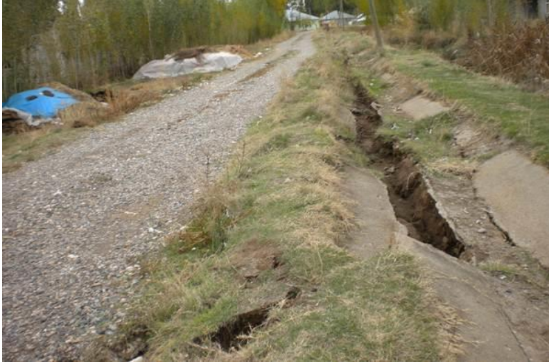
Şekil 2.3 : Van (2011) depreminde sıvılaşma ve yatay deformasyon örneği (İTÜ/EEDMI, 2011).
