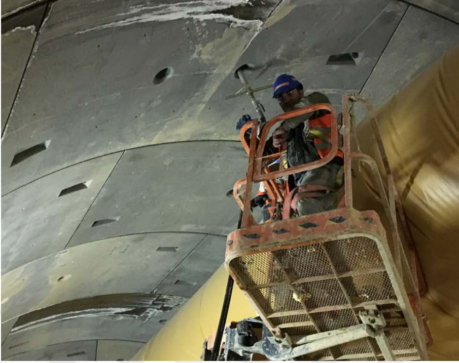
Şekil 4.25: Dolgu enjeksiyonunun uygulanması.
