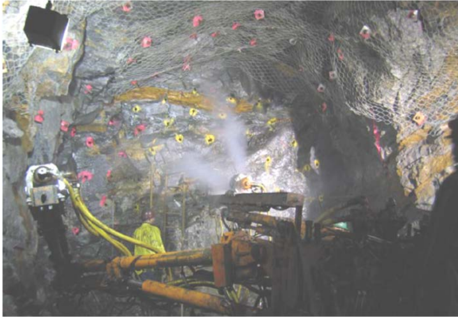
Şekil 2.1: Del patlat yöntemi delgi işlemi [27].
