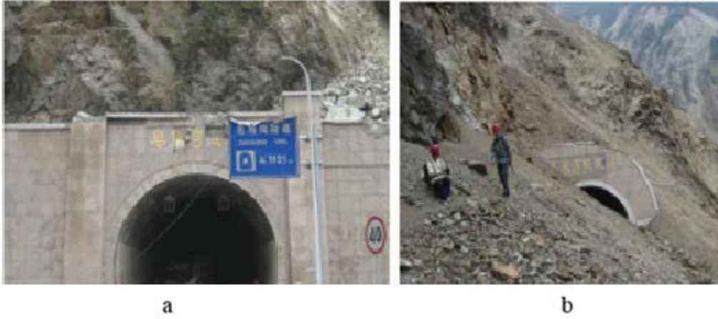
Şekil 4.8: a) Wenchuan depreminde şevde kaya düşmesi, b) kaya kayması [30].
