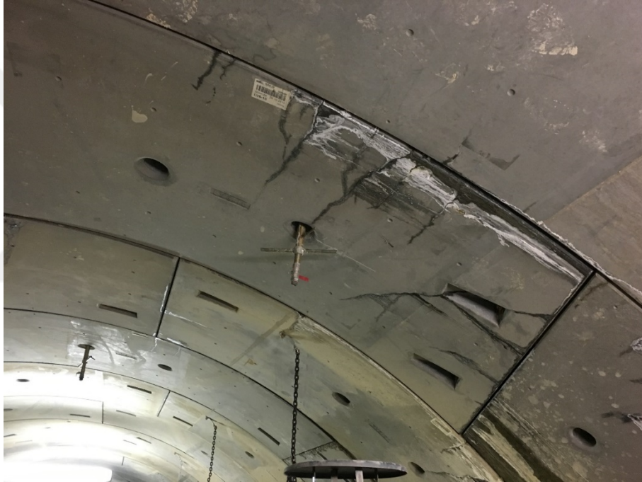
Şekil 4.24: 40 mm çaplı Enjektör yerleştirilen yerlerden biri.
