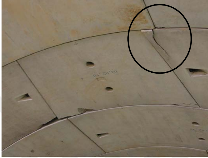
Şekil 4.18: Onarılması gereken köşe kırığı örneği.
