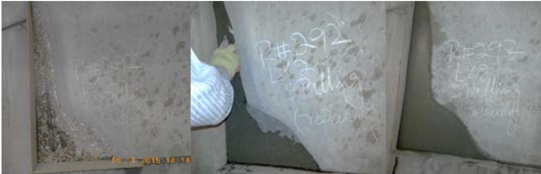
Şekil 4.19: Köşe kırığının onarım aşamaları.
