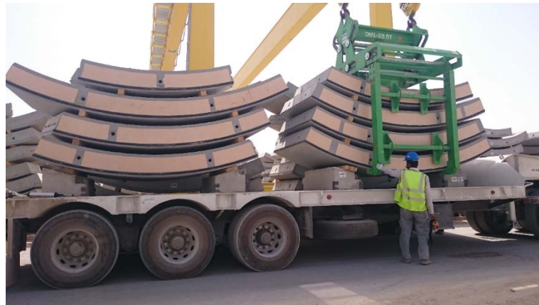
Şekil 4.1: Betonarme prekast bölütlerin taşıyıcıya yüklenmesi [22].
