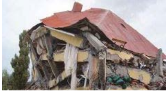
Şekil 3.13 : Katların üst üste yığılması sonucu yıkılan binalar.
