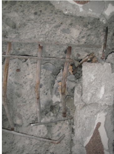
Şekil 4.5 : 90° bükülmüş ve boyu kısa olan etriye kanca örneği.
