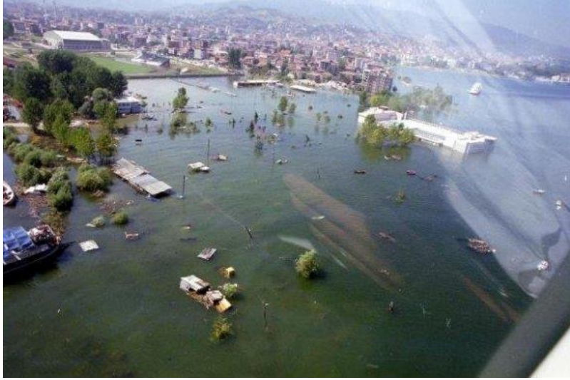
Şekil 3. 57: Gölçük'te Deprem Sonucu Meydana Gelen Yanal Yer Değişirmeden Ötürü Su Altında Kalan Kıyı Bölgesi ( http://www.ntv.com.tr/turkiye,2017 )
